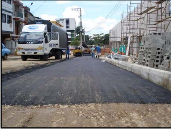
Figura 27. Estado final luego de la Aplicación de la carpeta de MDC-2
