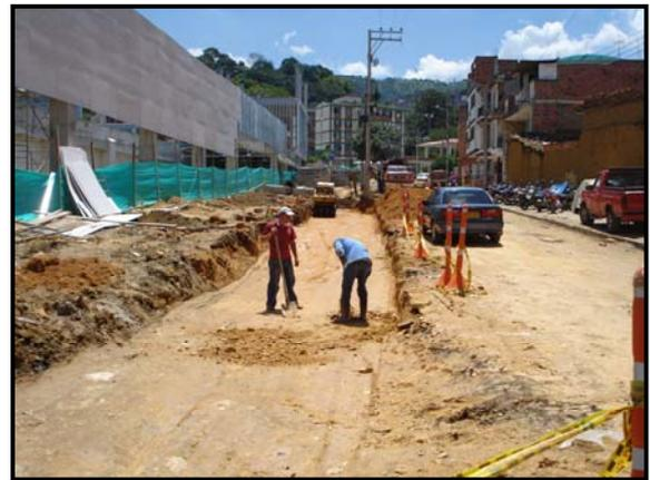
Después de verificar los niveles, el ingeniero residente da aviso a la planta de TECNOPAVIMENTOS S.A. para el despacho de Sub-Base Granular y coordina con los conductores de las volquetas que salen con escombros para que regresen cargados de Sub-base Granular.
