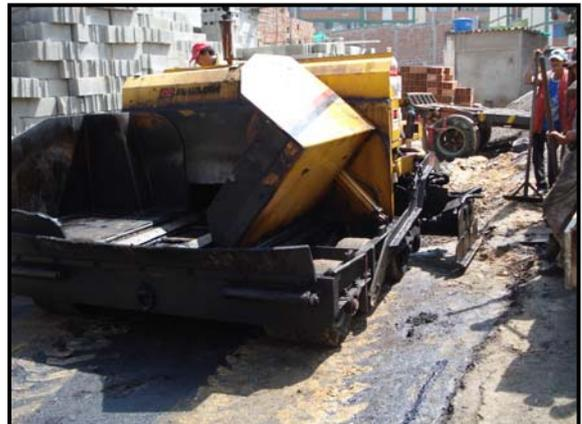
Luego de verificar los anteriores aspectos se da inicio al descargue del material a la tolva de la finisher SMITH MAULDIN (ver Figura 21) y se chequea la temperatura (ver Figura 22) luego se da inicio a su respectiva extendida. (Ver figura 23)
