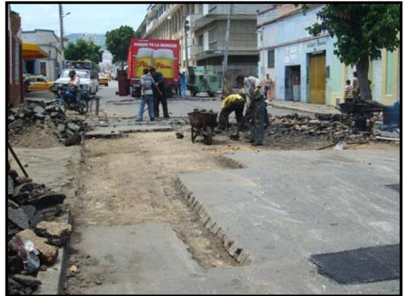
3. Verificar la limpieza de los cajones (ver Figura 33), es de importancia la correcta limpieza del cajón tanto en la capa de base como en las paredes ya que esto contribuye a la ligazón de la liga y la capa de pavimento. En esta instancia se hace la respectiva medición del área y del espesor del cajón.
