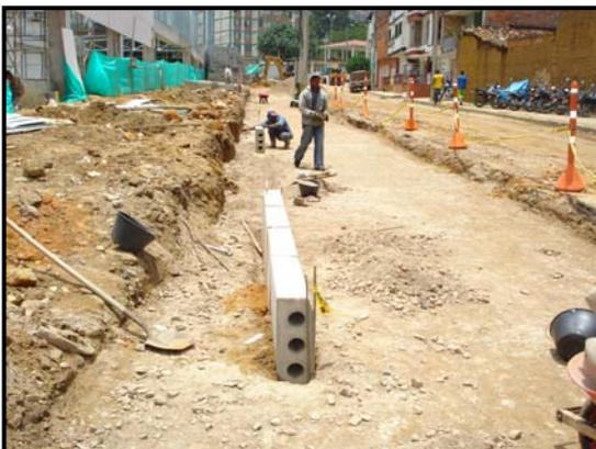
Figura 15. Construcción sumidero tipo SL 200.
