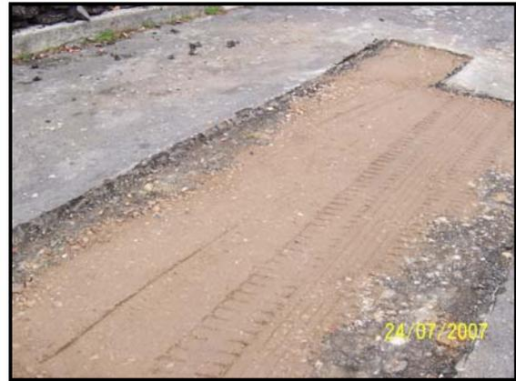
Se debe controlar la humedad de compactación de la Base granular con el fin de cumplir con la densidad máxima requerida y así garantizar la estabilidad del cajón luego de la aplicación del pavimento.
