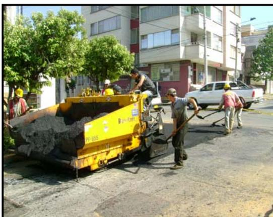
Figura 57. Extendida de la mezcla
