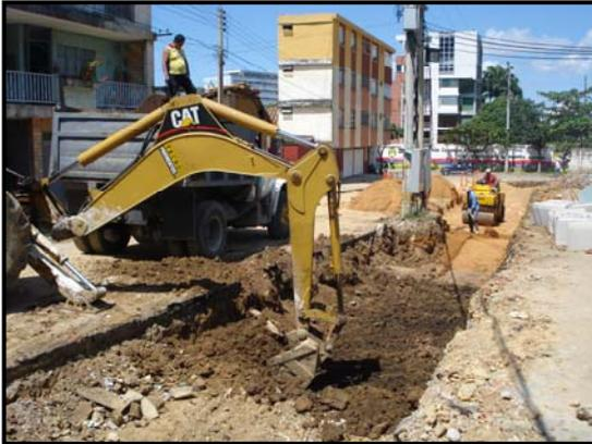
Figura 9. Retiro de escombros y compactación de material de relleno.
