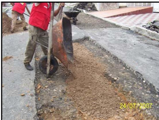
Figura 38. Reemplazo de Base Granular
