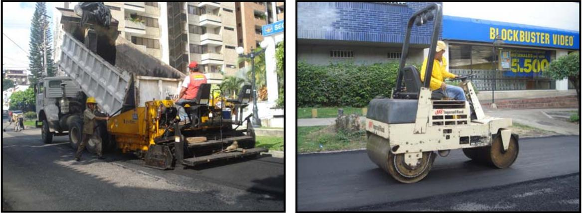
La coordinación de los tiempo de extendida y compactación permiten lograr la resistencia, estabilidad y uniformidad de la carpeta asfáltica.
