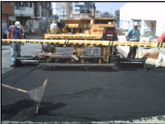
Figura 29. Extendida de la mezcla asfáltica.
