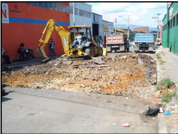
Figura 45. Demolición de pavimento.
