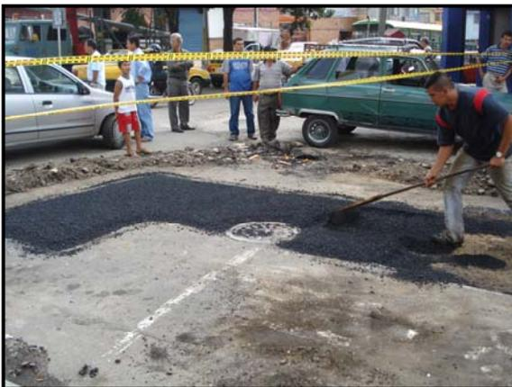
Figura 41. Compactación de la mezcla Asfáltica.
