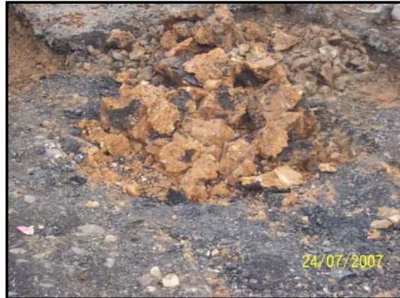
Figura 37. Reemplazo de Base Granular
