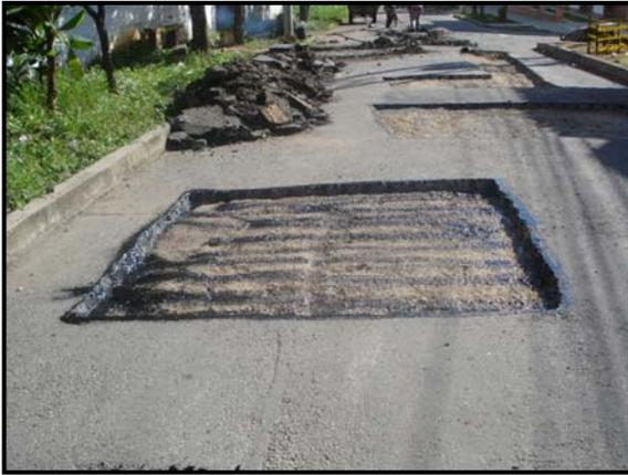
Figura 39. Cajón correctamente ligado.
