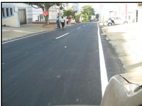
Figura 61. Reposición de la señalización vial
