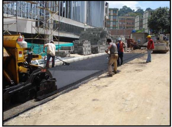
El ingeniero residente inspecciona la uniformidad en la aplicación de la mezcla posteriormente se toma la temperatura para iniciar la compactación. La temperatura mínima de compactación recomendada por la norma INVIAS en el Art. 450 es de 110°.
