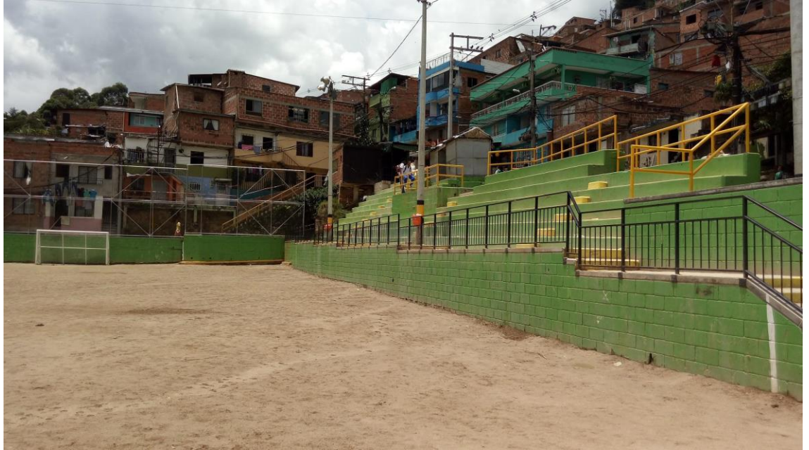
Figura 4. Foto de la cancha de los Mangos, en el barrio llanadas, cerca de la Institución Educativa Joaquín Vallejo Arbeláez. Fuente autoría propia.
