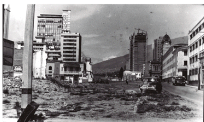
Imagen Número 9: construcción de Avenida Oriental
