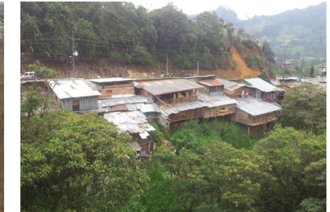
Fotografía: Construcción empírica de viviendas. Elaboración propia.
