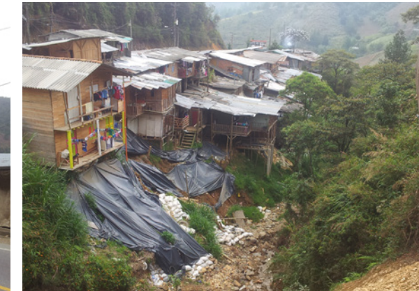
Fotografía: Viviendas en situación de riesgo. Elaboración propia.
