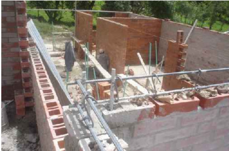
Figura 32. Detalle de refuerzo vertical de la mampostería y de la viga de amarre, todo con varilla de 1/2 pulgada.
