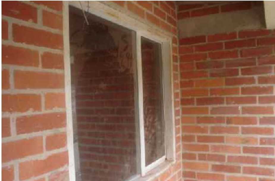
Figura 42. Detalle típico de las ventanas metálicas con vidrio instaladas tanto en la fachada principal como en la fachada posterior de las viviendas.
