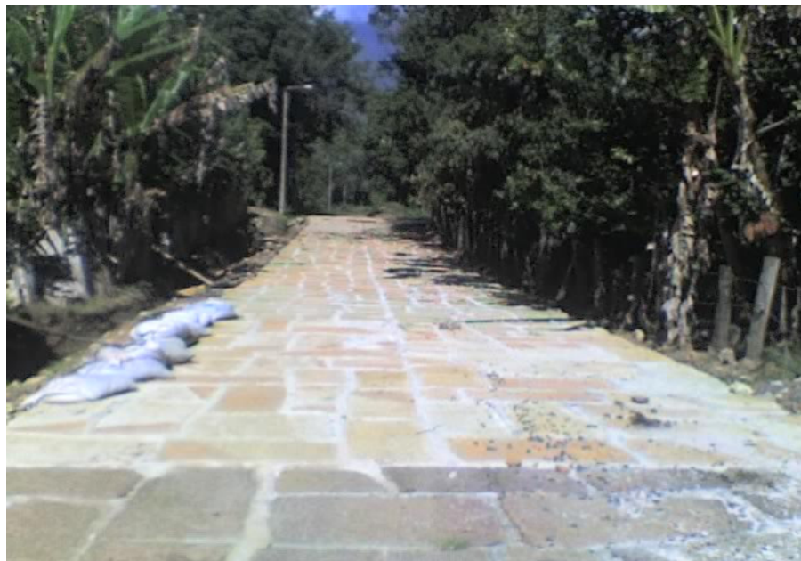
Figura 21. Luego de terminadas las labores en la Carrera 5 entre calles 1 y 2.
