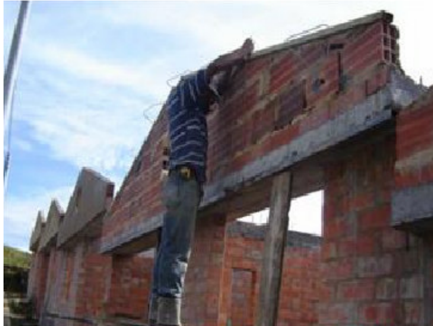
Figura 34. Levantamiento de la fachada en mampostería.
