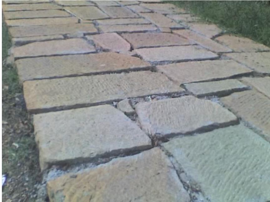
Figura 24. Instalación de piedra de la Calle 4 entre carreras 3 y 4.
