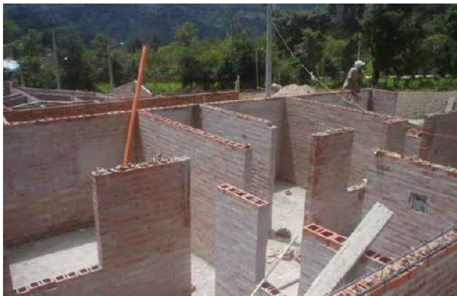
Figura 33. Se observa una vivienda con mampostería hasta el nivel de la viga de amarre, la cual se está armando con 2 varillas de 1/2 pulgada y flejes de 1/4 pulgada cada 20 cms.
