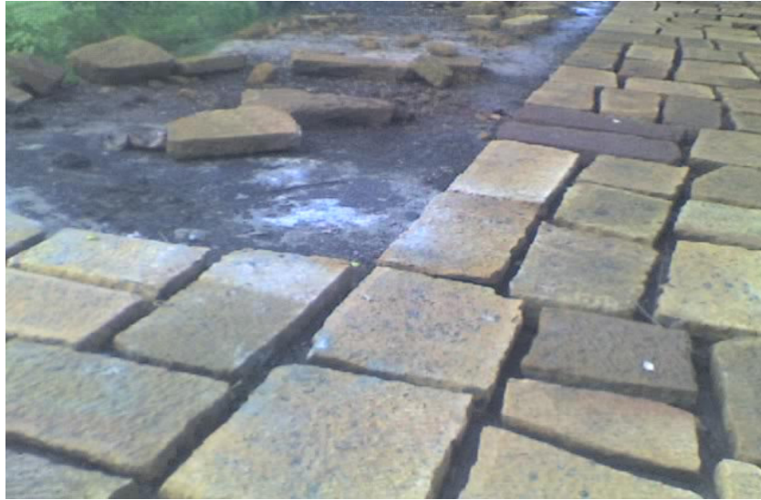
Figura 4. Instalación de piedra de Carrera 1 entre calles 4 y 5
