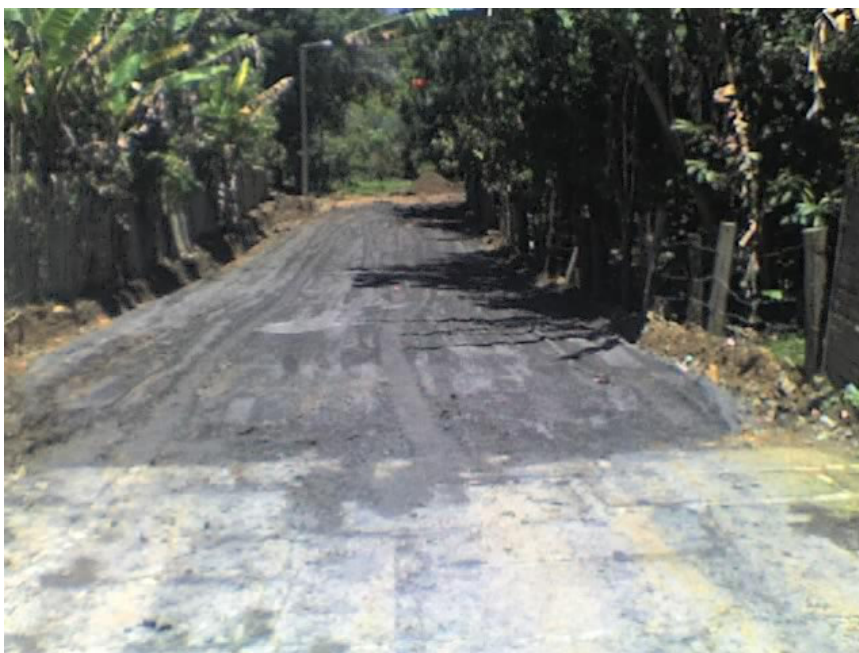
Figura 15. Estado de la vía luego del replanteo en la Calle 5 entre carreras 1 y 2.
