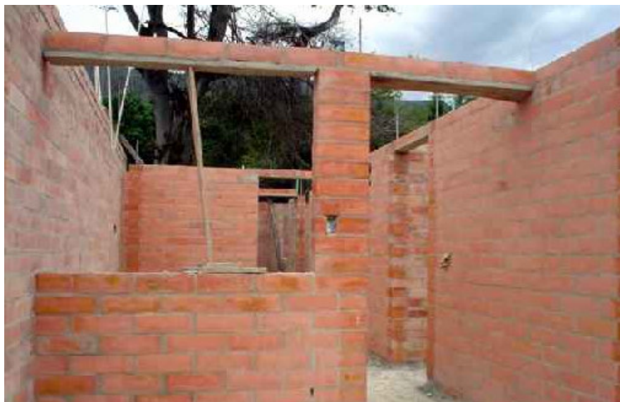
Figura 35. Detalle de construcción de dinteles.
