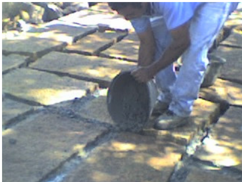
Figura 7. Emboquille de Carrera 1 entre calles 4 y 5
