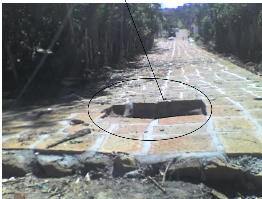
Figura 19. Localización pozo de aguas negras Calle 5 entre carreras 1 y 2.
