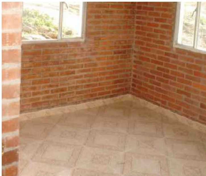
Figura 41. Detalle de enchape de pisos
