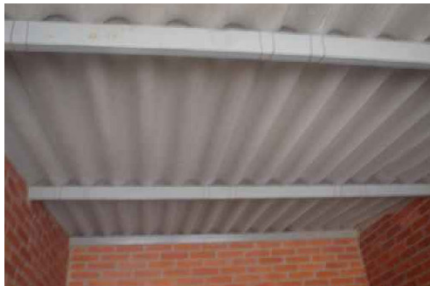
Figura 37. Detalle de la instalación de la cubierta en teja ondulada perfil 7, apoyada en correas metálicas.
