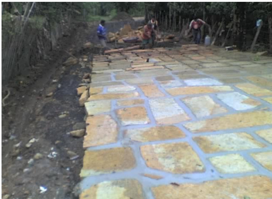
Figura 17. Instalación de material de afirmado Calle 5 entre carreras 1 y 2.
