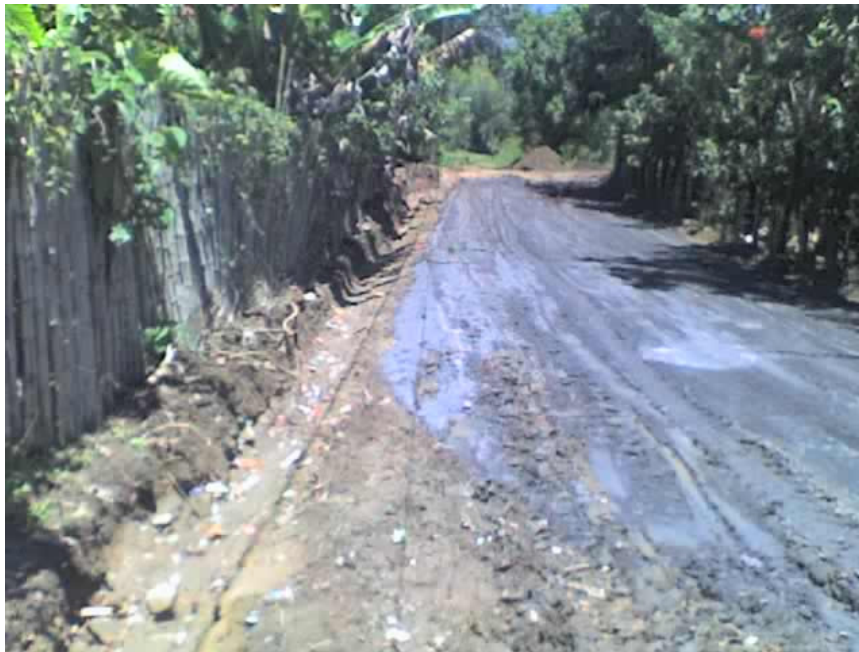
Figura 14. Zanja para el drenaje de aguas lluvias en la Calle 5 entre carreras 1 y 2.
