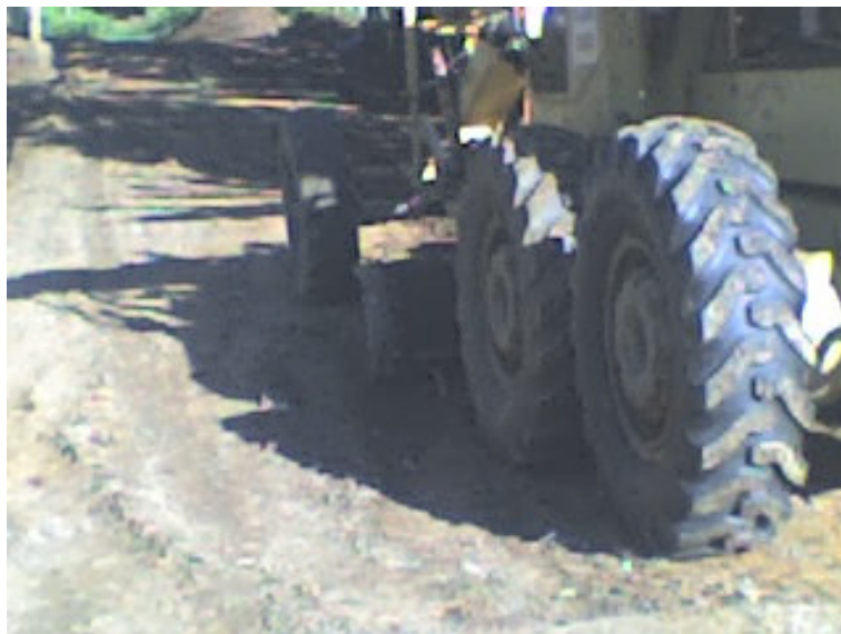
Figura 3. Replanteo de Carrera 1 entre calles 4 y 5
