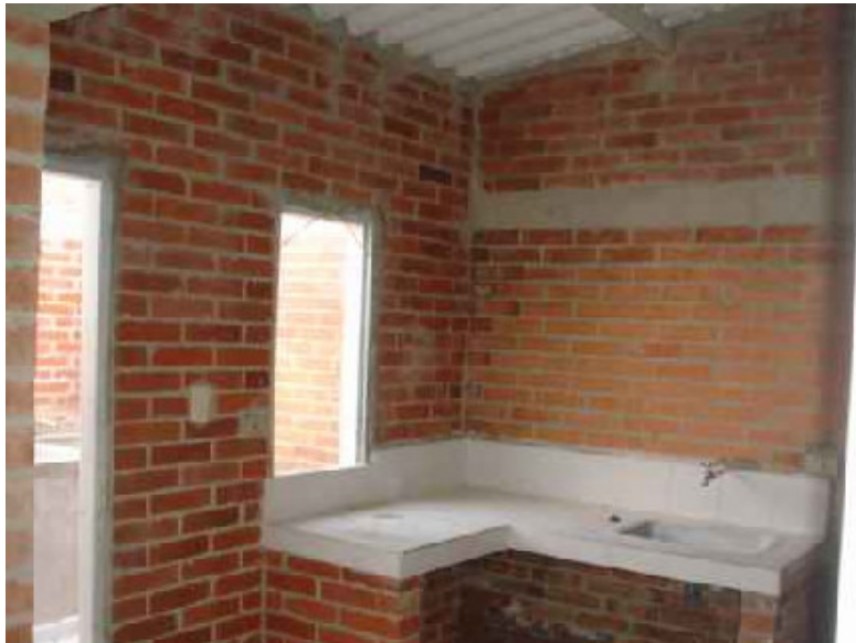
Figura 39. Detalle de conformación de mesón para cocina.
