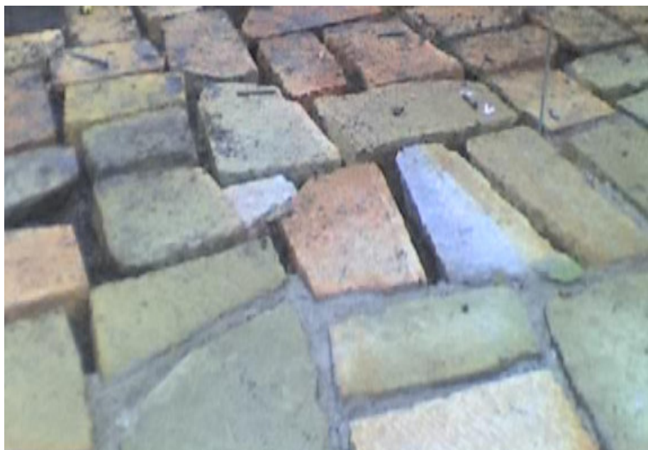
Figura 25. Instalación de piedra de la Calle 4 entre carreras 3 y 4.
