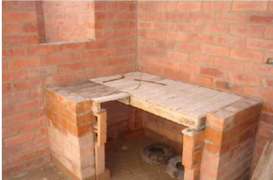
Figura 38. Mesón de la cocina en proceso de construcción.
