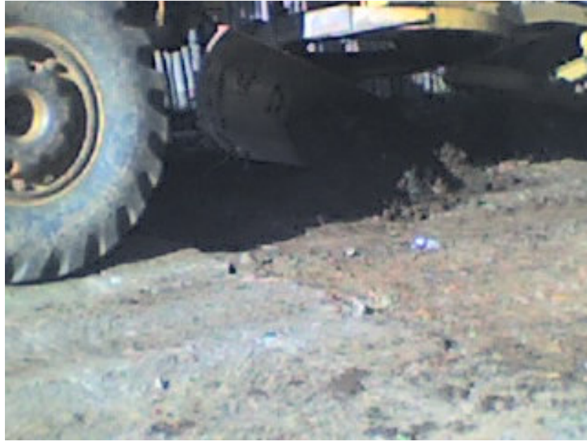
Figura 12. Nivelación del terreno en la Calle 5 entre carreras 1 y 2.
