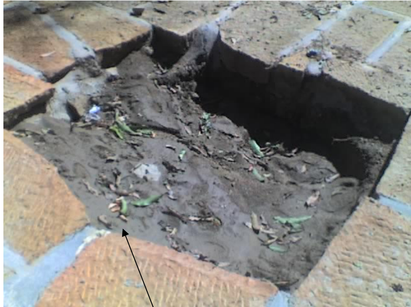
Figura 18. Detalle pozo de aguas negras Calle 5 entre carreras 1 y 2.
