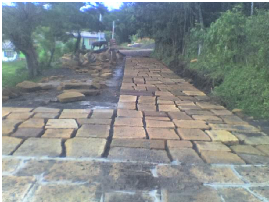
Figura 5. Parte del tramo instalado de Carrera 1 entre calles 4 y 5
