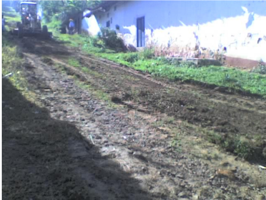
Figura 22. Replanteo de la Calle 4 entre carreras 3 y 4.
