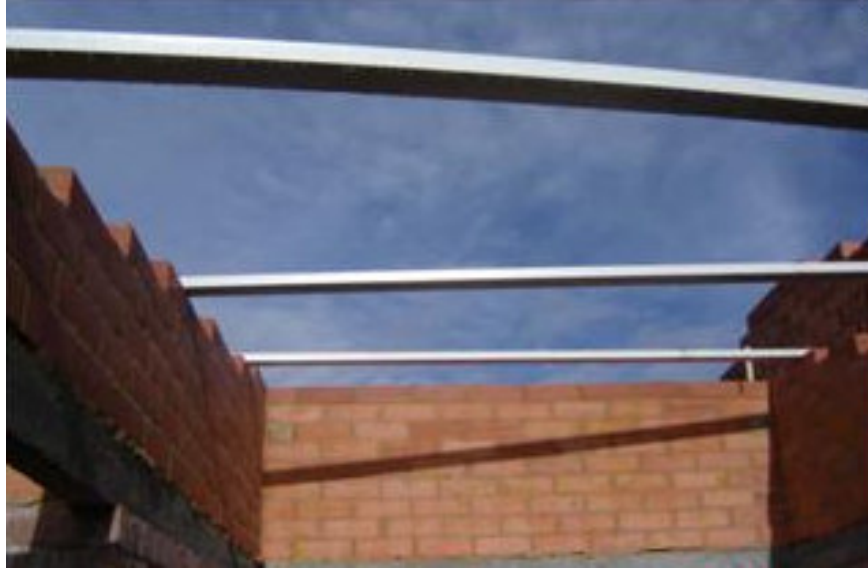
Figura 36. Detalle de la instalación de la cubierta en teja ondulada perfil 7, apoyada en correas metálicas.
