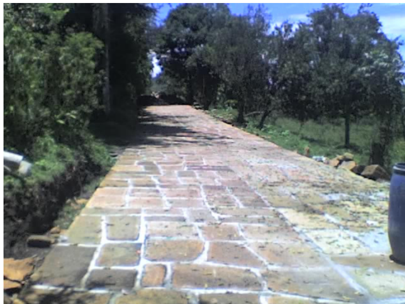
Figura 11. Estado de la vía luego de terminadas las labores de la Carrera 1 entre calles 4 y 5
