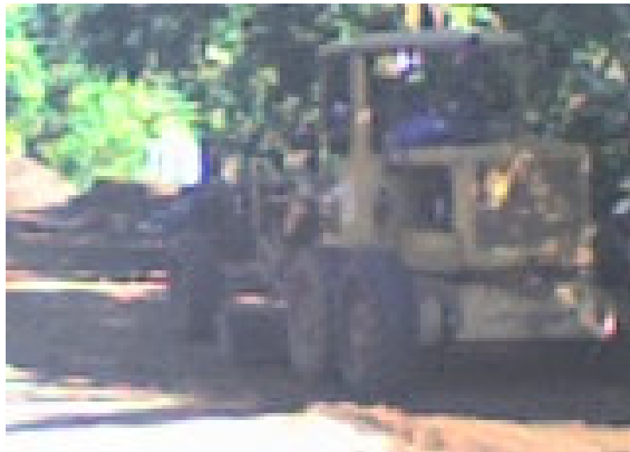
Figura 23. Nivelación de la Calle 4 entre carreras 3 y 4.
