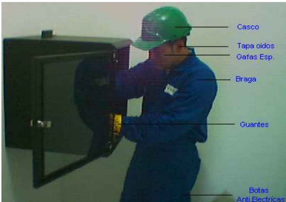
Fig. 55 Personal Técnico Manipulando Equipos de red.
