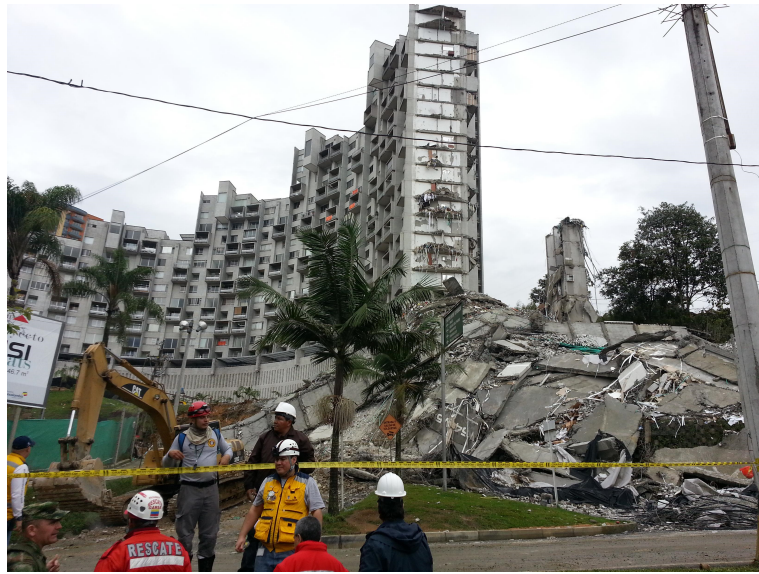
Figura 2.2: Colapso de la torre 6 del edificio Space en Medellín. Fotografía tomada el 13 de octubre de 2013, perteneciente al archivo del Departamento Administrativo de Gestión del Riesgo (DAGR) de Medellín.
