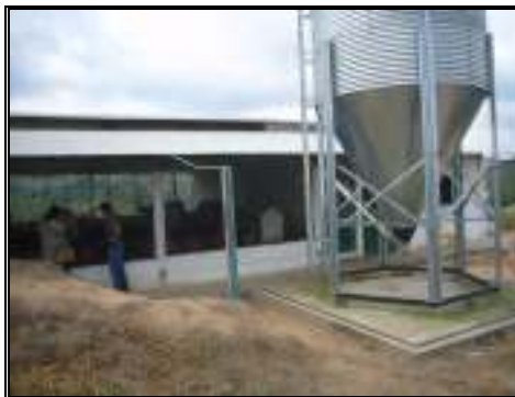
Foto 3. Vista Lateral del Galpón
