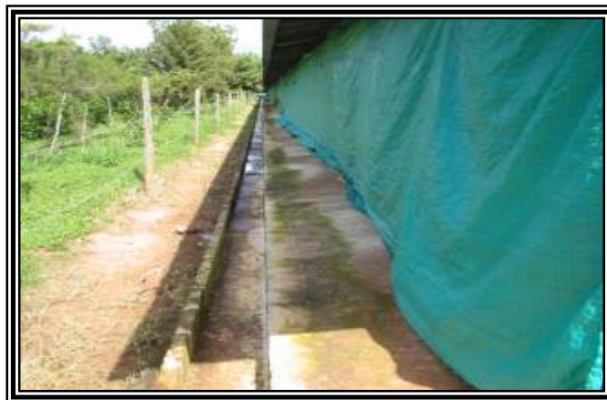
Foto 17: Canaletas Perimetrales a los Galpones avícola Tibigaro
