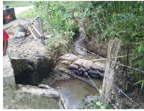
Foto 8. Construcción de diques para contención inicial de la mancha.
