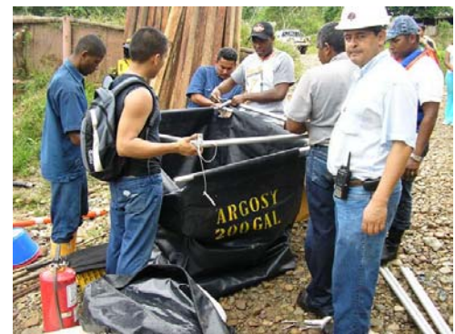
Foto 4. Armado del Fast Tank (capacidad de 200 galones).
