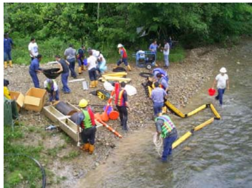
Foto 3. En la práctica se adecuaron barreras absorbentes, skimmer portátil, Fast Tank, entre otros.
