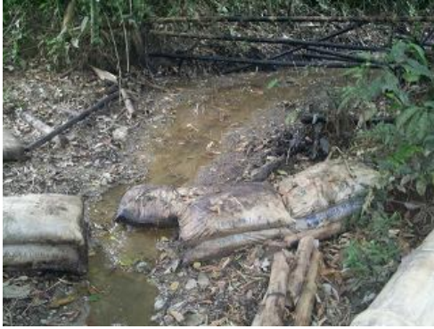
Foto 7. Construcción de presas para contención de mancha.
