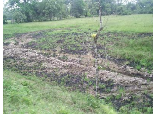
Foto 12. Drenajes para recolección y transporte de crudo a zonas de mejor acceso.
