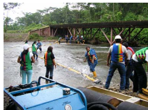
Foto 6. Instalación de barreras e indicaciones iniciales - Grupo 1.
