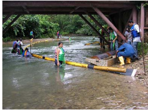
Foto 6. Instalación de las barreras mecánicas sobre el Río Picudo.
