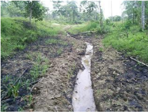
Foto 11. Adecuación de terreno para drenaje de crudo (método espina de pescado).
