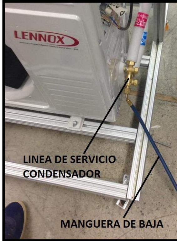
*Ilustración 25. Conexión de manguera de baja a línea de servicio del condensador (Tomado por los autores)*
