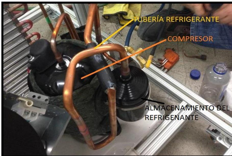
*Ilustración 17. Identificación de los elementos que componen el condensador.
