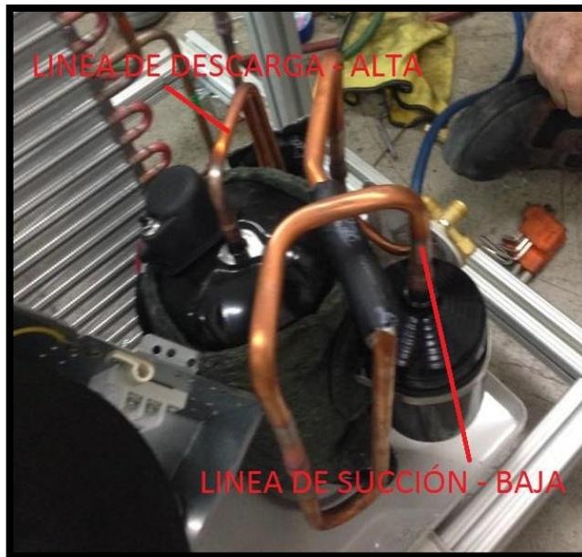
*Ilustración 14. Líneas de succión y descarga del compresor. (Tomado por los autores)*
