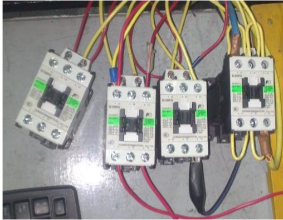
Figura 9. Conexión de 4 contactores al PLC
