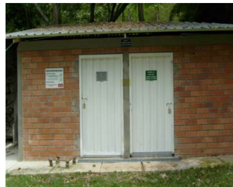
Figura 20: Cuarto de almacenamiento residuos no peligrosos
