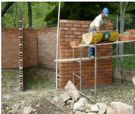
Figura 19: Etapa de construcción cuarto de residuos no peligrosos
