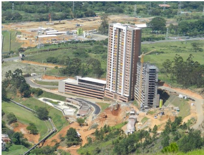
Ilustración 3. Florida Norteamérica, torre 8 finalizada y torre 7 en construcción.
