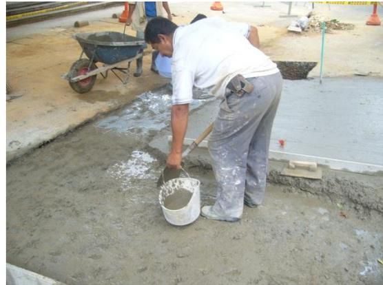
**Figura 9. Instalación del aditivo para adherir placas de concreto**
