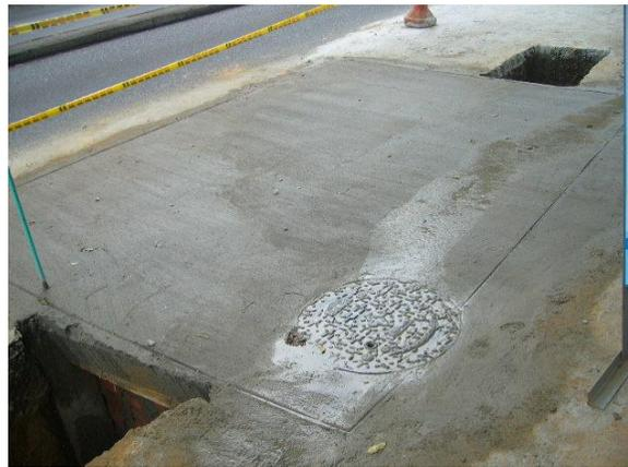
Figura 13. Terminación de la cámara e inicio de excavaciones de empalme
