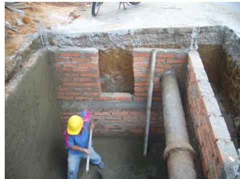
**Figura 7. Terminación de las actividades de construcción de la cámara**
