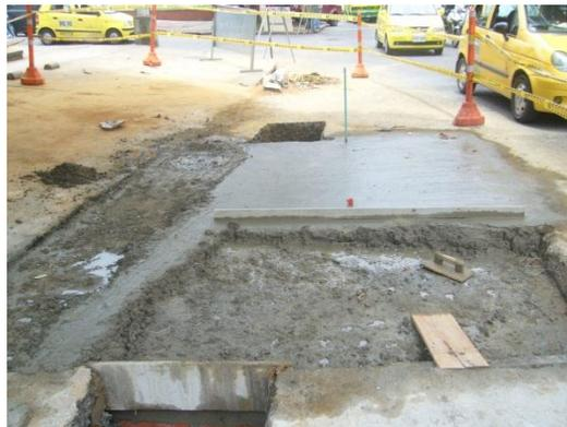
**Figura 10. Fundida de sobre placa para la cámara**
