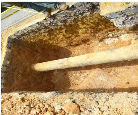
Figura 17. Terminación de la excavación para la cámara
