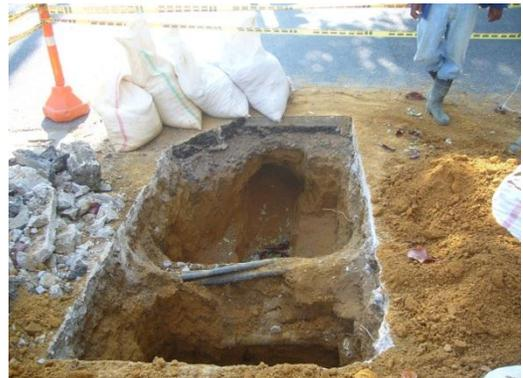
**Figura 5. Terminación del apique de localización de la tubería existente**
