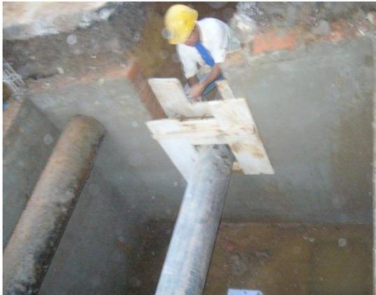
**Figura 8. Confinamiento de la tubería instalada dentro de la cámara**
