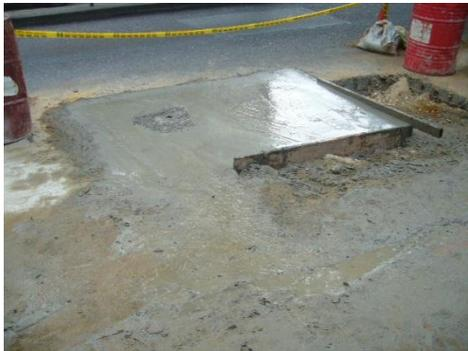
**Figura 20. Terminación de la placa tapa de la cámara**
