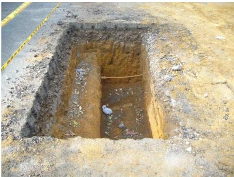
Figura 15. Excavaciones iniciales de la cámara
