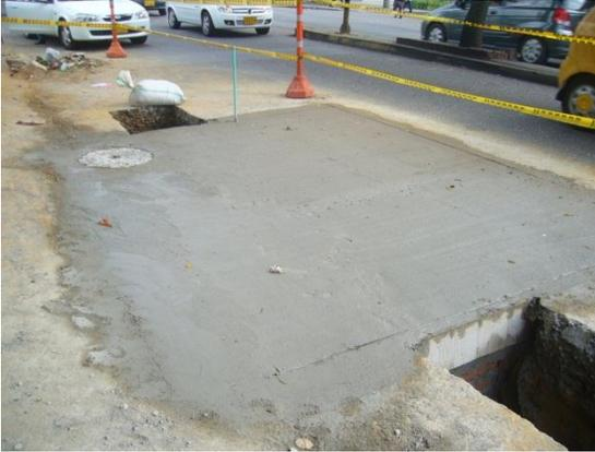
Figura 11. Terminación total de la cámara
