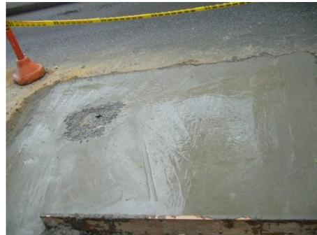
**Figura 21. Terminación de la cámara**
