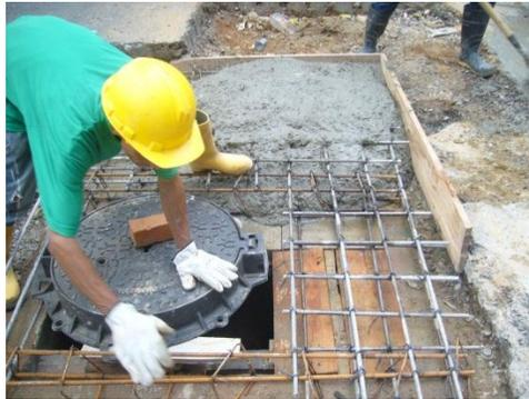
**Figura 19. Fundición de la placa de la tapa de la cámara**
