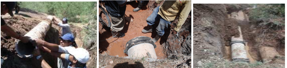
Fotografías 40,41 y 42. Instalación de tubo, Cople, Junta y Funcionamiento.
