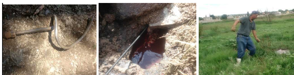
Figuras 16, 17 y 18. Sonda y Perforación de tubería.
