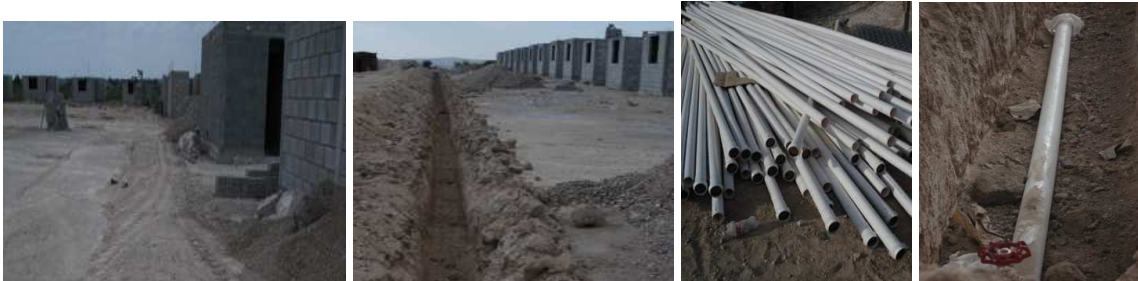
Figuras 43, 44 y 45. Trazo, excavación, suministro e instalación.
