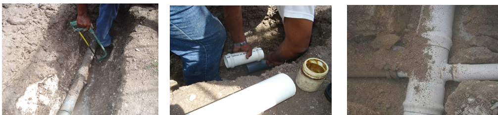
Figuras 34, 35 y 36. Excavación, instalación de tubería y reparación, La Florida.
