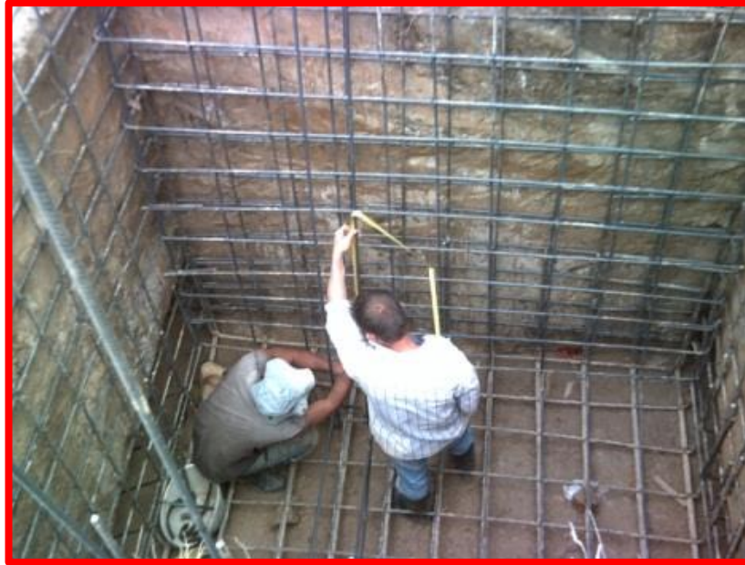
Imagen. 6. Figuración de acero de refuerzo (estructural).
