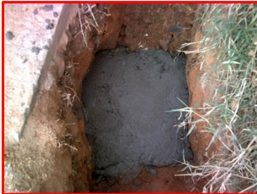
Imagen. 3. Suministro de concreto de 2000 psi para atraques.
