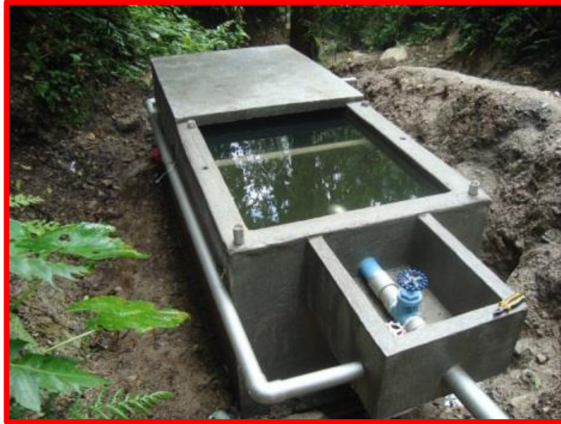
Imagen. 4. Estructura en concreto reforzado (Desarenador).
