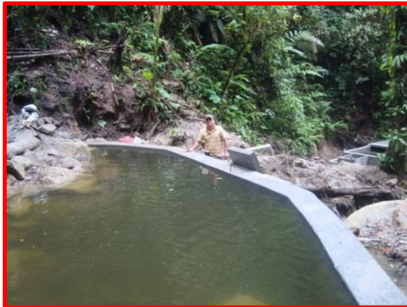
Imagen. 5. Estructura en concreto reforzado (represa).
