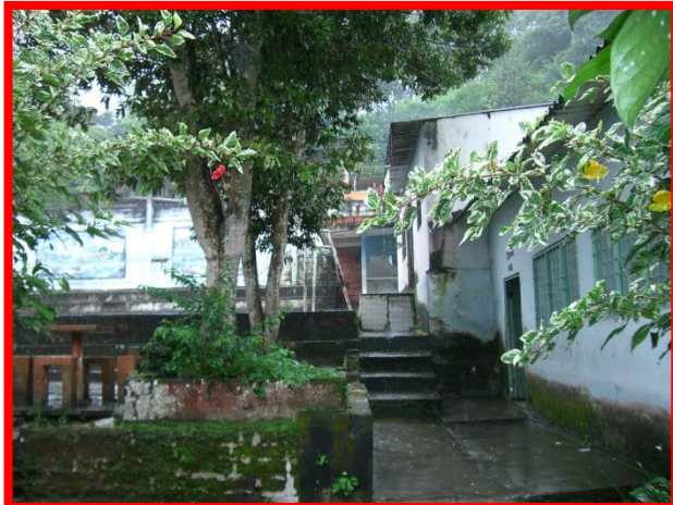
Imagen 15. Problemas de humedad Fuente: Propia.
