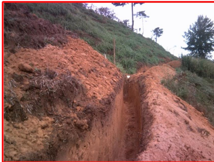
Imagen. 1. Excavación en material común.
