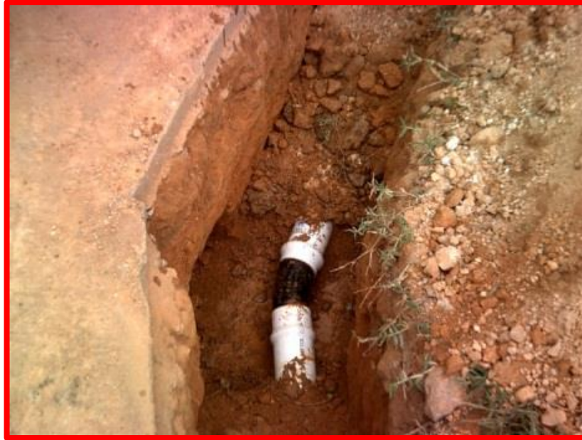
Imagen. 2. Instalación de Accesorios HF Codo 22°.
