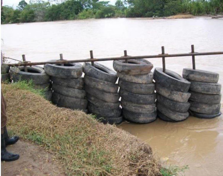
Figura 40. Colocación de los espolones de 9 m de largo y 3.7 m de alto.
