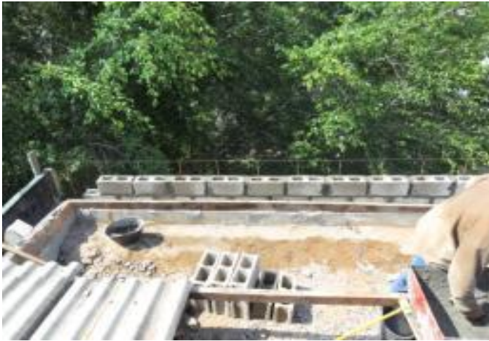
Figura 28. Realización de viga canal.
