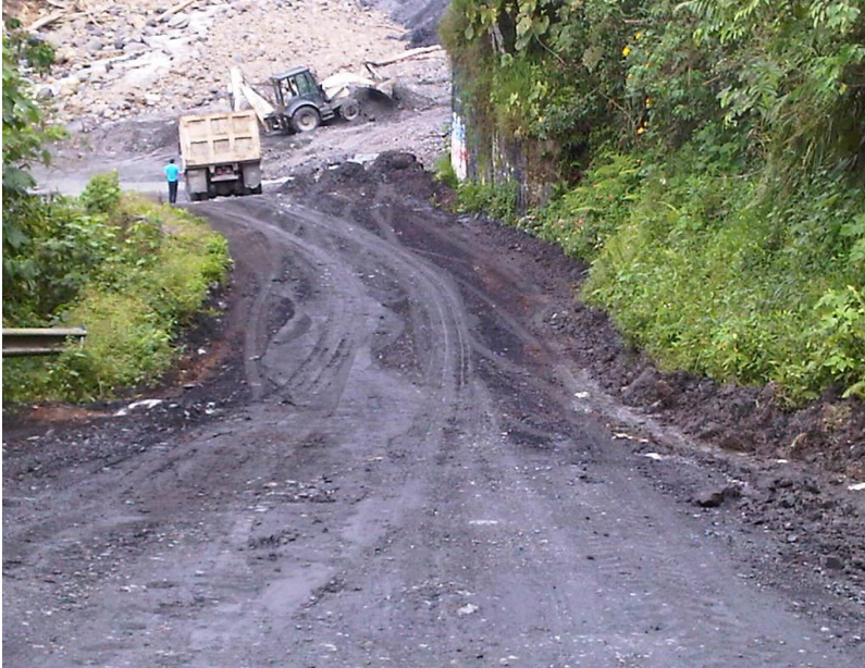
Figura 48. Mejoramiento del calzada y cunetas
