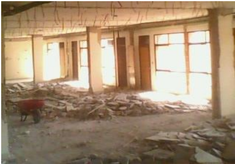
Figura 10. Demolición de pisos
