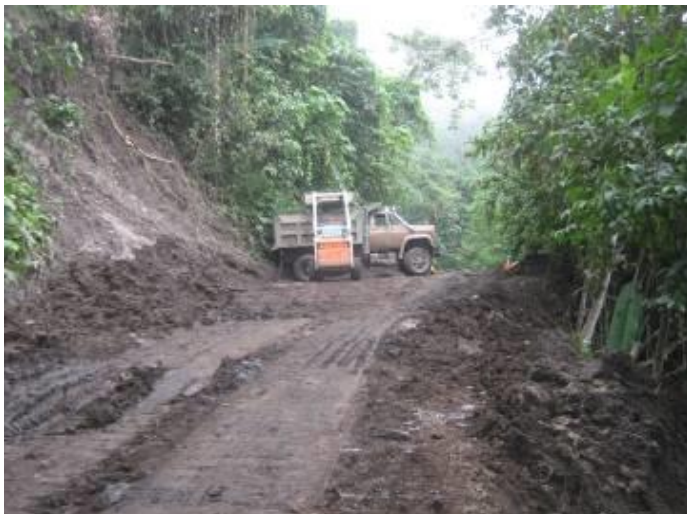
Figura 45. Trabajo con excavadora.
