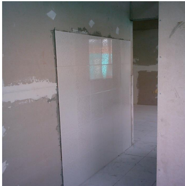
Figura 13. Colocación de enchape sobre muros en Dry wall
