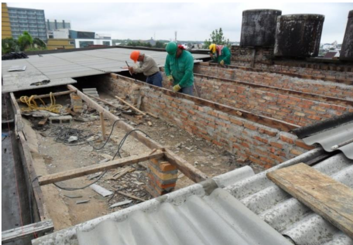
Figura 29. Construcción de viga canal e instalación de cubierta.
