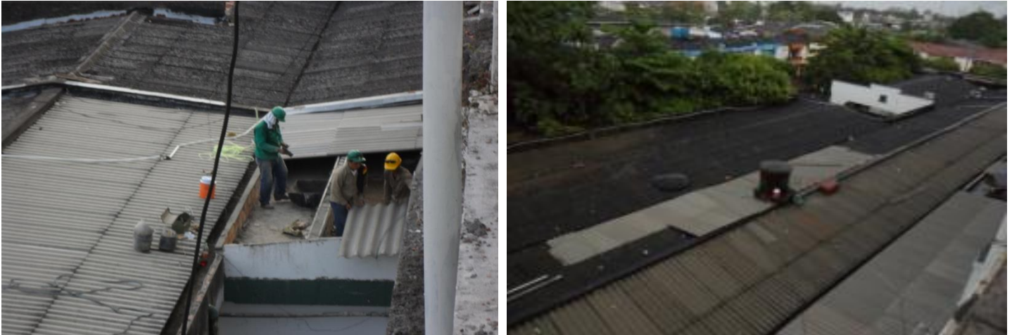
Figura 30 y 31. Desmonte e instalación de cubierta
