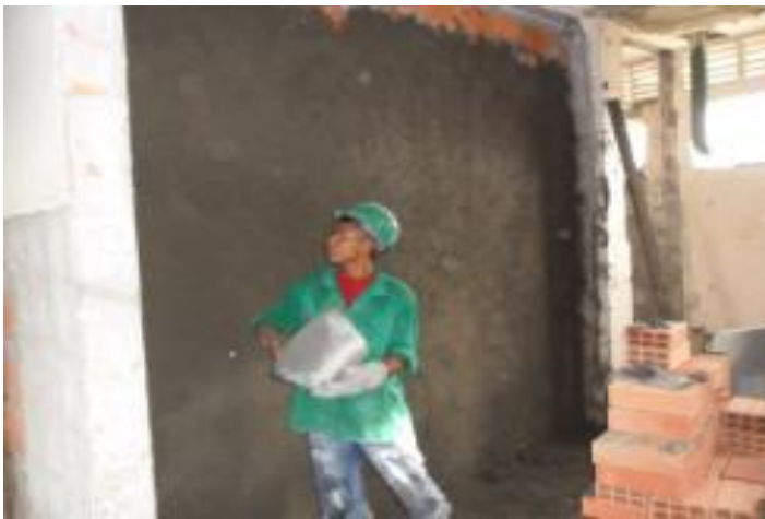
Figura 27. Pañetes en el cuarto piso
