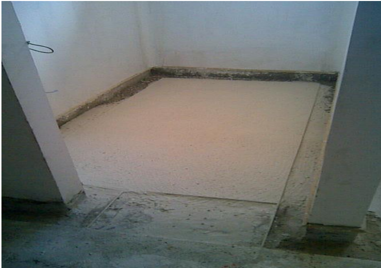
Figura 15. Colocación de base piso
