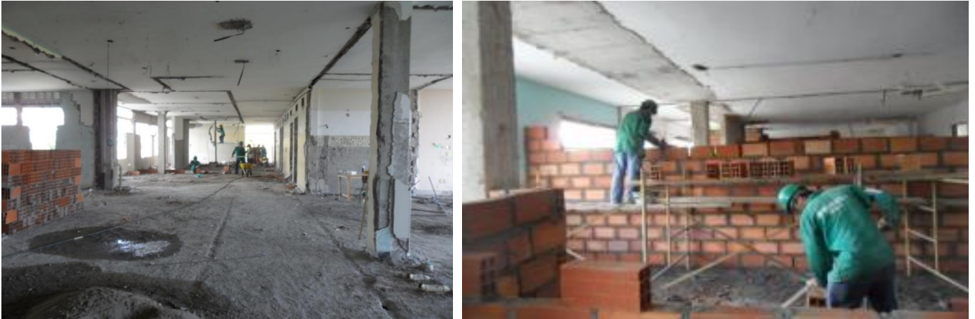
Figuras 25 y 26. Levante en mampostería en ladrillo H-10
