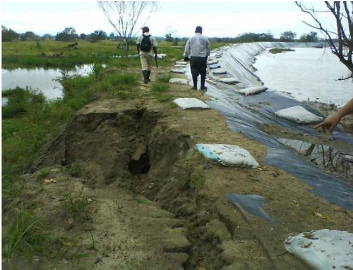
Figura 38. Reforzamiento de terraplenes con plástico de protección
