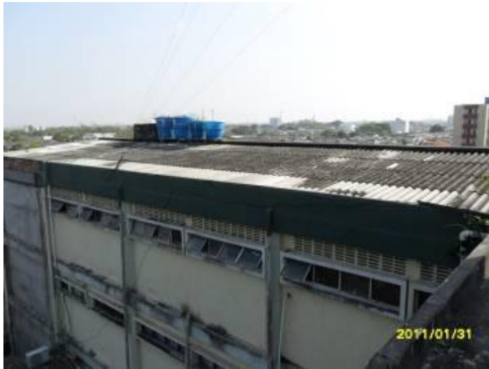
Figura 20. Estado inicial del hospital.
