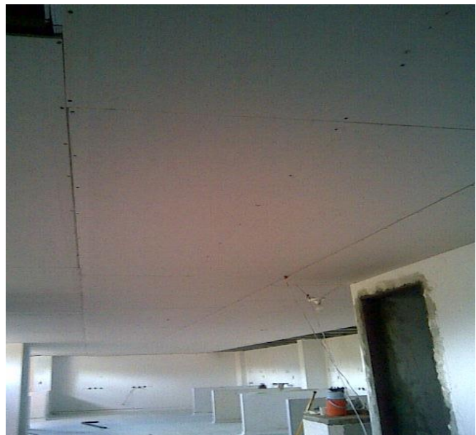
Figura 16. Instalacion de cielo raso dry wall
