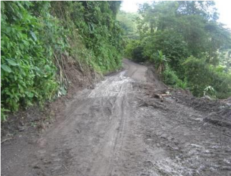
Figura 47. Limpieza de la calzada
