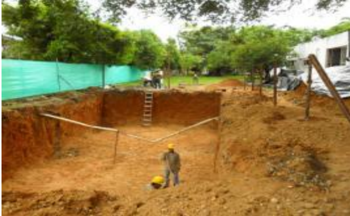
Figura 32. Replanteo del tanque de agua potable
