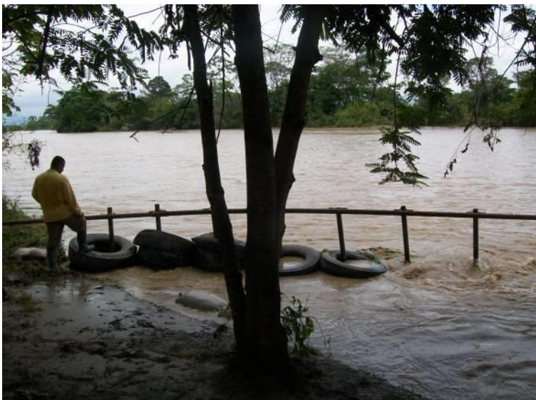
Figura 39. Colocación de los primeros bultos bolsa mortero
