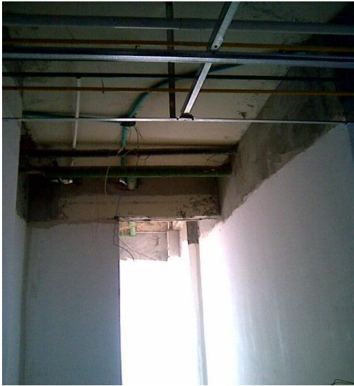
Figura 11. Desmonte de cielos rasos
