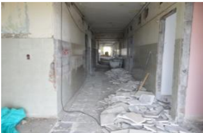
Figura 21. Demolición y Desmonte de pisos y enchapes.
