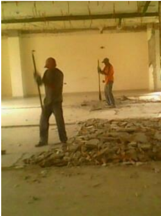
Figura 9. Demolicion de pisos
