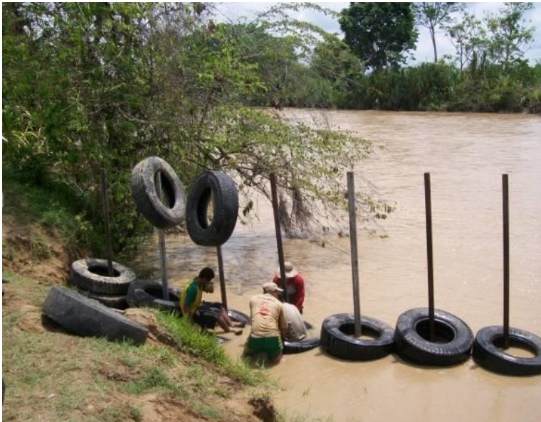
Figura 41. Cuadrilla ejecutando la obra
