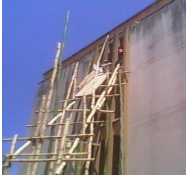
Figura 17. Estructura para facilitar la remoción de escombros
