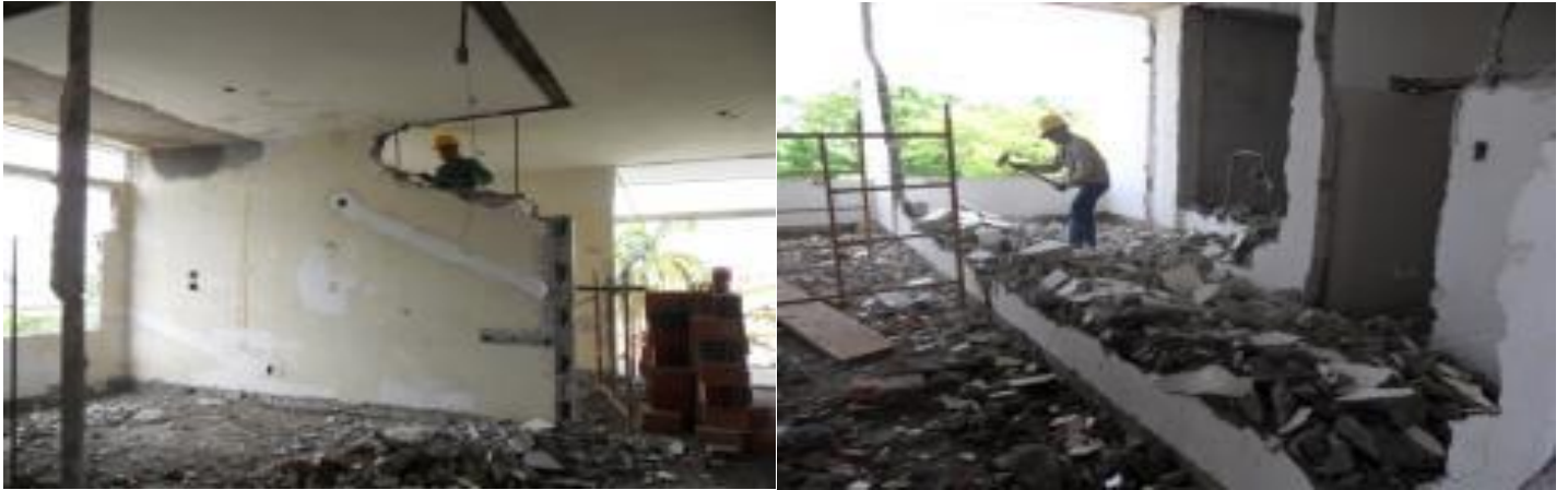
Figura 24. Desmonte de ventanas
