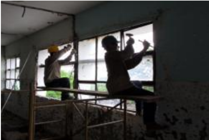
Figura 24. Desmonte de ventanas
