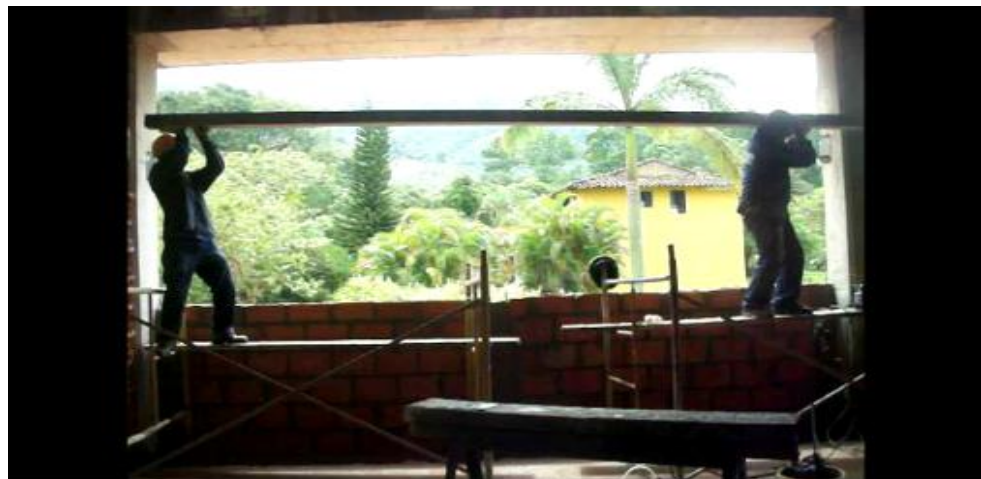
Instalación refuerzo soporte transversal ventanería
