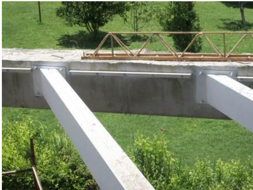
Vista de soportes lamina colaboranté
