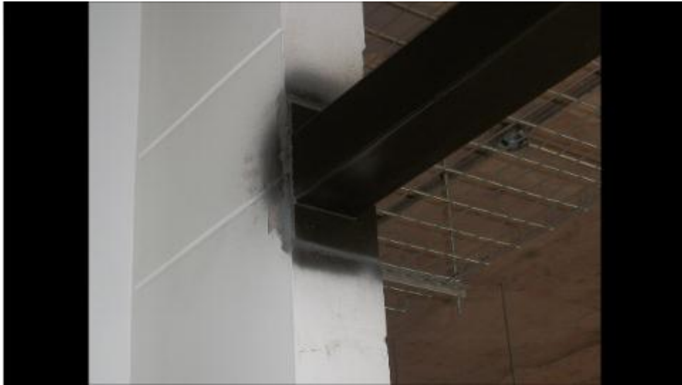
Elemento de apoyo ya pintado
