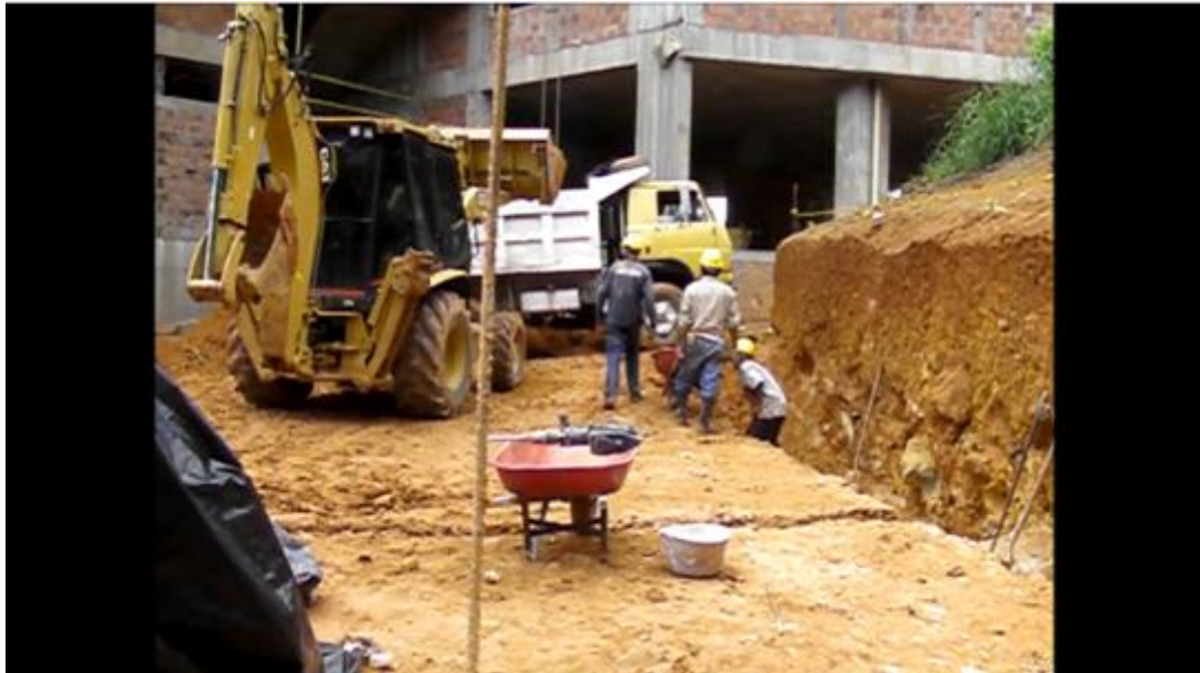
Excavaciones muro de contención
