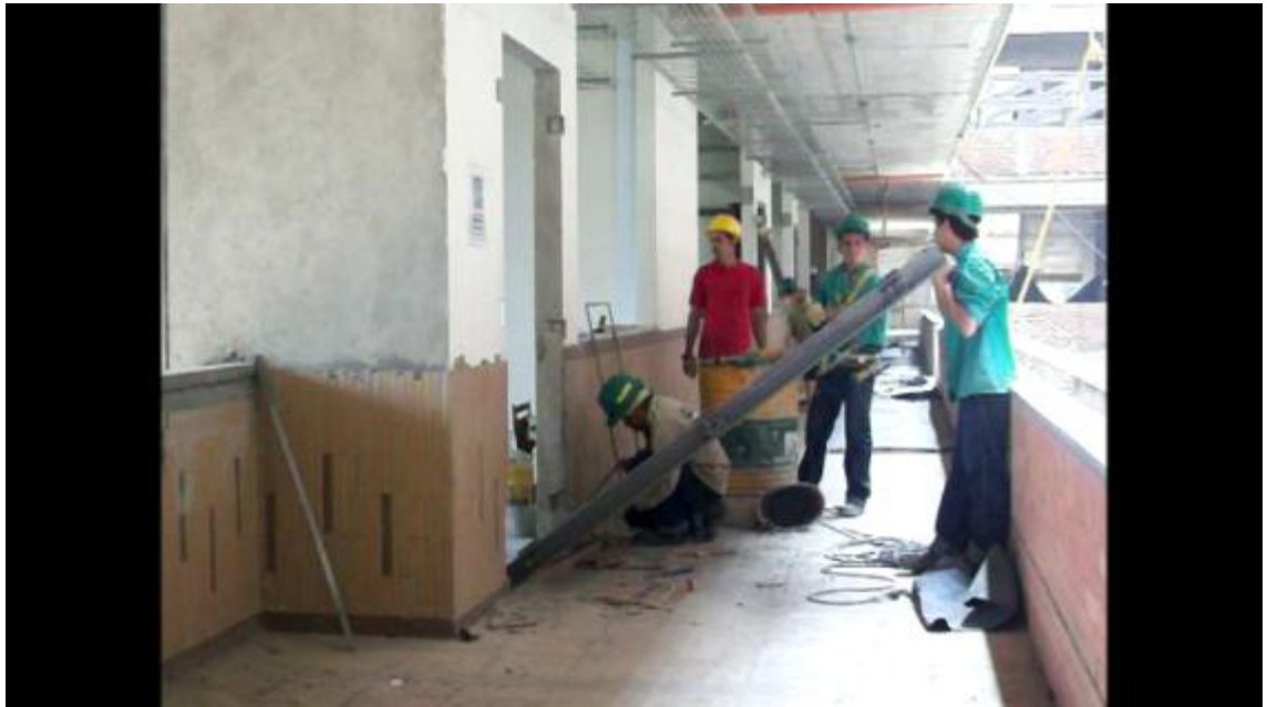
Lamina de drywall
