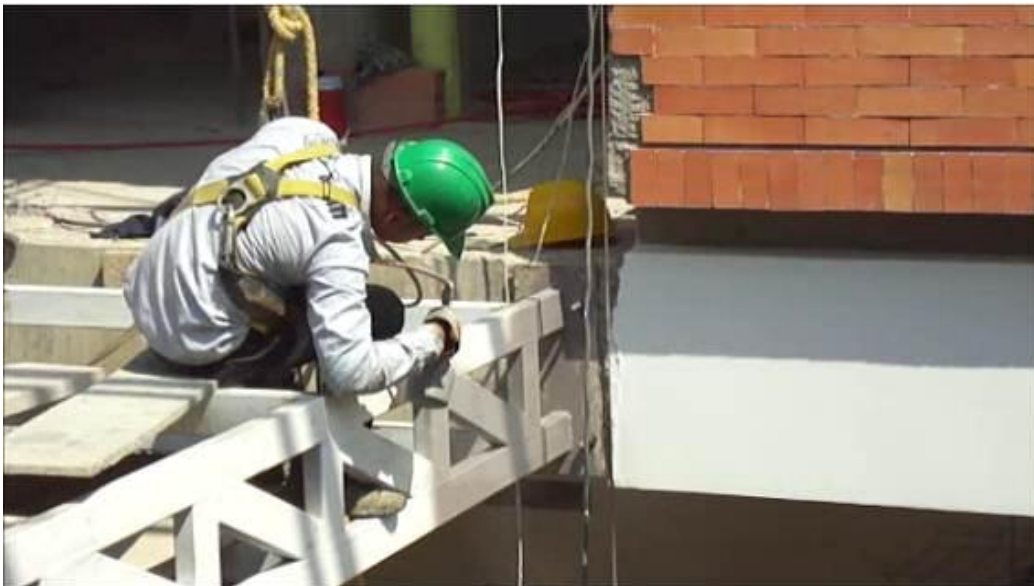
Aplicación de la pintura bases de puentes
