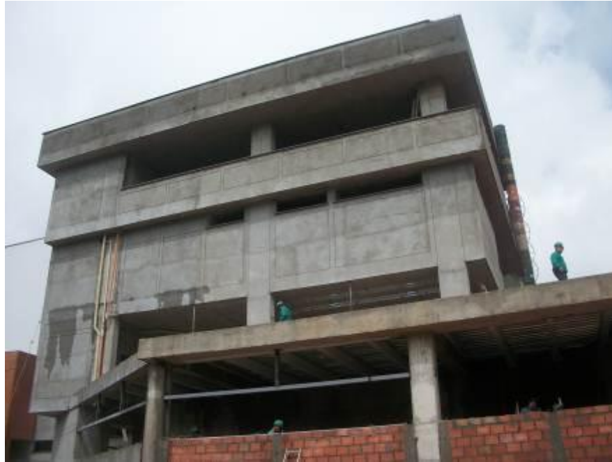
Fachada posterior del bloque k
