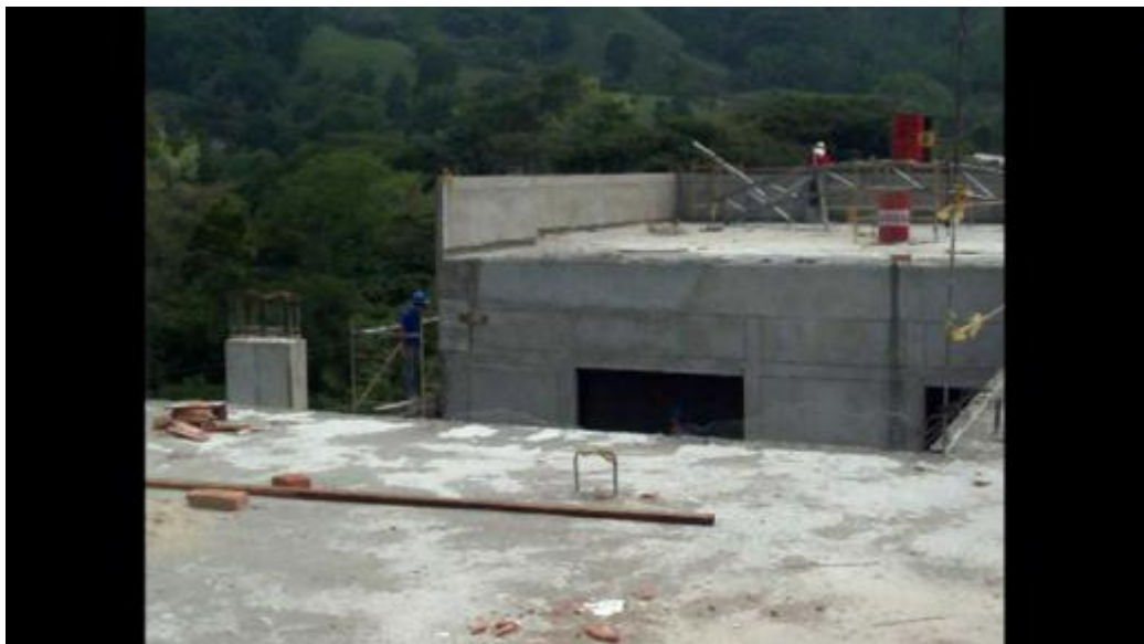
Espacio antes de la instalación de la cabina de televisión
