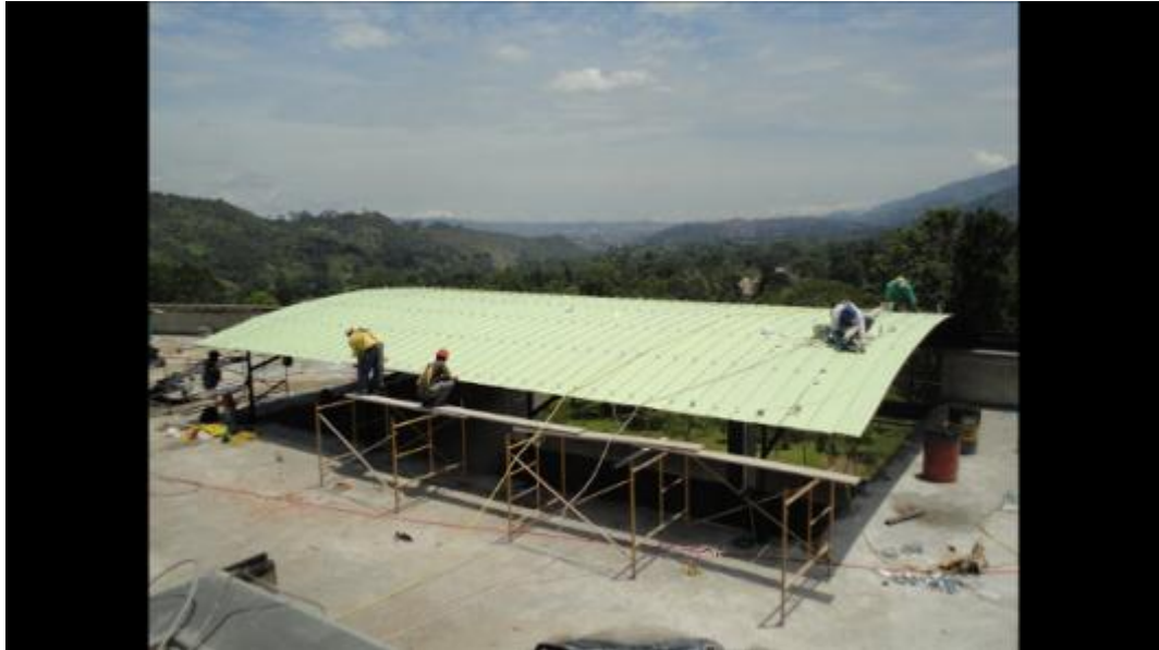
Vista superior cabina de televisión
