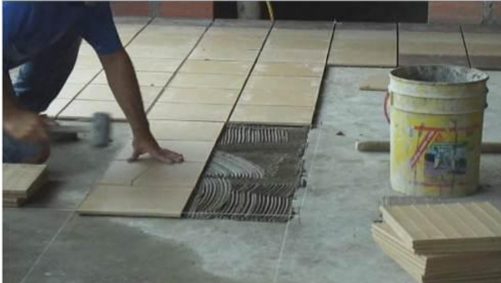
Instalación de cerámica
