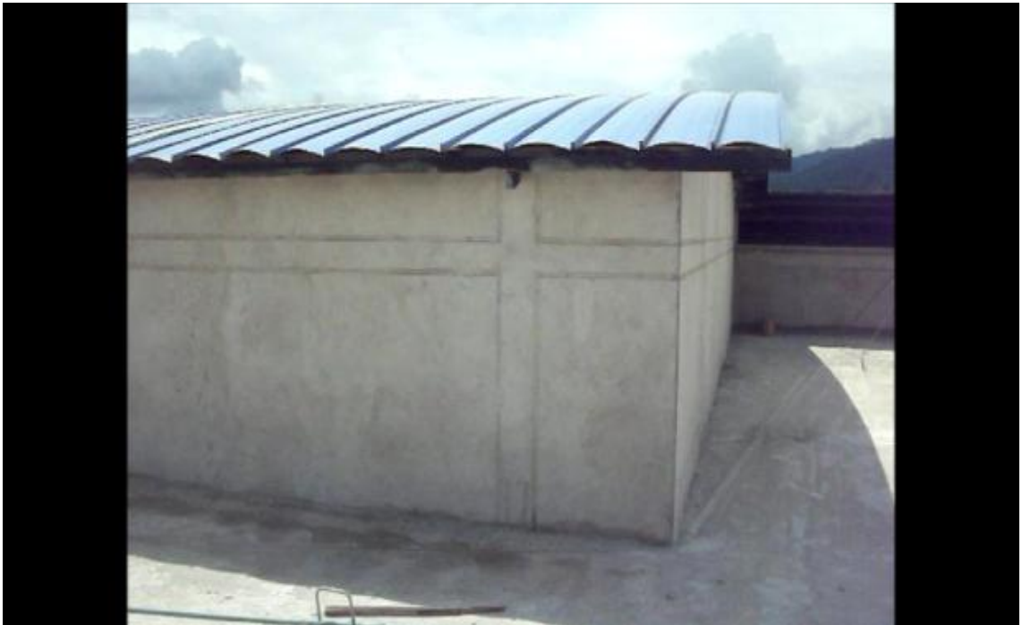
Vista lateral cabina de televisión
