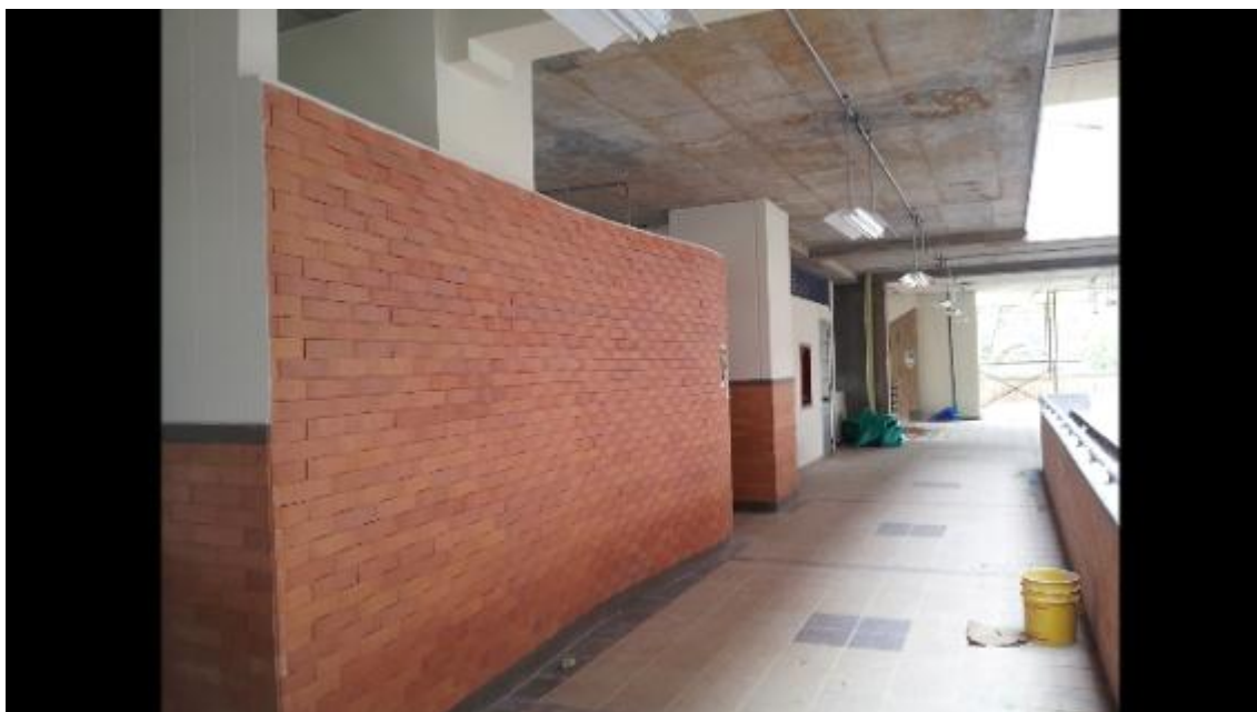
Pasillo bloque K
