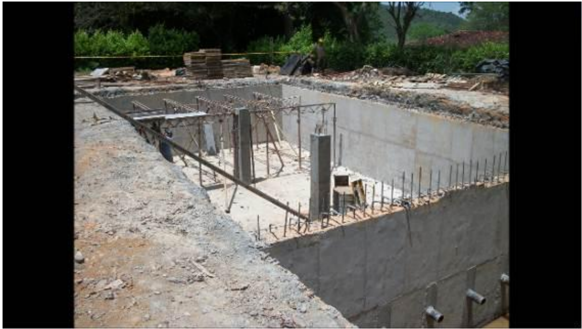
Vista 3 Tanque almacenamiento de agua potable
