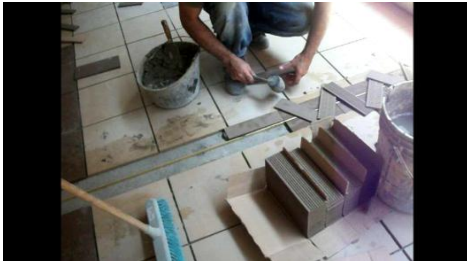
Instalación de baldosa corte
