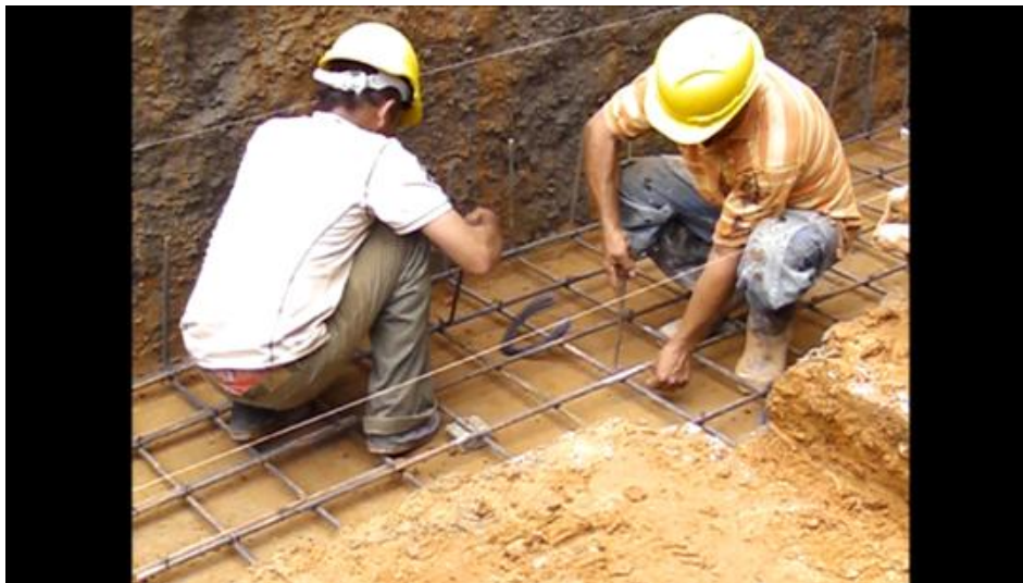
Refuerzo inferior muro de contención
