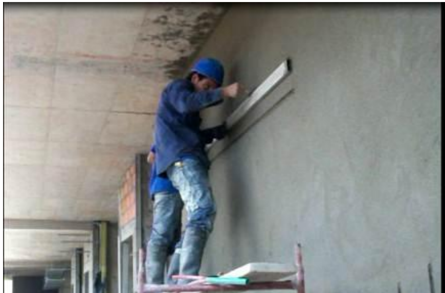
Estuco y pintura
