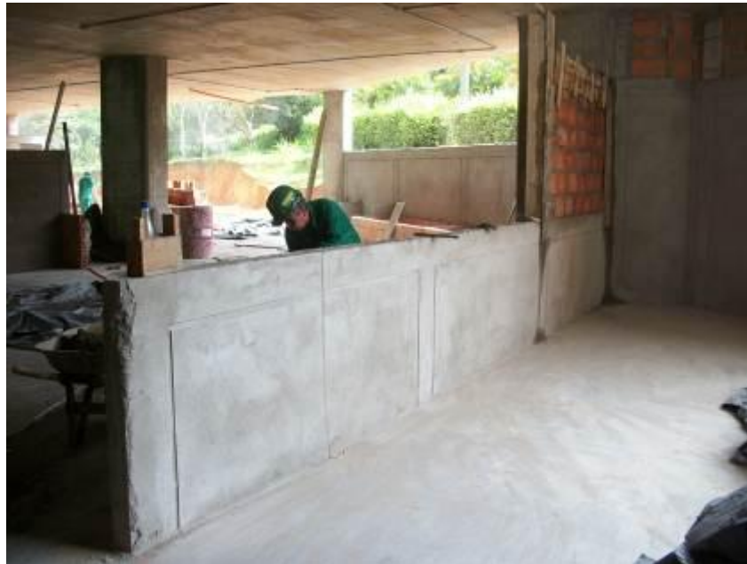
Muro mampostería frisado
