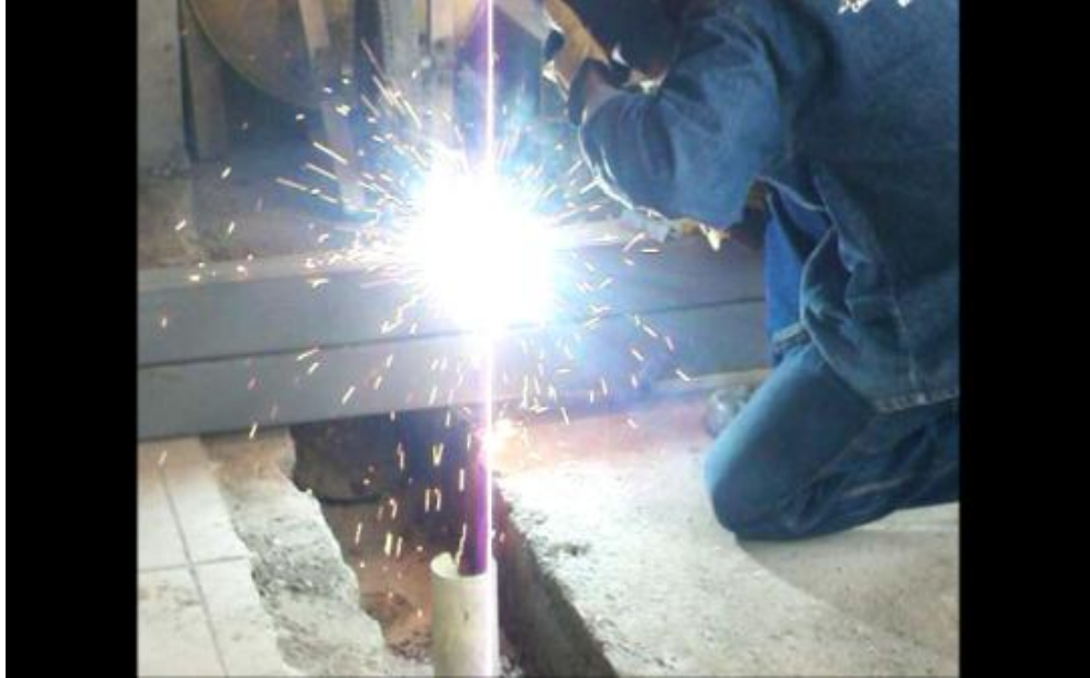
Soldadura adecuamiento del material
