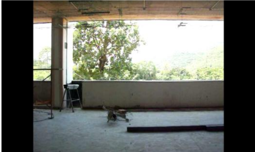
Espacio para instalación de Ventanería
