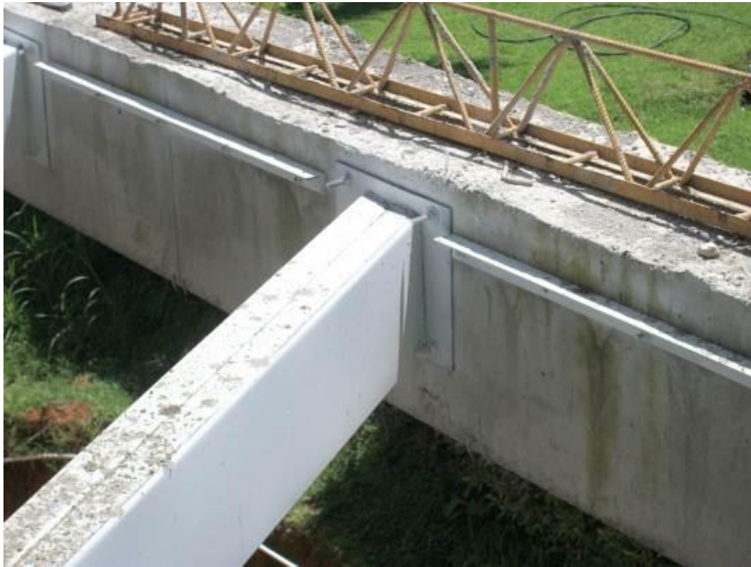
Perfil instalado y unido a la viga de concreto
