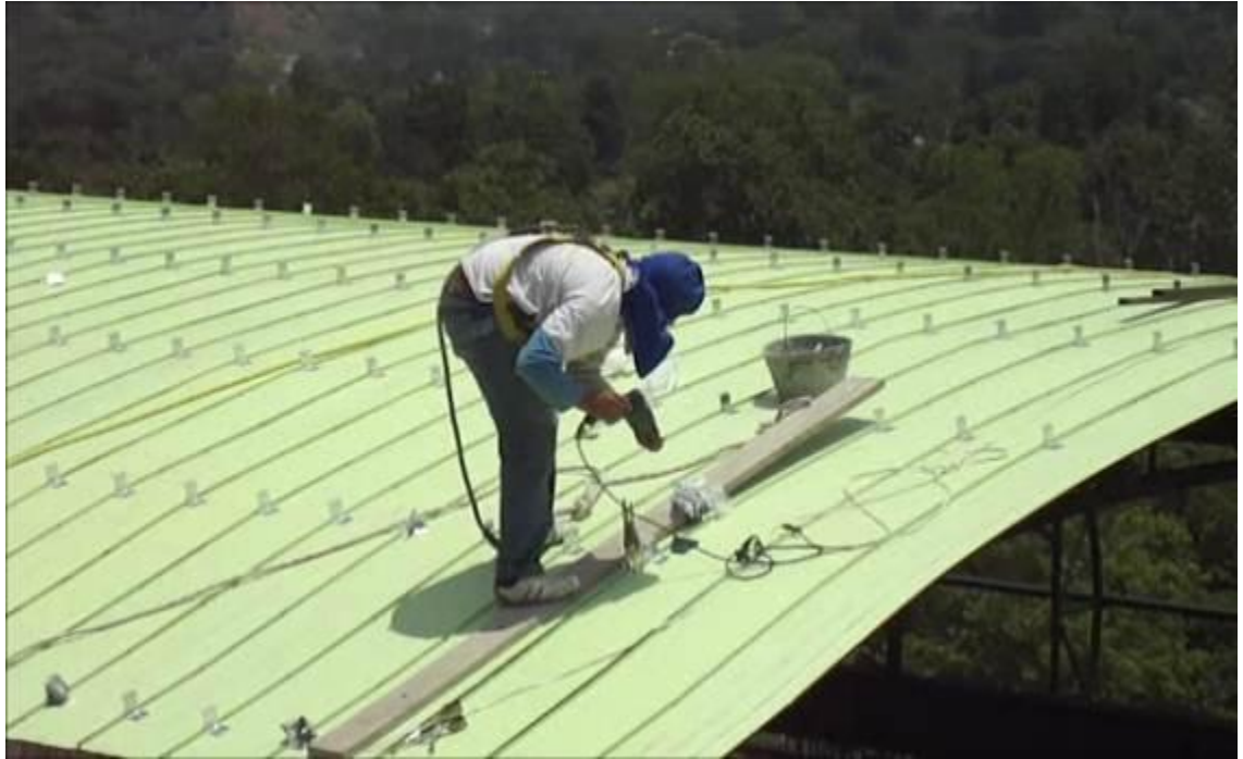
Vista superior intalacion de teja verde cubierta de cabina de television
