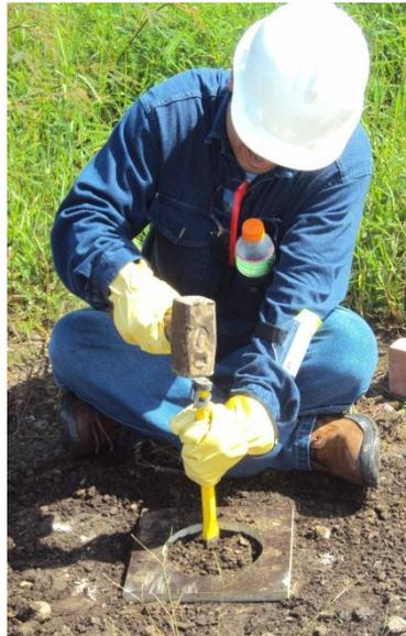
Figura 14. Abertura del hoyo con las herramientas respectivas.
