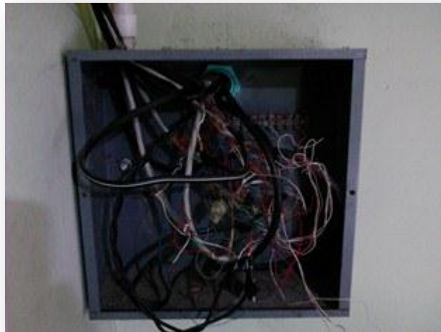
Imagen 8. Cable del ISP, Clínica San José. Fuente: El Autor
