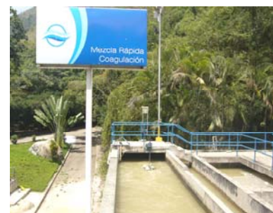
Fotografía 3. Inicio del tratamiento
