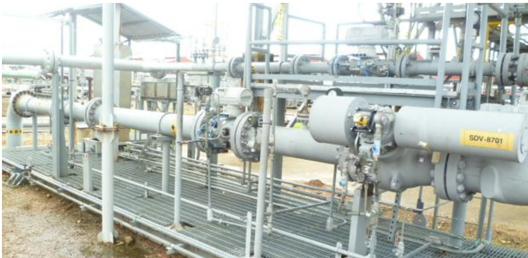
Figura 1 Skid de medición Porvenir
