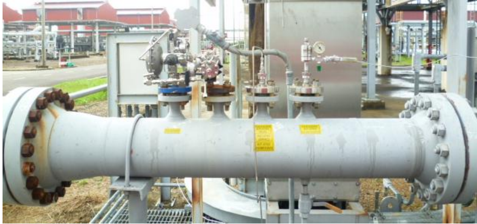
Figura 10 Sondas de muestreo Skid de medición Porvenir
