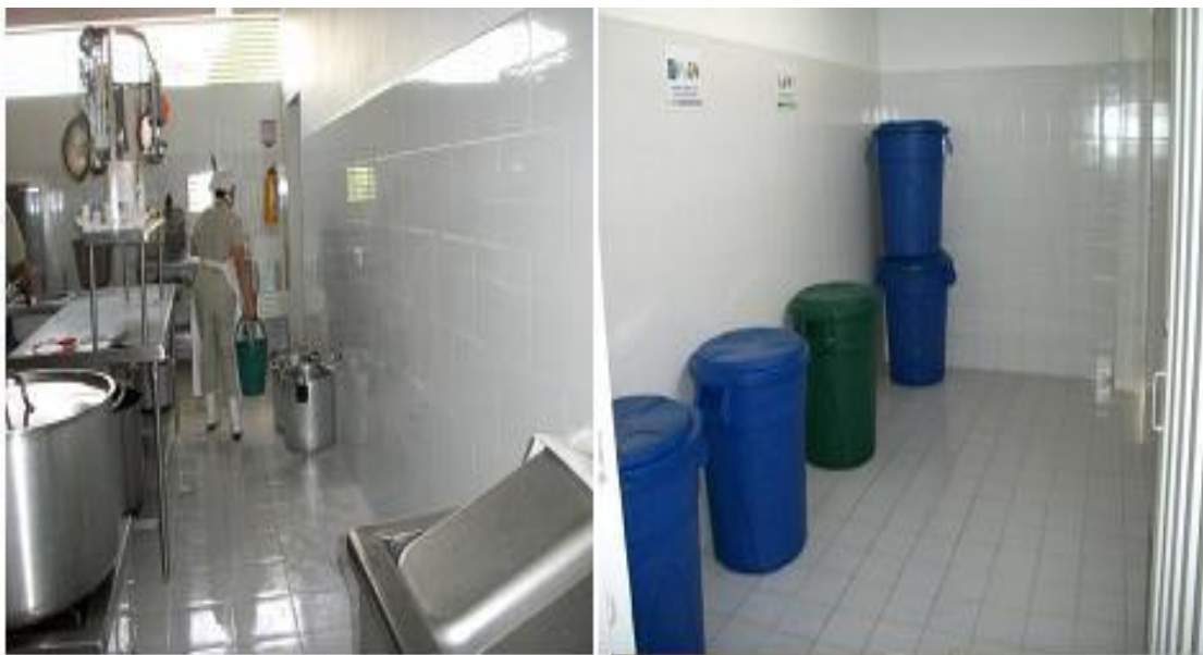
Fotos 18. Mejoras en área de cocina Y Cuarto de aseo.
