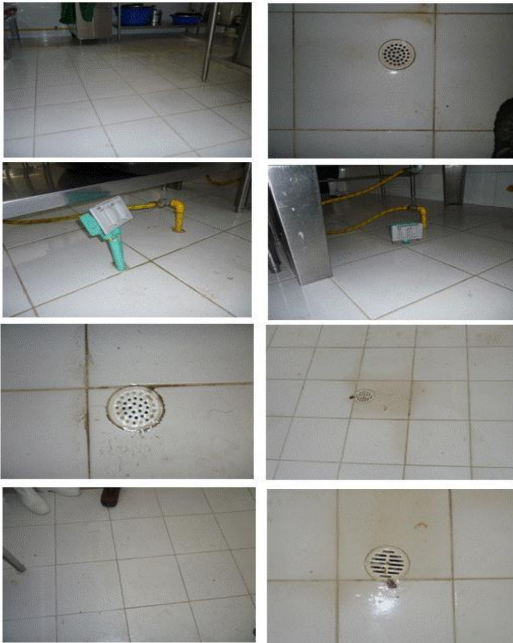
Foto 6. Estado de Pisos y drenajes
