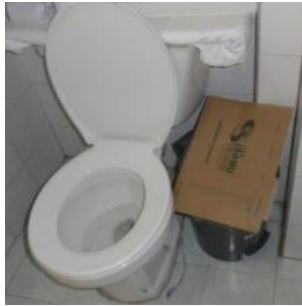
Fotografía 7. Recipiente inadecuado en baños
