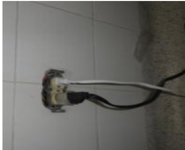
Fotografía 31. Enchufe sin tapa protectora
