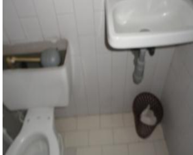
Fotografía 55. Recipiente de los baños
