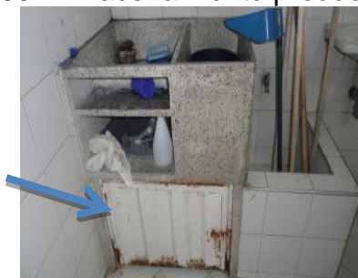
Fotografía 60. Almacenamiento productos químicos
