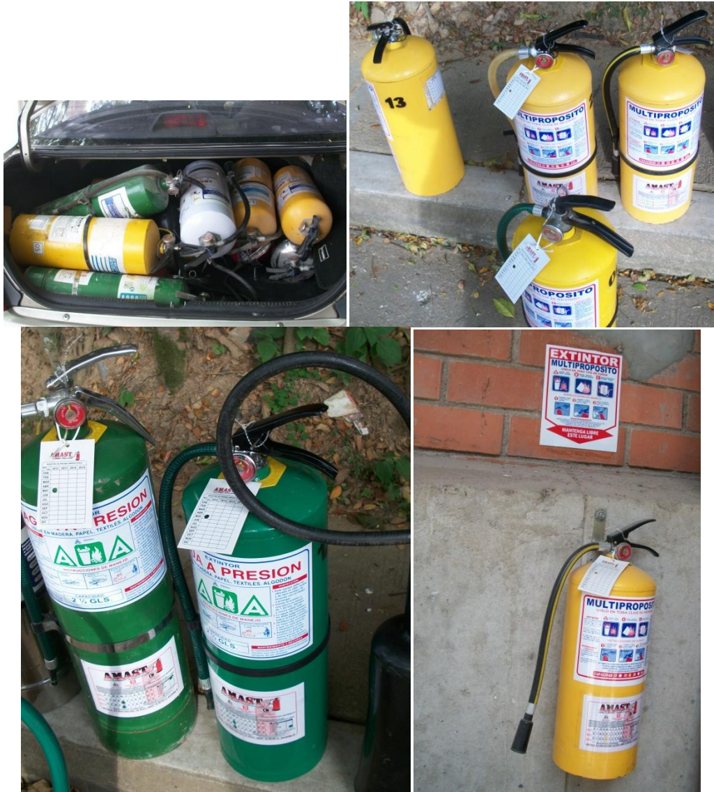
Imagen No. 22: Antes y después de los extintores enviados a recarga y/o reposición
