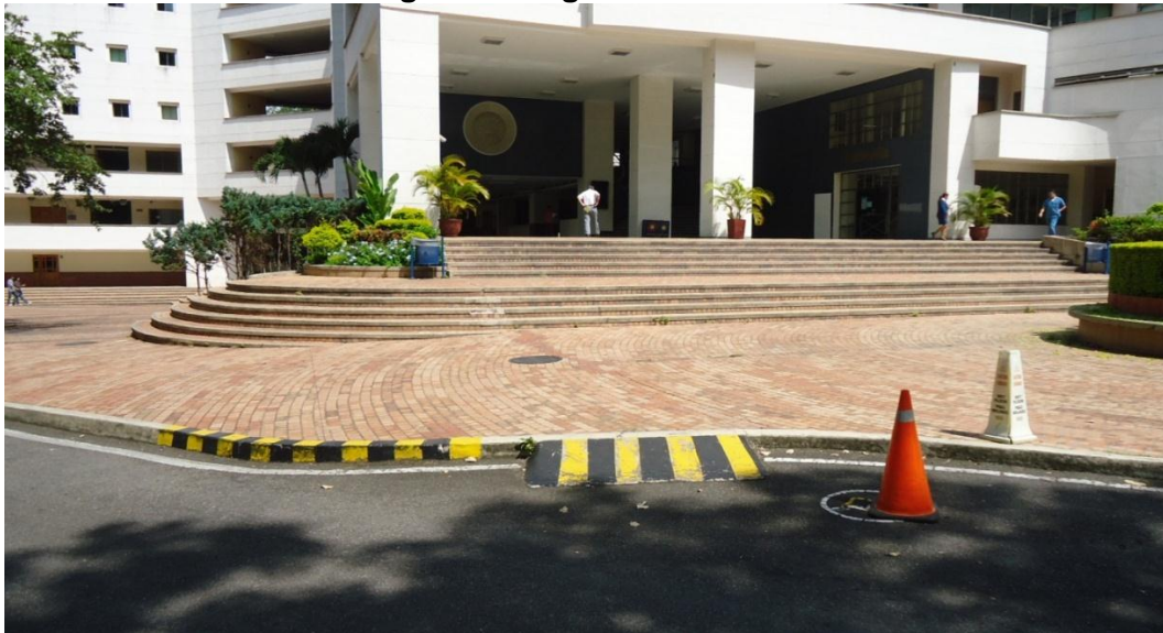
Figura 80. Ingreso edificio Santander
