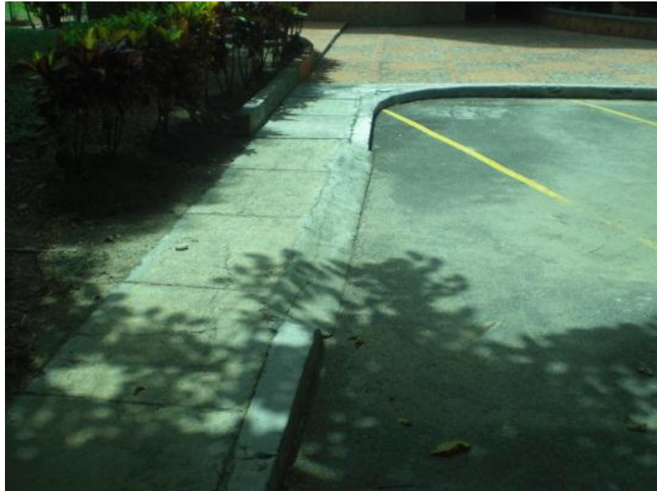
Figura 83. Acceso y Rebaje edificio Fray Angélico.
