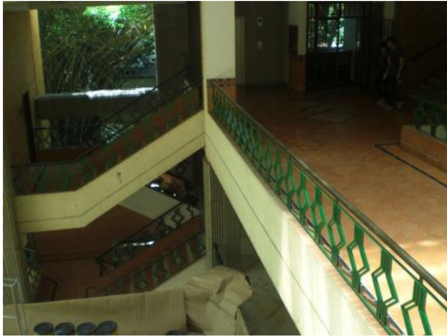
Figura 86. Escaleras y corredores edificio Fray Angelico.
