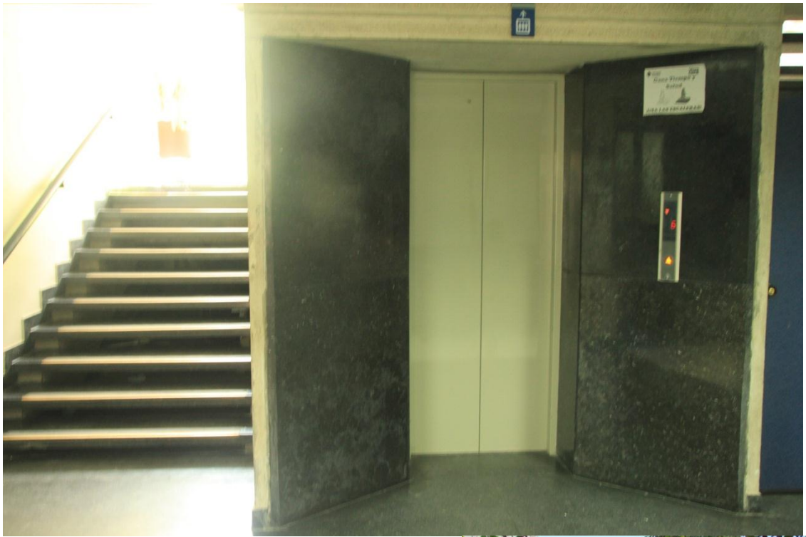
Figura 100. Ascensor y escaleras edificio D
