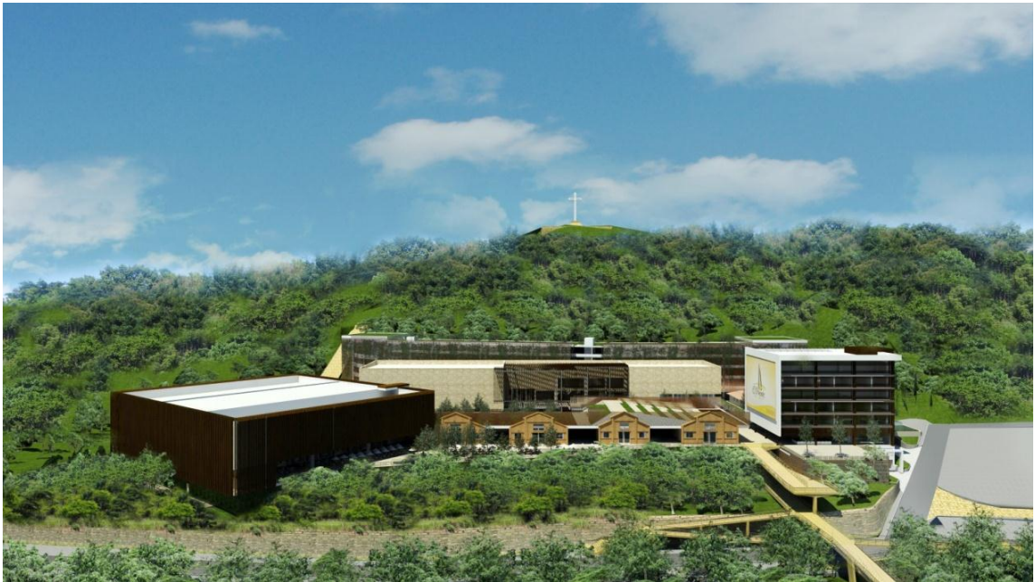
Figura 7. Vista panorámica Centro Comercial el Puente
