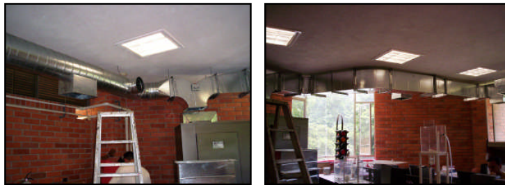
Figura 3. Montaje de ductos
