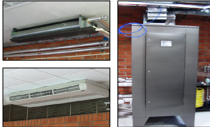
Figura 5. Fancoils y UMA
