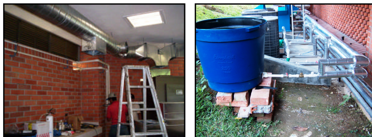
Figura 4. Montaje sistema hidráulico
