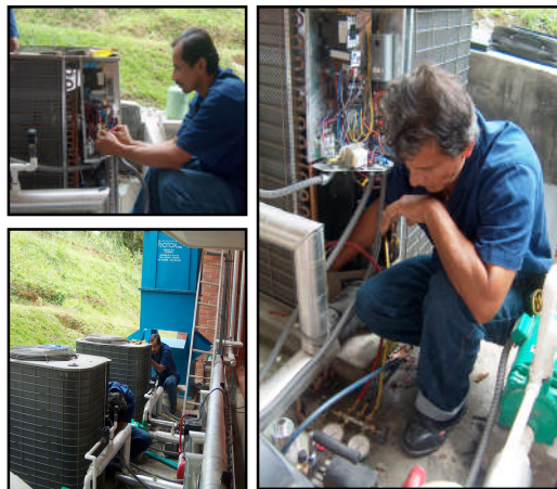
Figura 9. Adecuación de equipos y arranque
