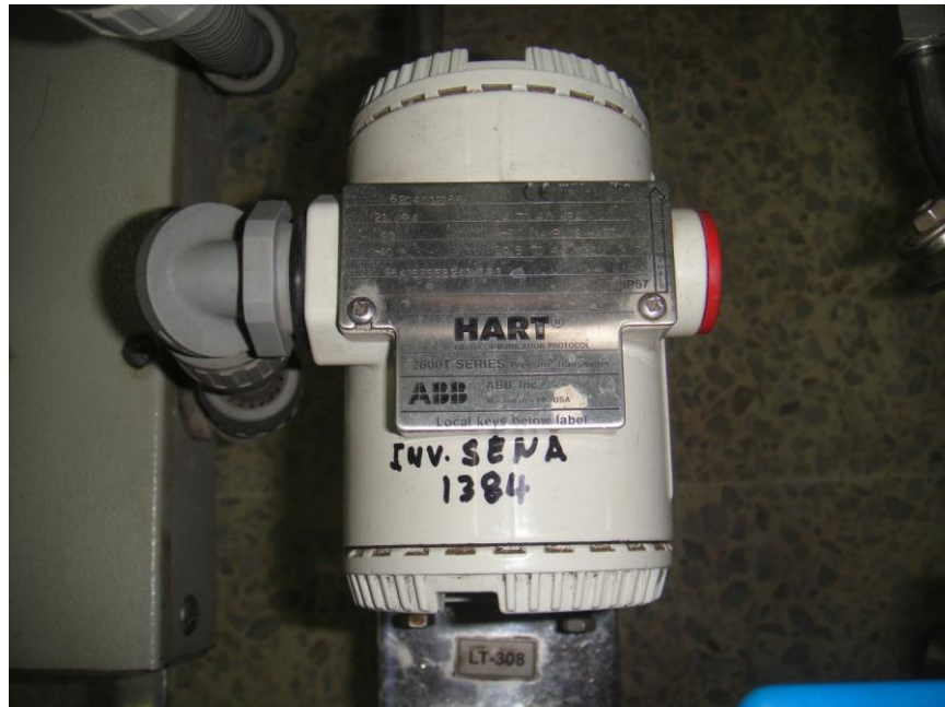
Figura 25. Transmisor de Presión Diferencial Marca ABB. [14]
