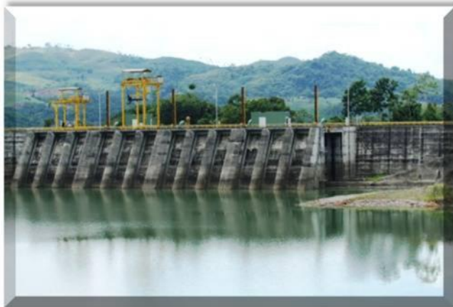
Ilustración 7 Estructura de toma.
