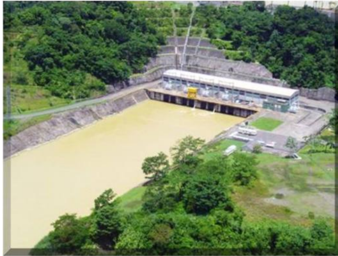
Ilustración 9 Canal de descarga.
