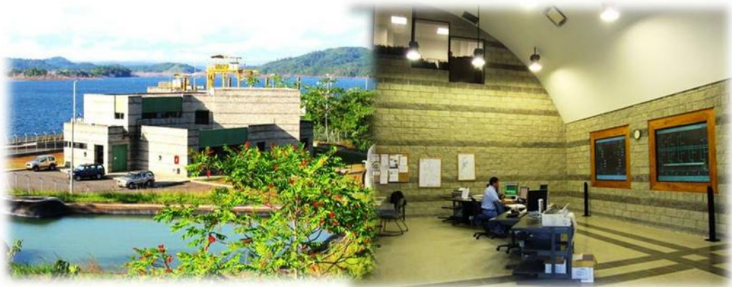
Ilustración 10 Edificio de control.
