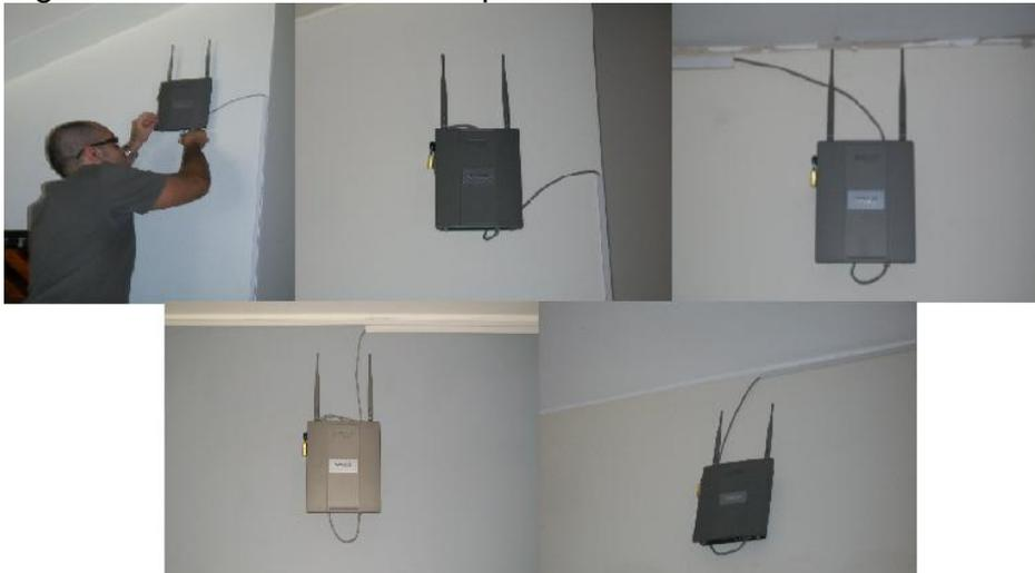
Procedemos a la configuración del Router, del Switch y de los Access point. Se asigna la dirección IP, la máscara de subred, la puerta de enlace de cada uno de los dispositivos mencionados y se realiza la configuración y administración de la red de datos según la necesidad del cliente.
