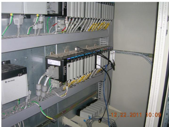
En este mismo cuarto los gabinetes MC-U801-01 y MC-U801-02 tienen los módulos de interfaces para las I/O y en el gabinete TI-01 se encuentra los patch panel de fibra óptica de la red ControlNet, una Controlink Network Master de EIM para válvulas motorizadas, un indicador remoto de un transmisor de nivel ultrasónico y un patch panel para la fibra óptica del CCTV.
