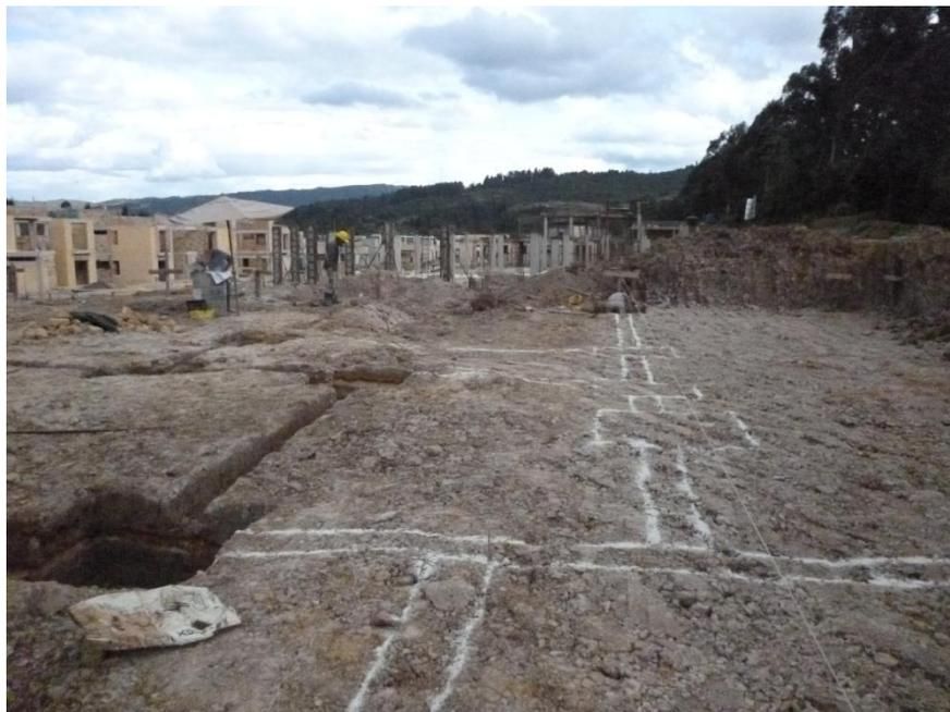
**Imagen 2. Excavación zapatas y viguetas. Fuente propia**
