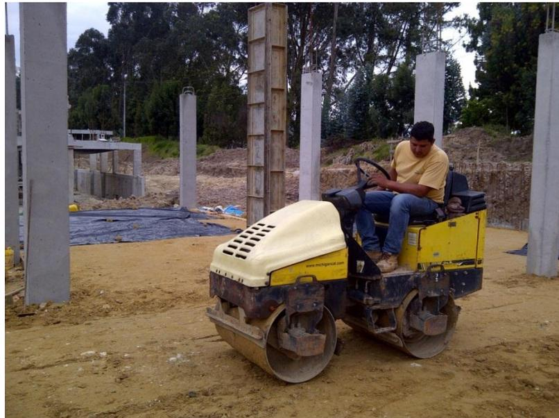
**Imagen 8, compactando el terreno con el benitin para proceder a ubicar el plástico y malla como se menciona anteriormente, Fuente propia**
