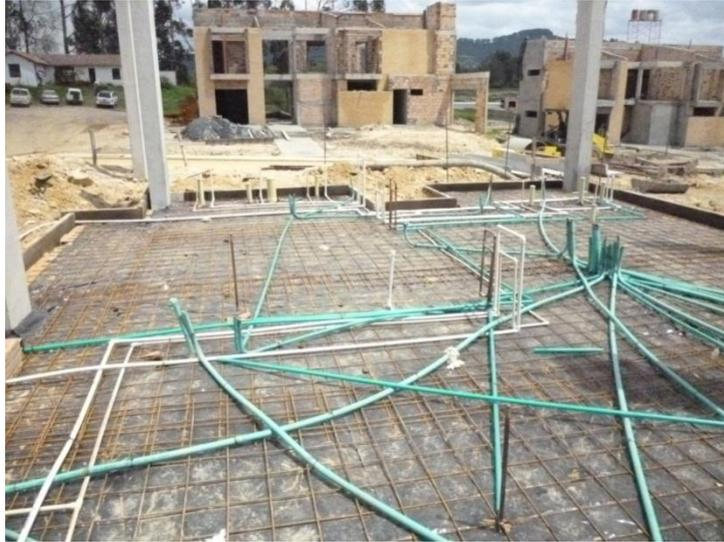
**Imagen 9, Losa contrapiso nivel 1 con tubería hidráulica y eléctrica, fuente propia**
