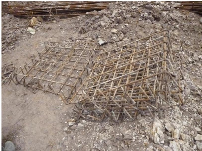
Imagen 3. Foto del armado de canastas para las zapatas, Fuente propia
