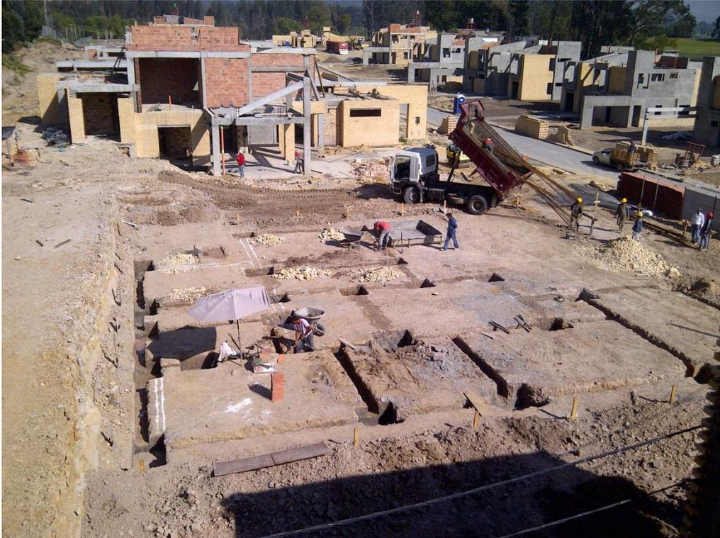
Imagen 5, Excavación para zapatas y vigas cimentación, Fuente propia
