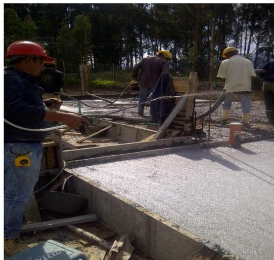
**Imagen 12, aplicando antisol a losa de entrecimiento nivel 3, Fuente propia**
