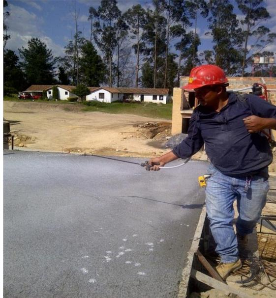
**Imagen 11, Aplicando Antisol a la losa de entrecimiento de nivel 3, Fuente propia**
