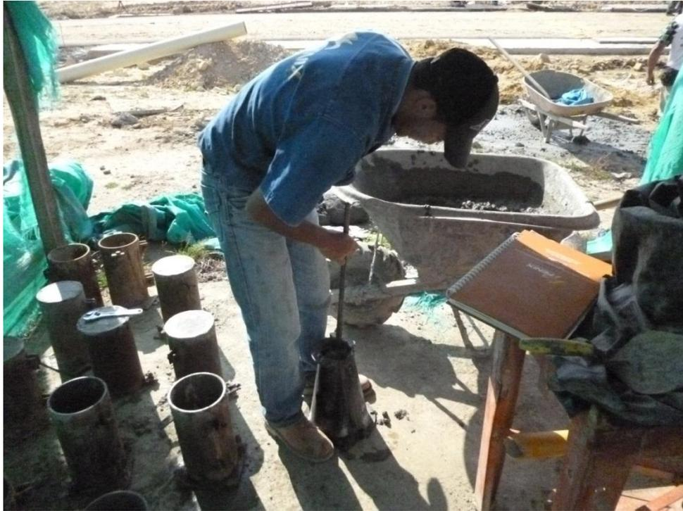
**Imagen 19, encargado de sacar las muestras de concreto de cada elemento que se funde en la obra, Fuente propia**
