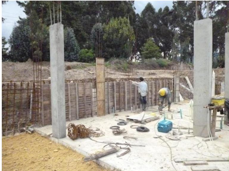
**Imagen 13, Encofrado Muro de Contención, Fuente propia**
