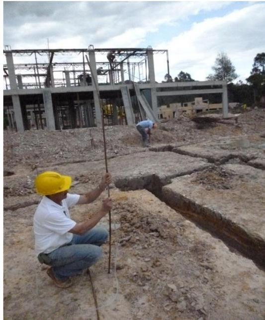
Imagen 4, Verificando los niveles antes de fundir las zapatas
