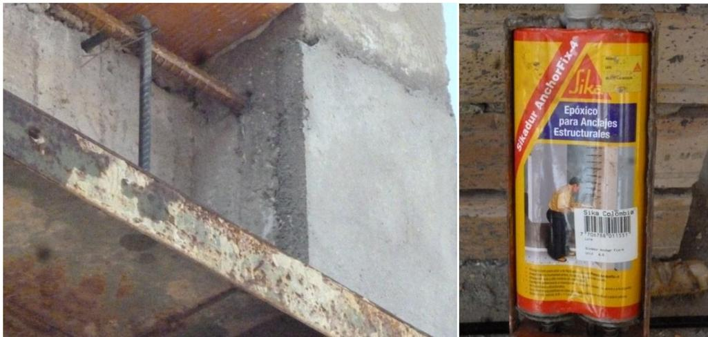
Imagen 16, Recalce utilizando el producto anchorfix-4 para el anclaje, Fuente propia
