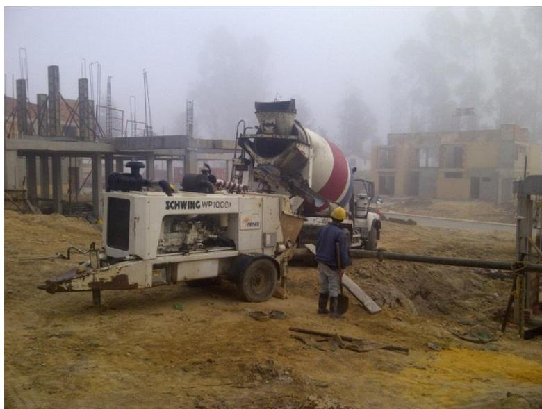
**Imagen 14, De cuando se iba a fundir la losa de contrapiso de nivel 2 de la casa 10, Fuente Propia**
