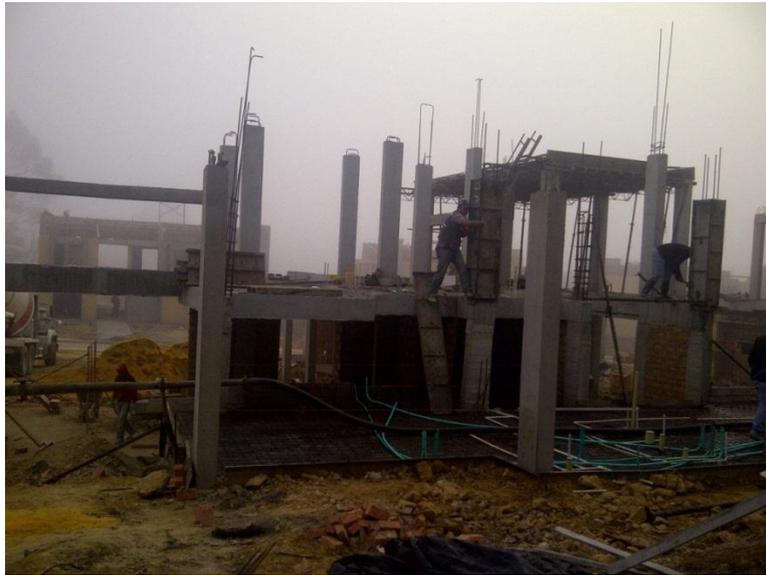
Imagen 15, Placa contrapiso con la tubería eléctrica e hidráulica para empezar a descargar el concreto que es despachado por Cemex, Fuente propia
