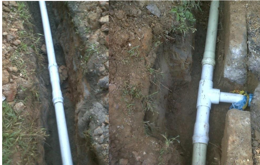
Figura 17 Fotografías Instalación de red y accesorios (Tee 4X3 Unión Mecánica)
