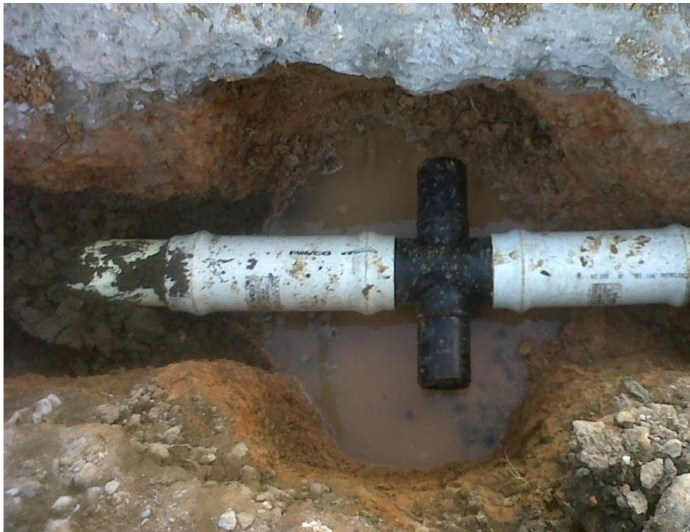
Figura 17 Fotografías Instalación de red y accesorios (Tee 4X3 Unión Mecánica)
