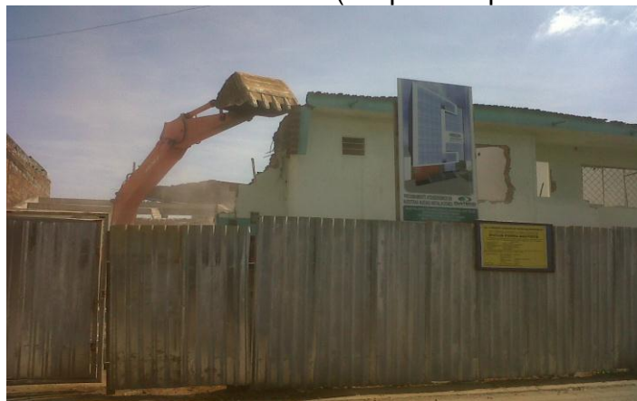
Figura 7 Desmantelamiento de estructura (Preparada para demolición).
