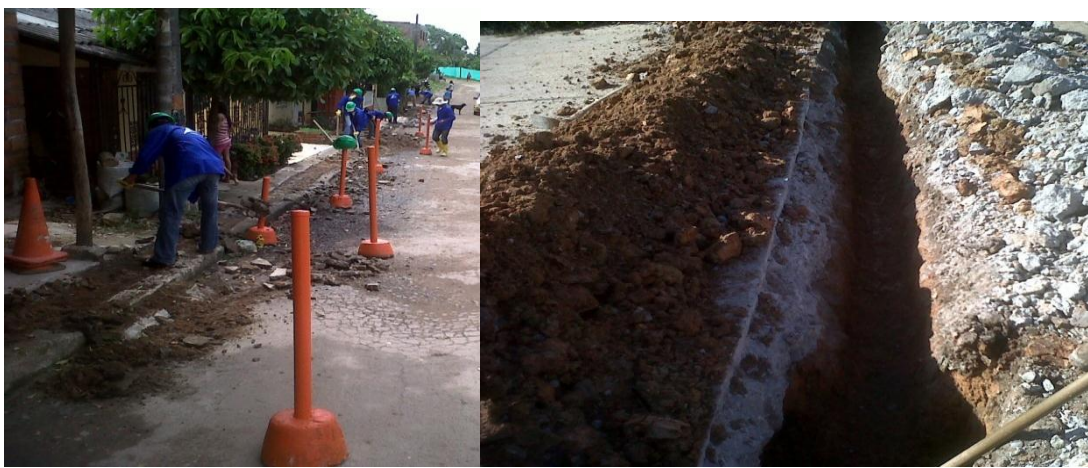
Figura 16. Fotografías Excavación manual*.
