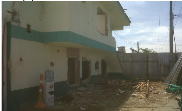
Figura 6. Fotografía demolición de oficinas principales de Diateco Ltda, calle 71 no 27-08, Barrancabermeja para construcción nuevo edificio de oficinas.
