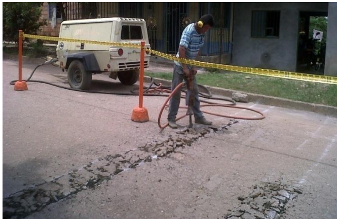
Figura 15. Fotografías Demolición de Pavimento para cruces de vía*.
