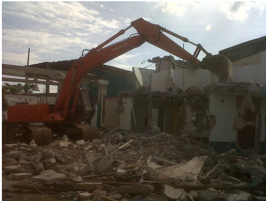
Figura 9. Demolición de Primer piso (Debilitamiento de columnas para demolición de placa)
