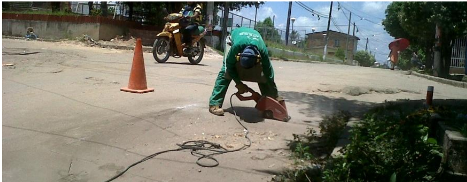
Figura 14. Fotografía Corte de pavimento en sitio de empalme*.
