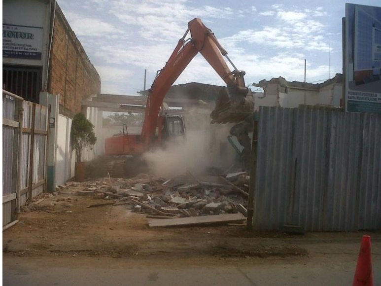
Figura 8. Demolición mecánica de segundo piso con retroexcavadora.
