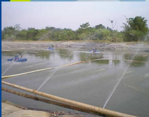
AIREADORES NEW WATER EN PISCINAS DE OXIDACION DE CAMPO ARAUCA DE ECOPETROL S.A.
