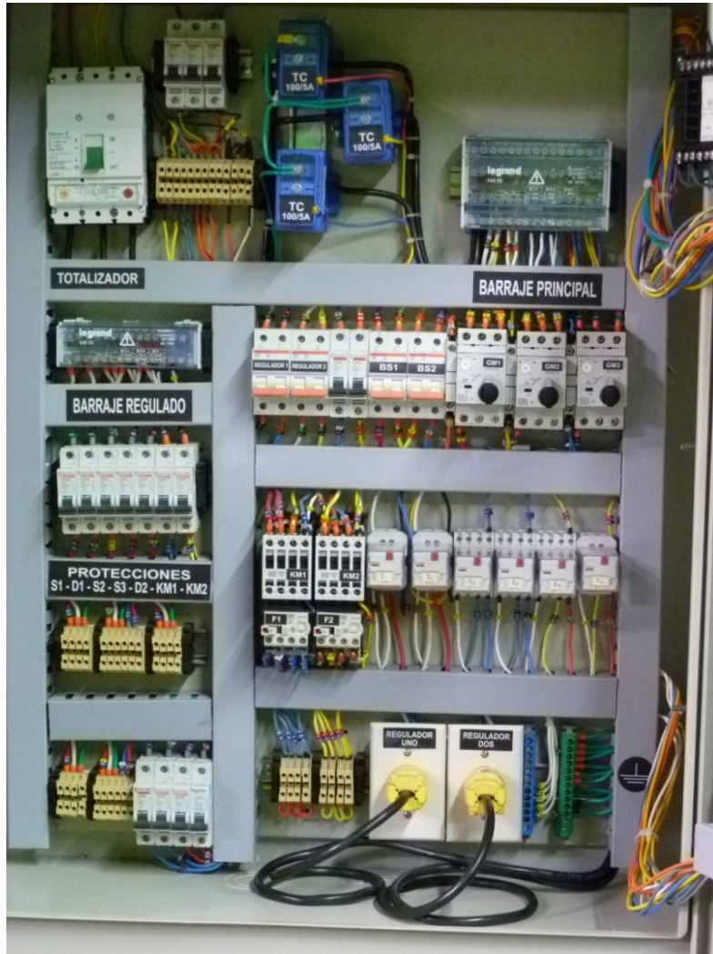
Figura 41. Tablero de control para estación de servicio. Vista interna. [10]
