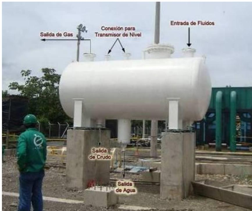
**Figura 5.** Separador Horizontal Ubicado en la Estación Castilla II – Ecopetrol
