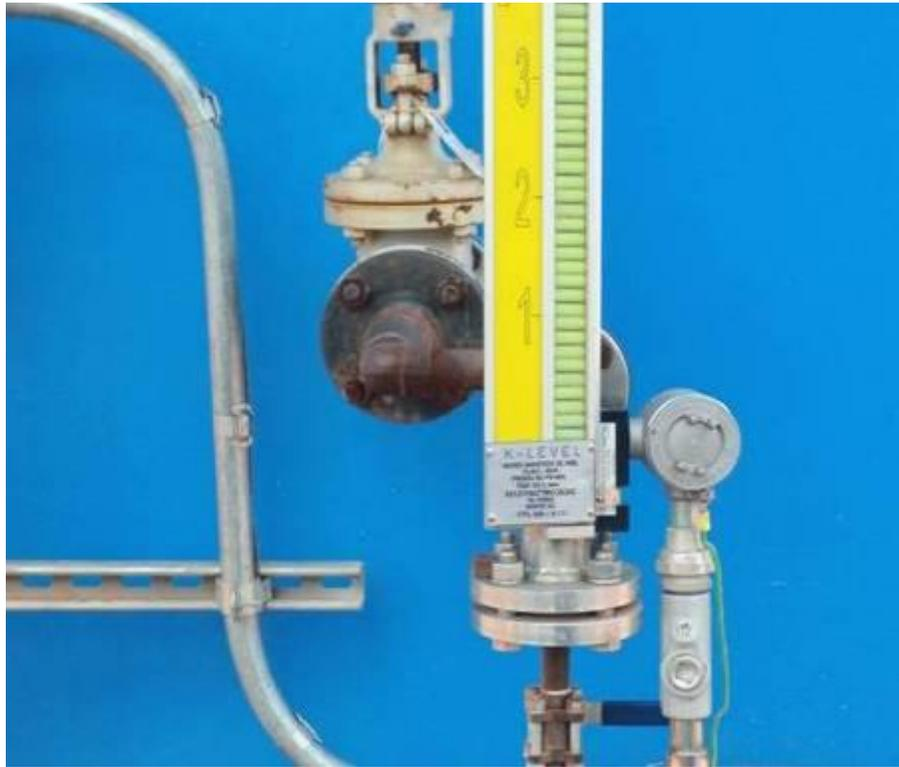
**Figura 16.** *Indicador de Nivel Local tipo Magnético Ubicado en la batería 4 de Capo Rubiales.*
