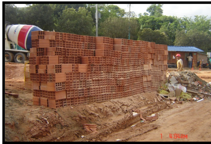
Fotografía 11. Almacenamiento de ladrillo en obra
