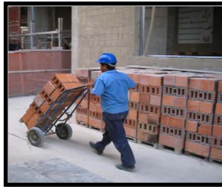
Fotografía 19. Transporte adecuado de ladrillo opción 2
