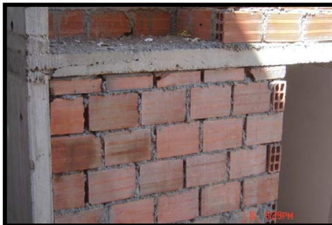
Fotografía 16. Corte de ladrillo en enrase de muro
