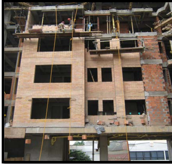
Fotografía 14. Ladrillos usados como plomos
