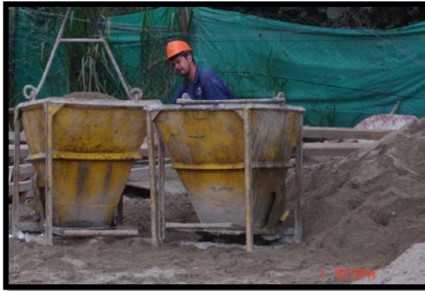
Fotografía 5. Transporte vertical de arena
