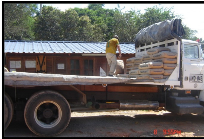
Fotografía 3. Descargue de cemento
