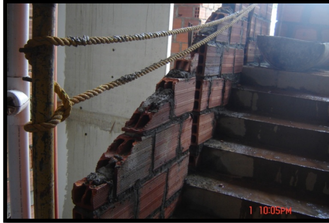
Fotografía 22. Desperdicio por geometría del muro
