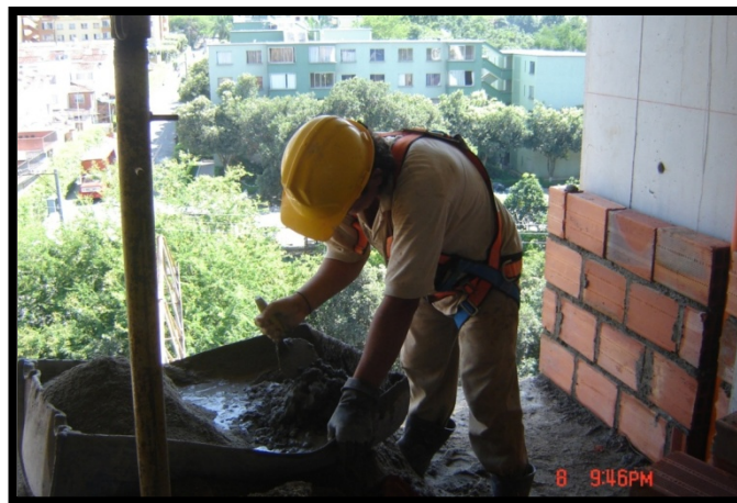
Fotografía 8. Preparación mezcla mortero
