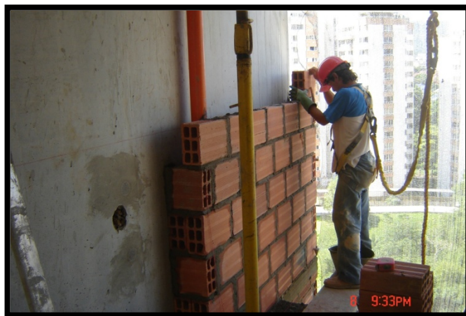
Fotografía 10. Construcción muro en mampostería H-10
