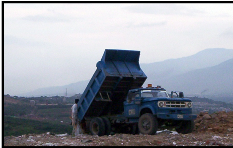
Fotografía 17. Ubicación de escombros en botadero autorizado
