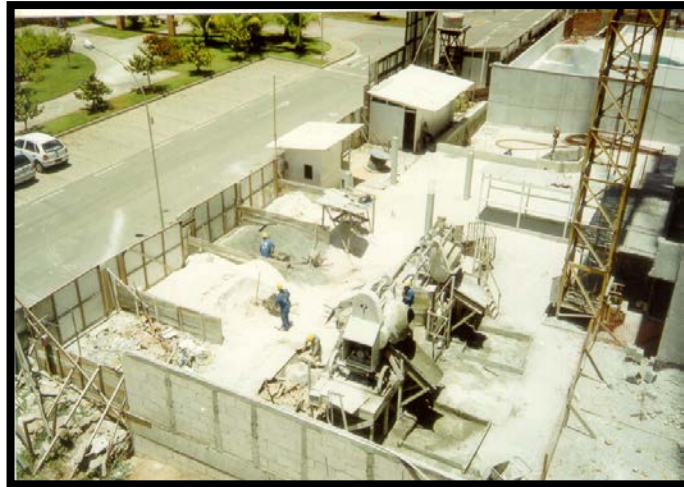
Fotografía 20. Mezcladora mecánica para mortero
