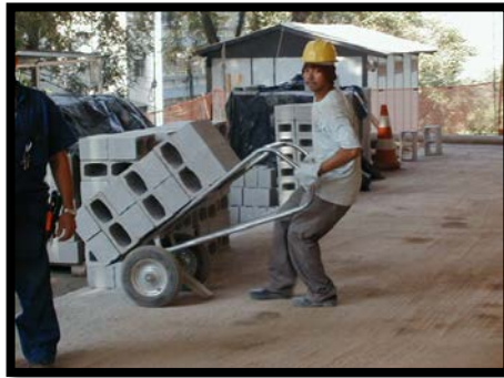
Fotografía 18. Transporte adecuado de ladrillo opción 1
