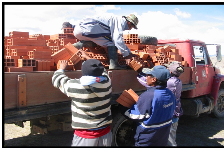
Fotografía 2. Descargue de ladrillo
