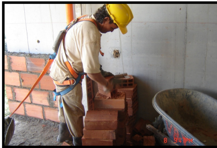
Fotografía 9 Corte de medios ladrillos
