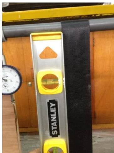
Figura 15. Nivelación de correas de fijación.
