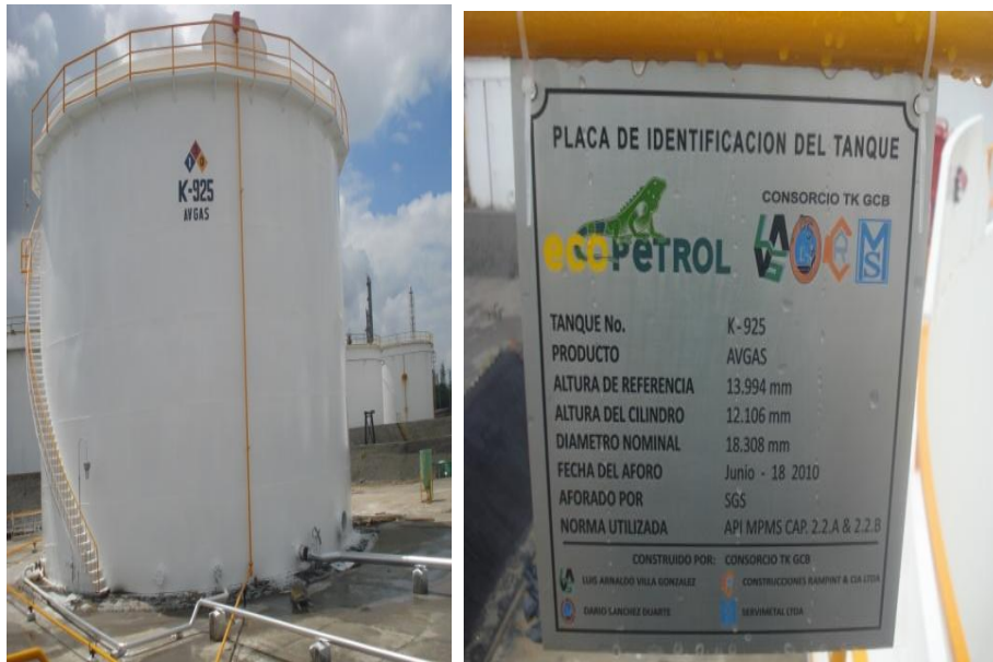
Foto 19. Tanques Terminado y Modelo de la Placa de Aforo de un Tanque
