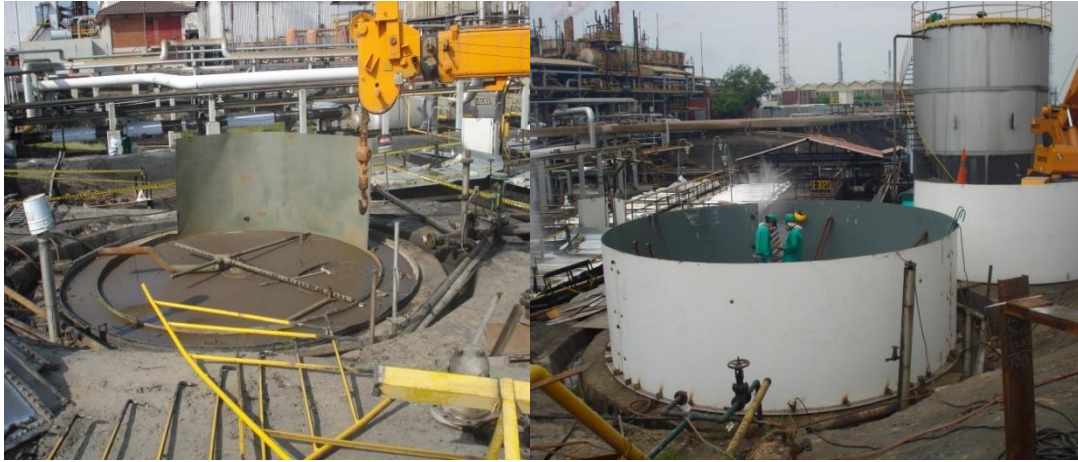
Foto 16. Desmantelamiento y Montaje de un Tanque
