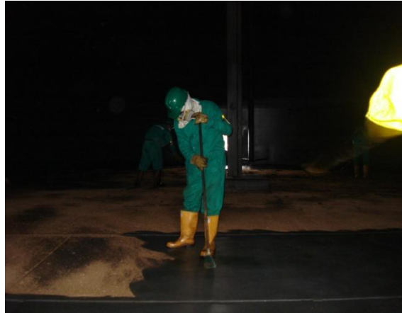
Foto 12. Limpieza Interna del Tanque
