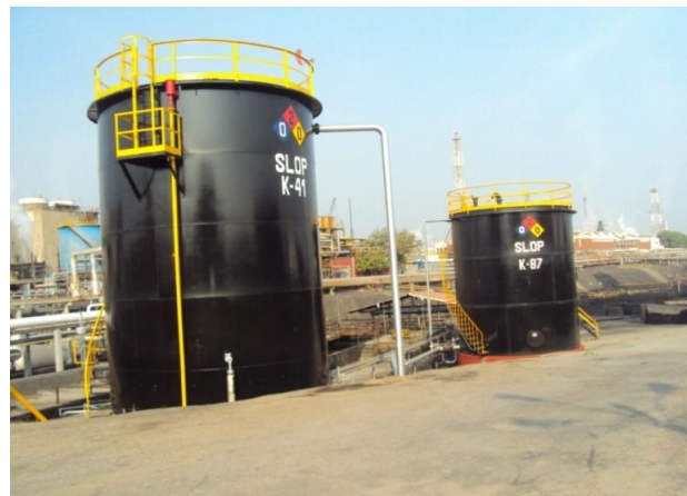
Foto 2. Tanques Cilíndricos Verticales
