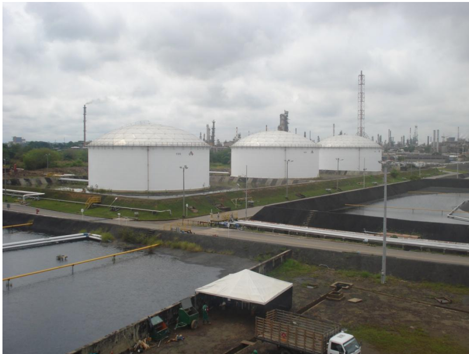
Foto 5. Tanque de Techo Geodésico o Domo
