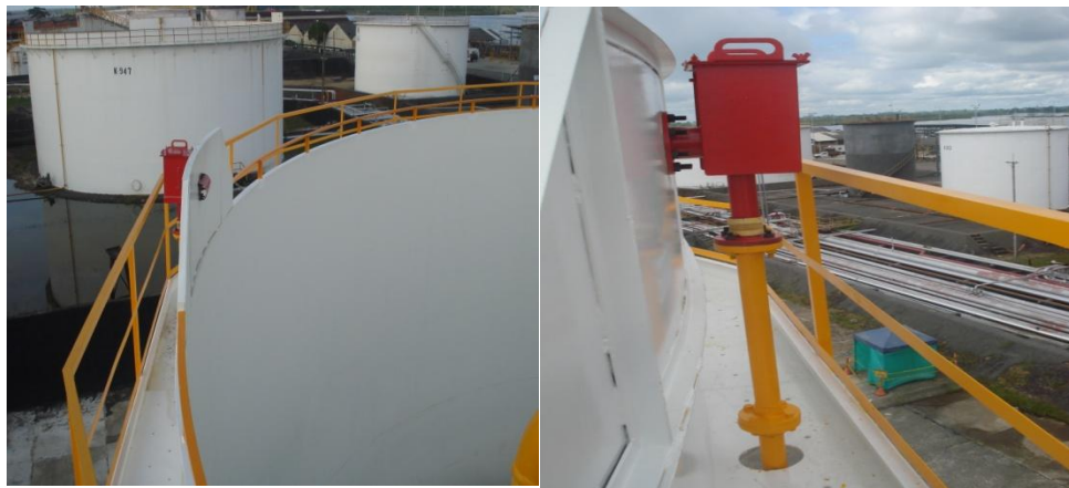
Foto 14. Cambio de Cámaras de Espuma
