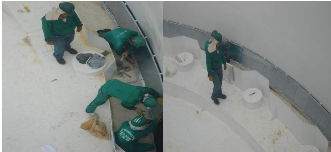
Foto 15. Instalación de Sellos Secundarios
