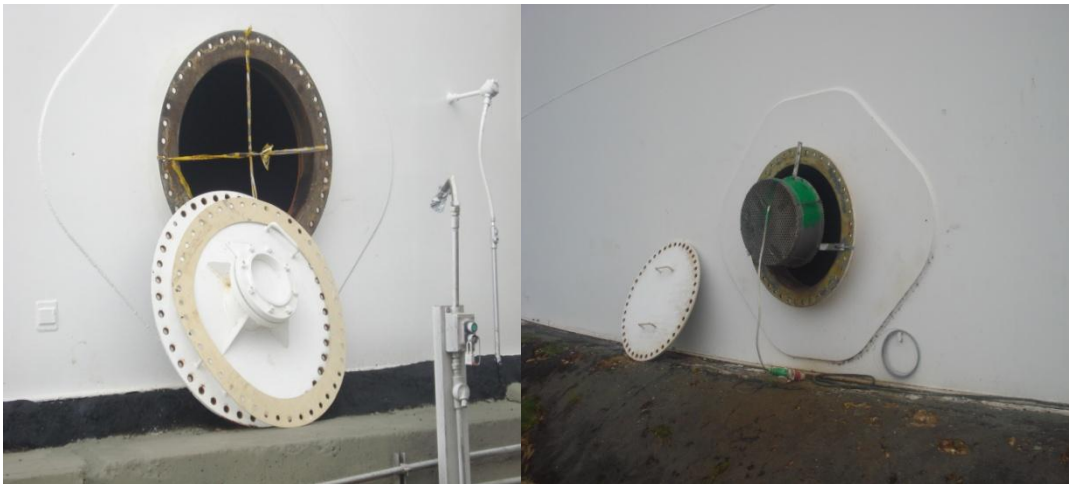
Foto 10. Apertura Manhole de Casco e Instalación de Extractor de aire
