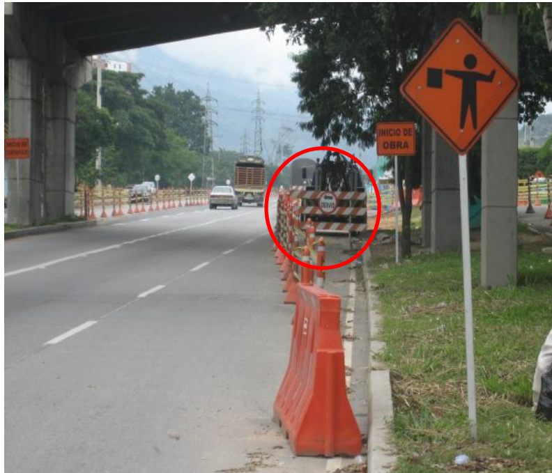
Figura 13. Autopista Floridablanca-Piedecuesta sentido norte-sur. K1+400
