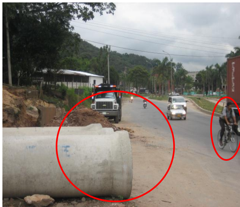
Figura 33. Autopista Floridablanca-Piedecuesta, sentido norte-sur. K5+250
