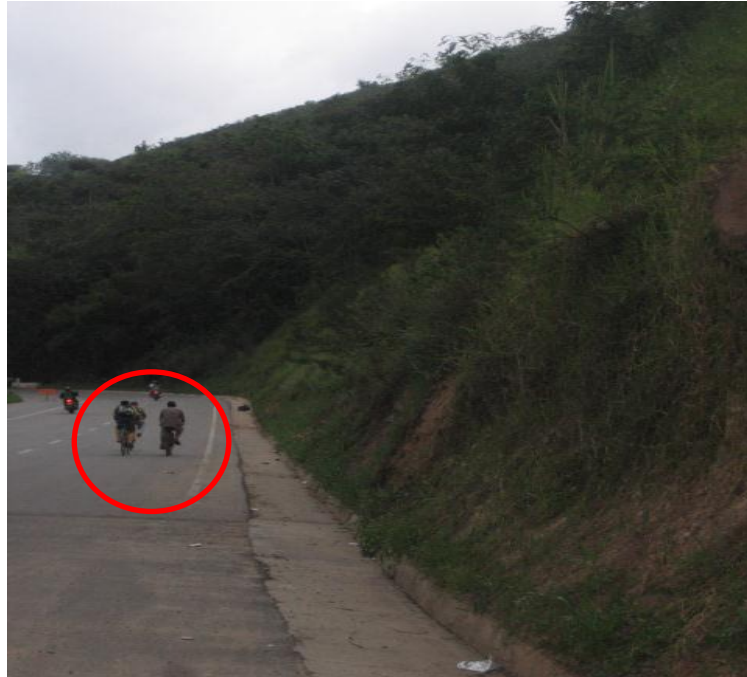
Figura 37. Autopista Floridablanca-Piedecuesta, sentido norte-sur. K5+900
