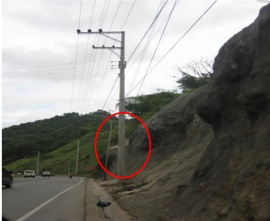
Figura 25. Autopista Floridablanca-Piedecuesta, sentido norte-sur. K3+430
