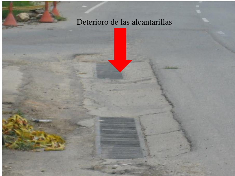
Figura 18. Autopista Floridablanca-Piedecuesta sentido norte-sur. K2+400
