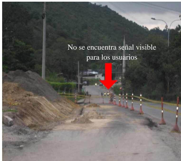
Figura 36. Autopista Floridablanca-Piedecuesta, sentido norte-sur. K5+620
