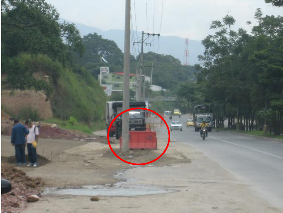
Figura 22. Autopista Floridablanca-Piedecuesta, sentido norte-sur. K2+930
