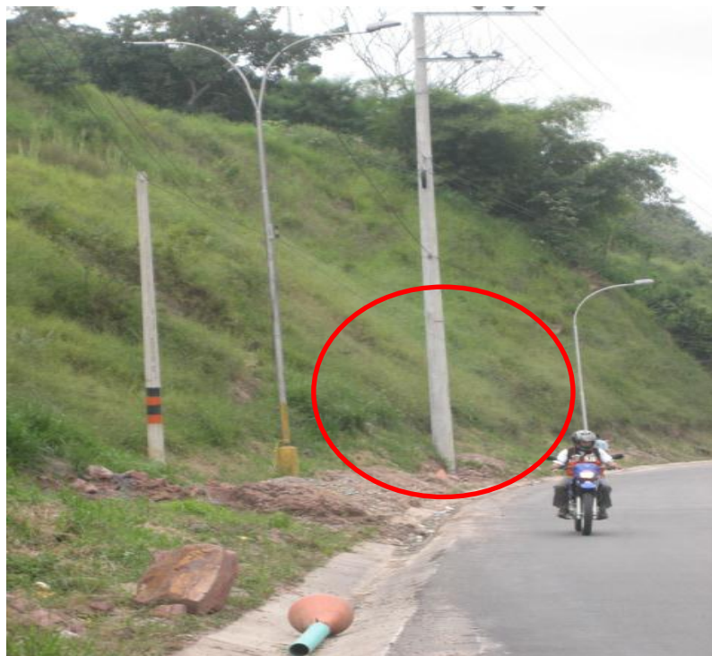
Figura 26. Autopista Floridablanca-Piedecuesta, sentido norte-sur. K3+600
