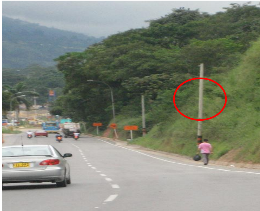
Figura 31. Autopista Floridablanca-Piedecuesta, sentido norte-sur. K5+100
