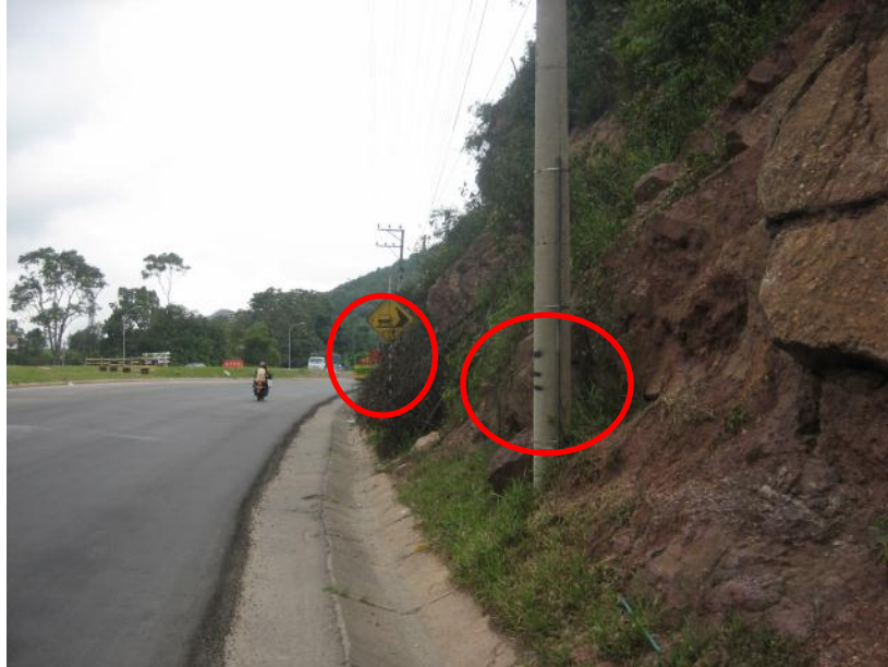
Figura 23. Autopista Floridablanca-Piedecuesta, sentido norte-sur. K3+200
