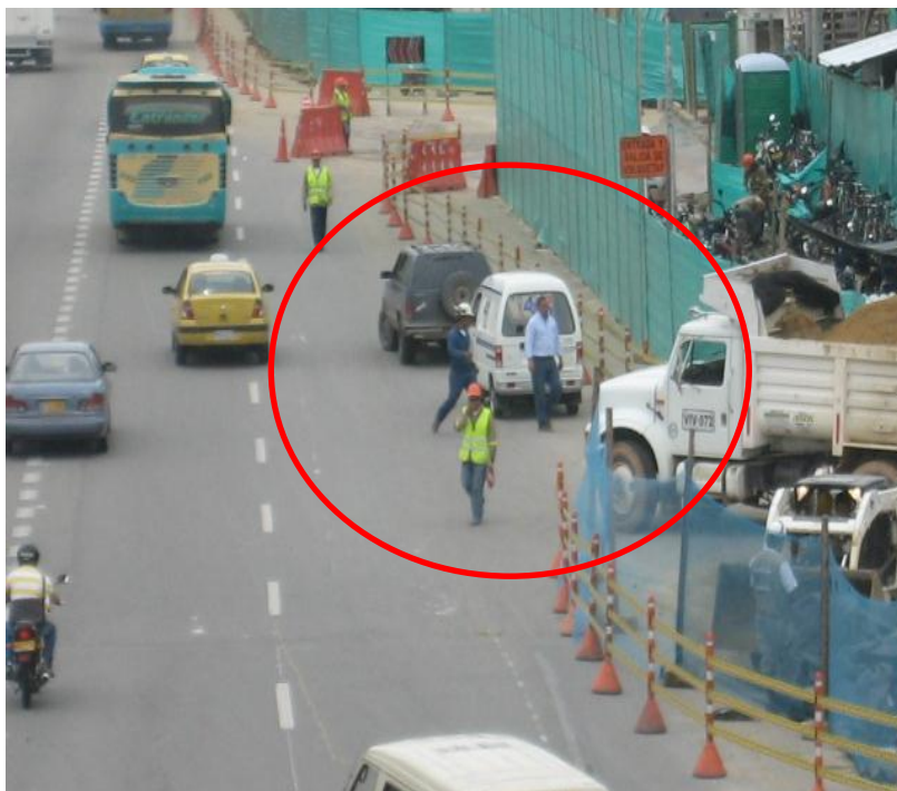
Figura 16. Intersección Autopista-Anillo vial. K1+500
