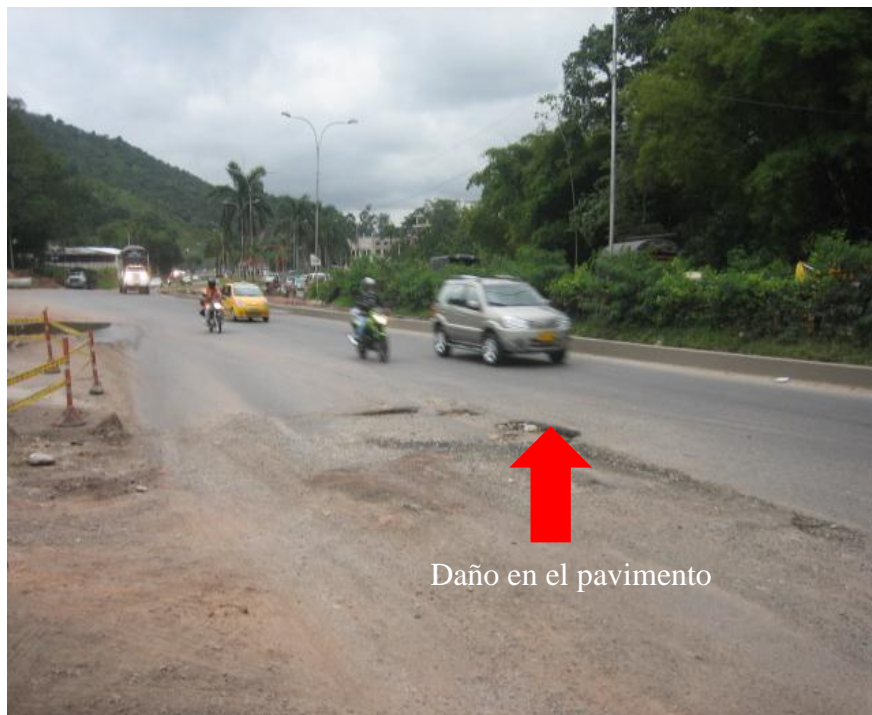
Figura 34. Autopista Floridablanca-Piedecuesta, sentido norte-sur. K5+300
