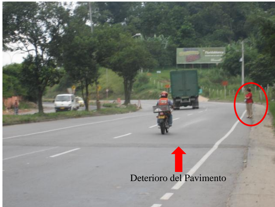
Figura 27. Autopista Floridablanca-Piedecuesta, sentido norte-sur. K4+100
