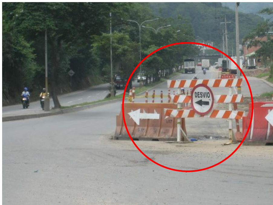
Figura 21. Autopista Floridablanca-Piedecuesta, sentido norte-sur. K2+415
