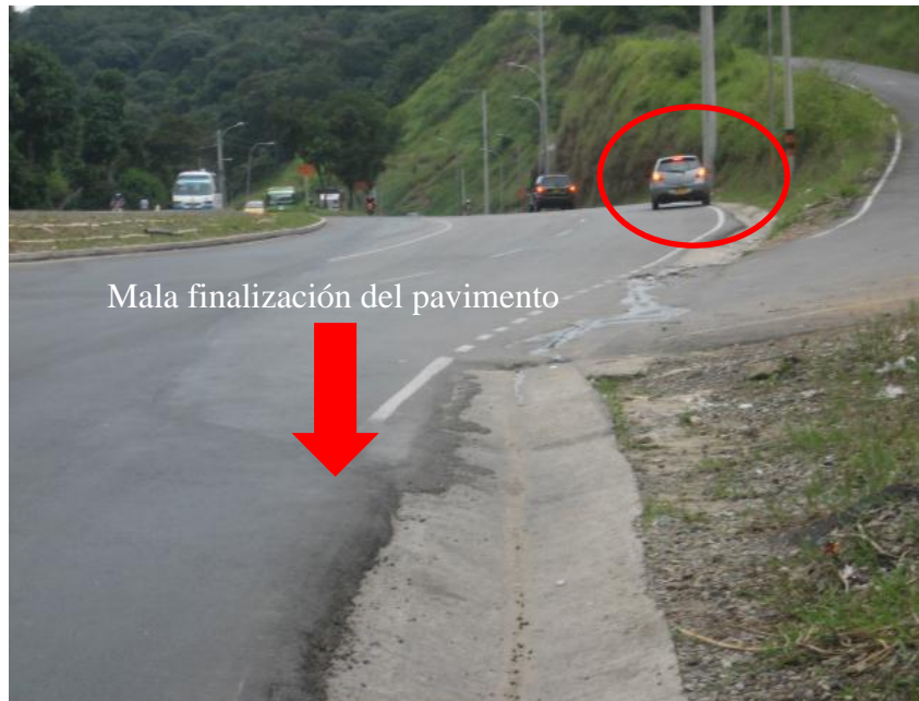
Figura 24. Autopista Floridablanca-Piedecuesta, sentido norte-sur. K3+300
