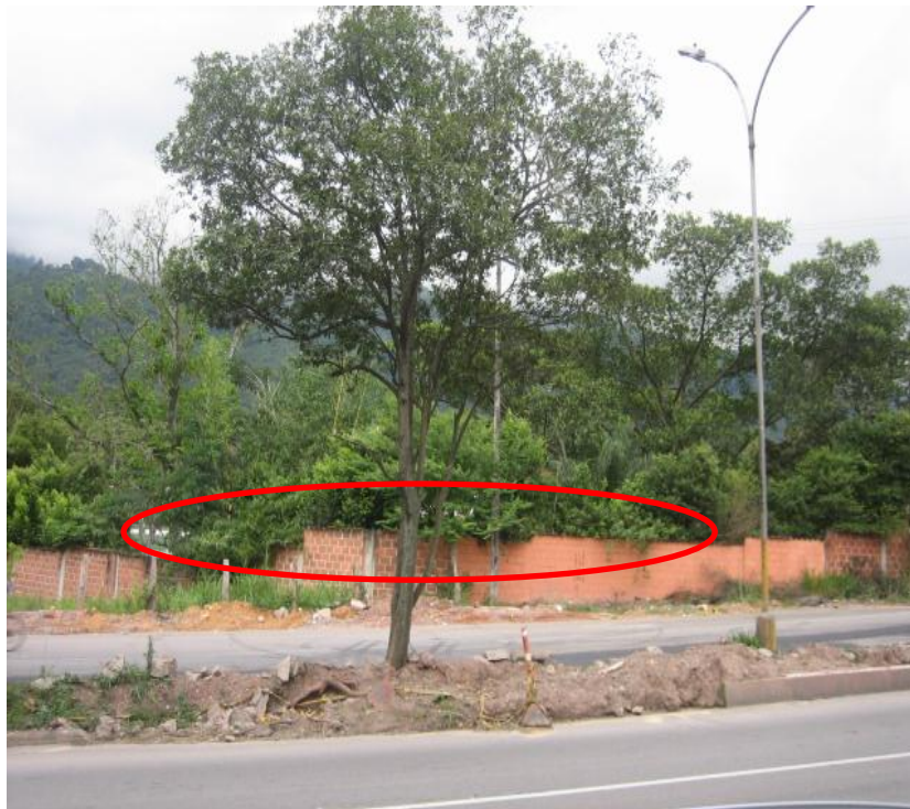
Figura 29. Autopista Floridablanca-Piedecuesta, sentido norte-sur. K4+350
