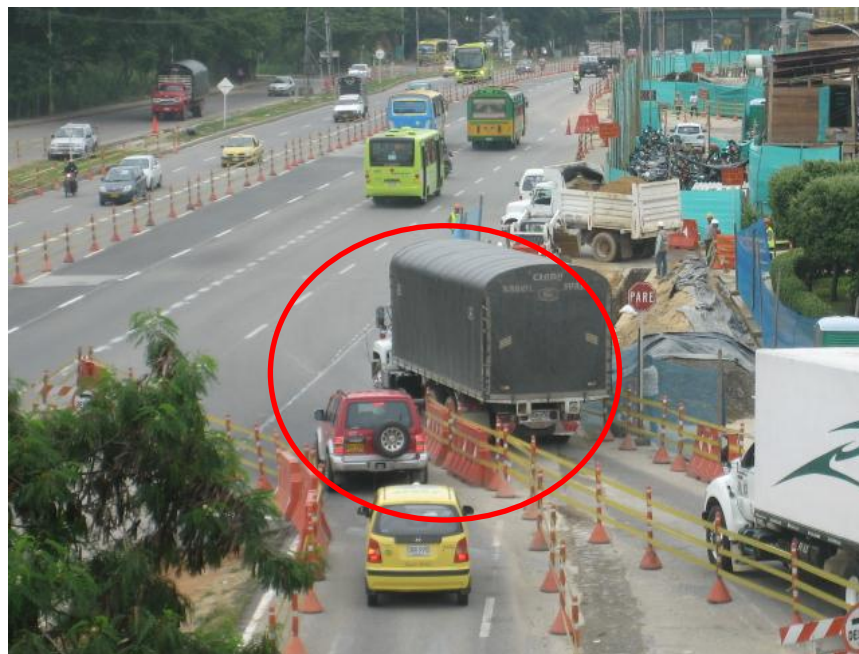
Figura 15. Vista desde el puente vial de Floridablanca-Anillo vial. K1+500
