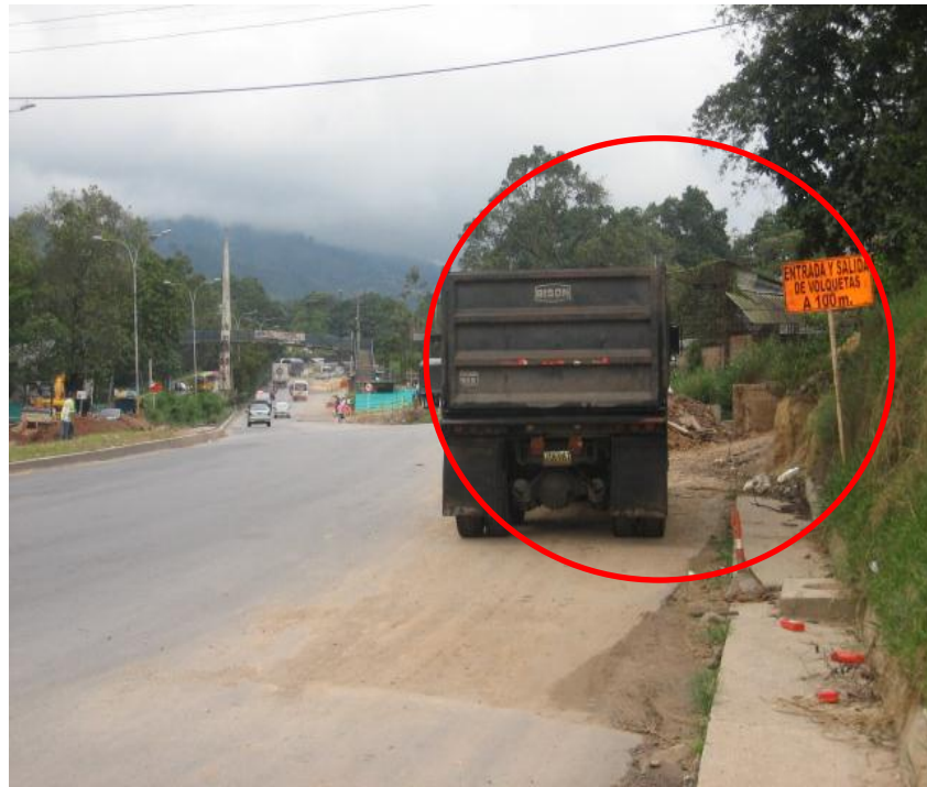
Figura 32. Autopista Floridablanca-Piedecuesta, sentido norte-sur. K5+200
