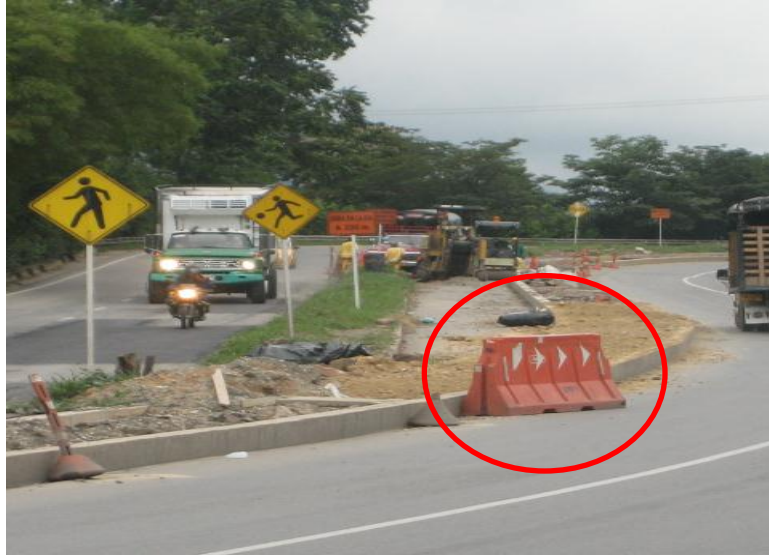
Figura 28. Autopista Floridablanca-Piedecuesta, sentido norte-sur. K4+300
