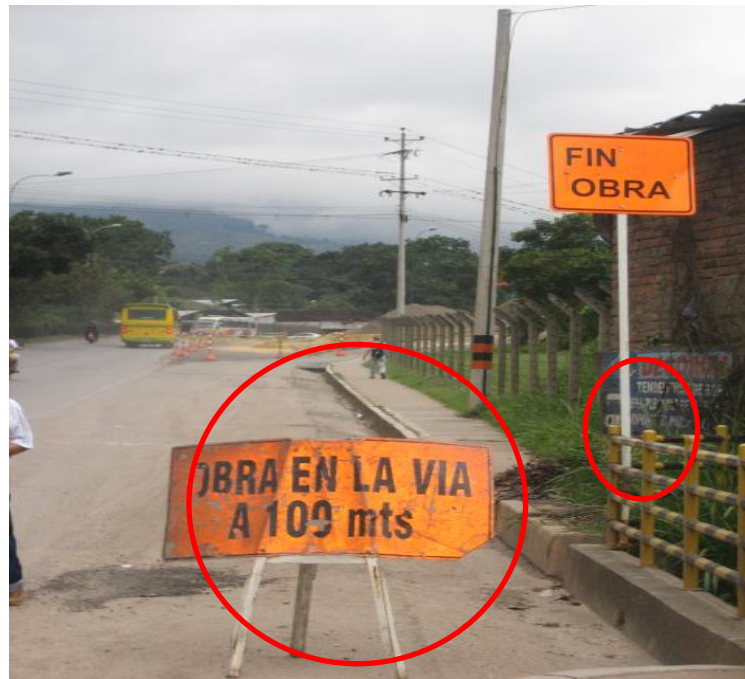
Figura 35. Autopista Floridablanca-Piedecuesta, sentido norte-sur. K5+400
