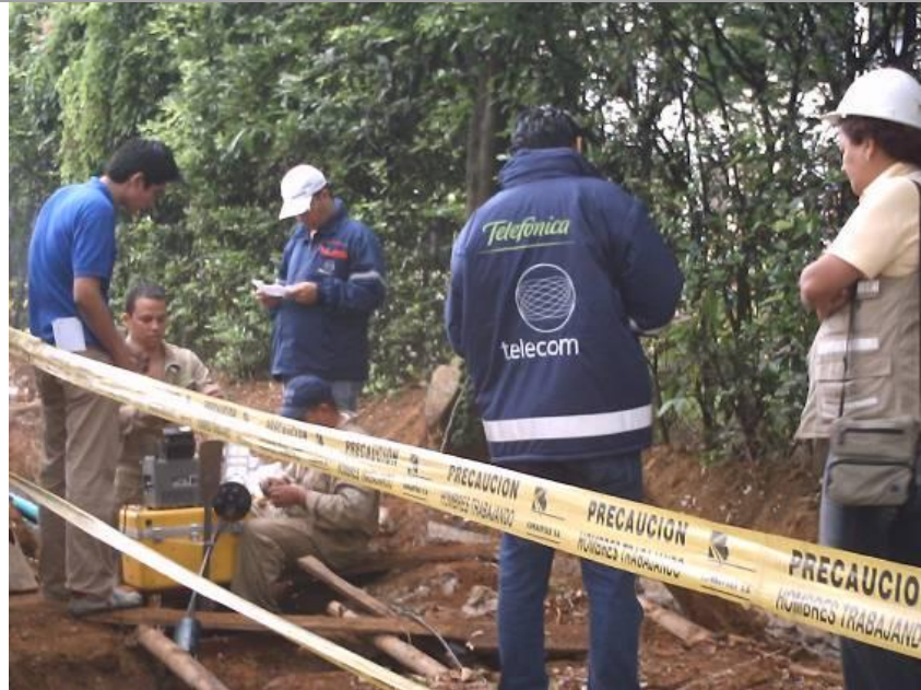
Fotografía 8. Responsables de los trabajos por INGACON y Telefónica Telecom
