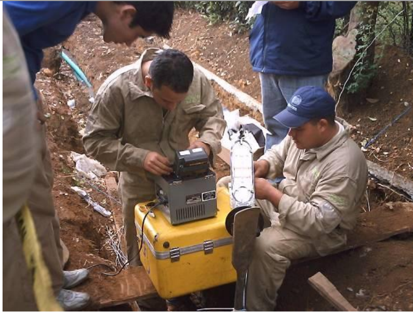
Fotografía 7. Empalme de las fibras en servicio
