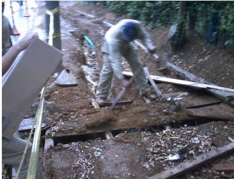
Fotografía 3. Excavación en donde ocurrió el corte
