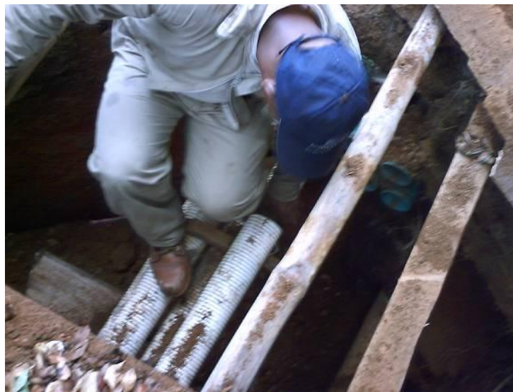
Fotografía 4. Adecuación del sitio para los trabajos de recuperación de servicio
