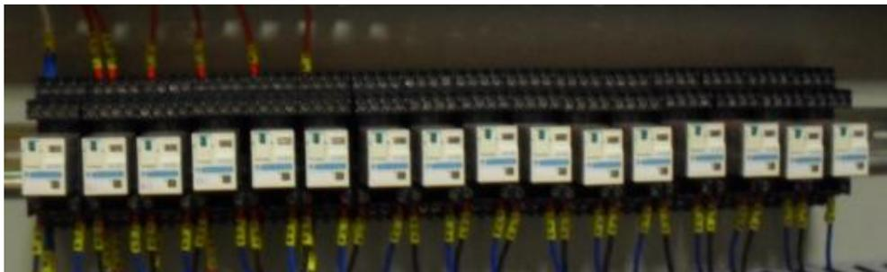
**Figura 34.** Acondicionamiento de señal gabinete central.
