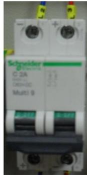
**Figura 40.** Disyuntor Bipolar C2A gabinete remoto.
