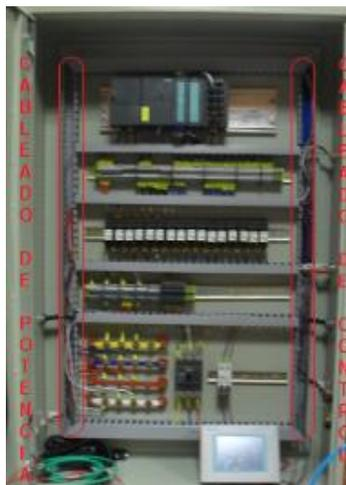
**Figura 28.** Cableado de Control y potencia.
