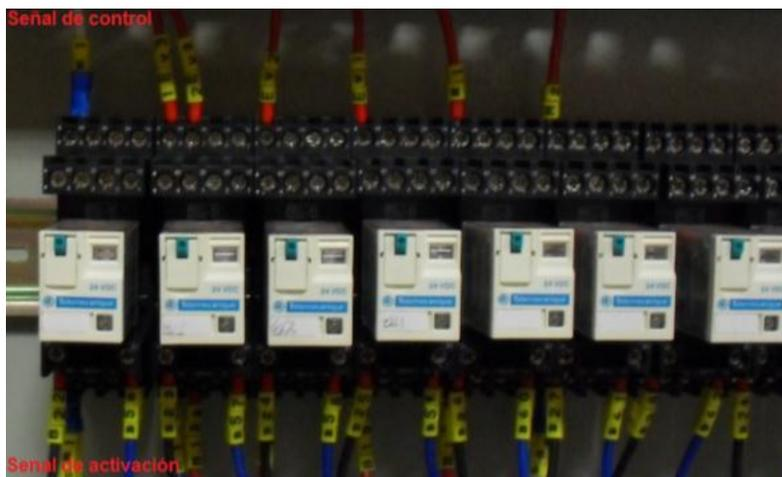
**Figura 62.** Señal de activación y salida del relé.
