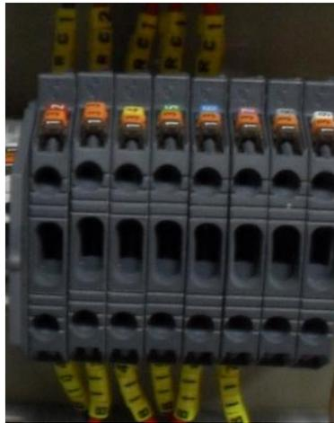
**Figura 63.** Protección por medio de fusibles.
