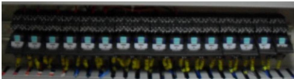
**Figura 35.** Acondicionamiento de señal gabinete central.
