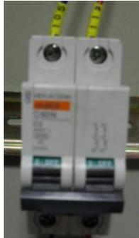
**Figura 39.** Disyuntor Bipolar C60N gabinete central.
