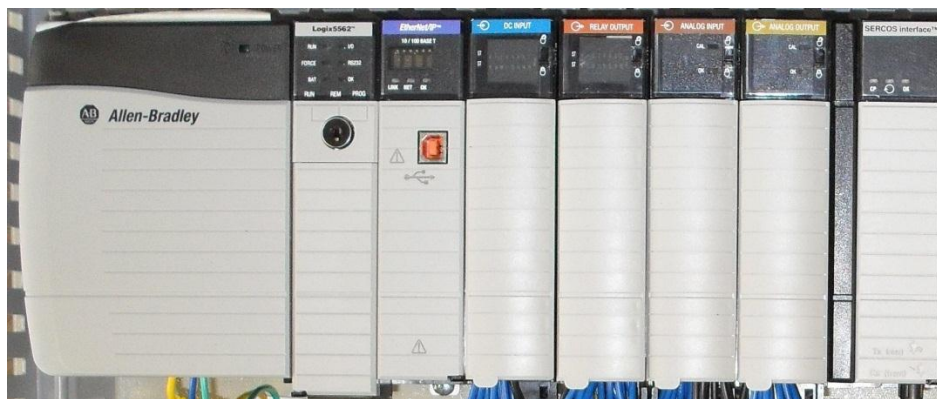
Figura 15. ControlLogix 5562 en Slot 1 del Chasis. [4]
