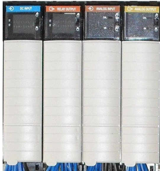
Figura18. Módulos de Entradas y Salidas Análogas y Digitales. [4]
