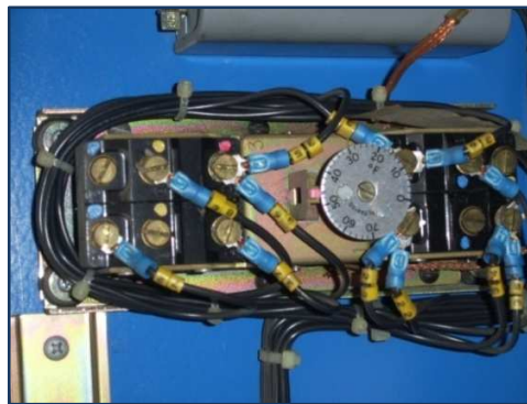
Figura 17. Circuito implementado Control Chiller
