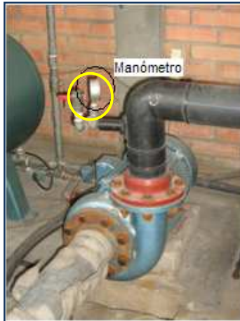
Figura 14. Manómetros en ciclo de condensación
