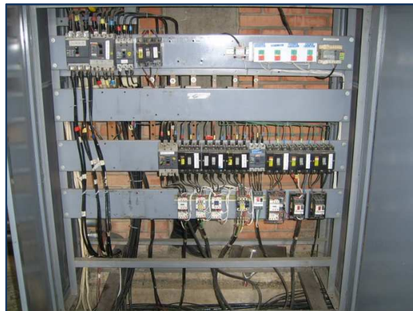
Figura 12. Sistema de Control implementado con lógica cableada
