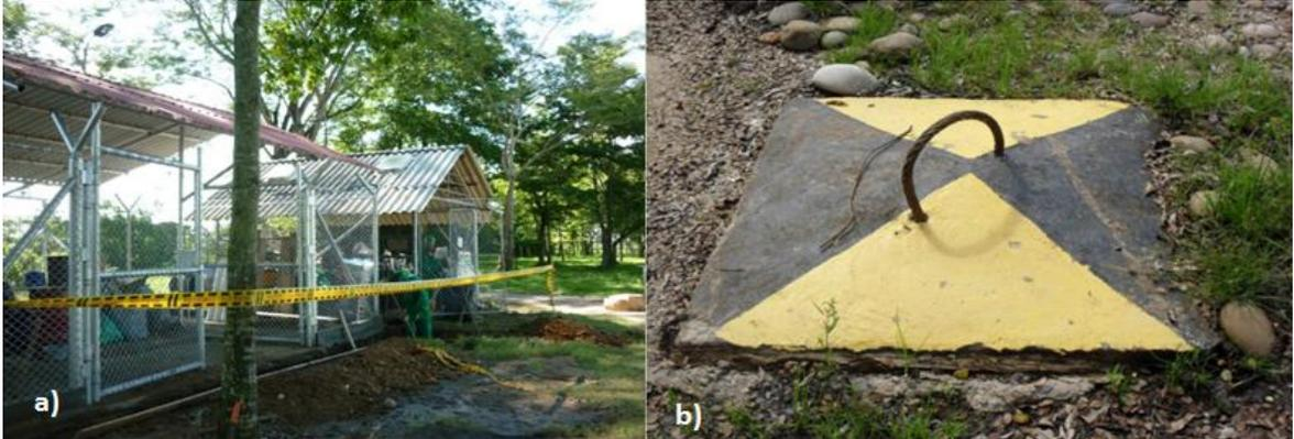
**a) CARSI y b) anclaje o peso muerto de izaje de las estructuras de mantenimiento y adecuación de pozos.**
