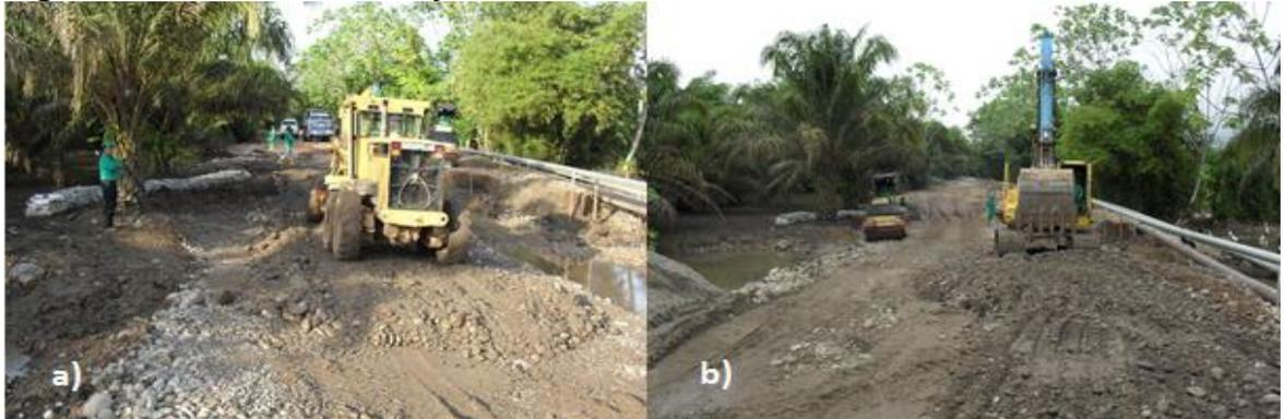
**a) Motonivelación del crudo y b) vibración y esparcimiento del material granular.**
