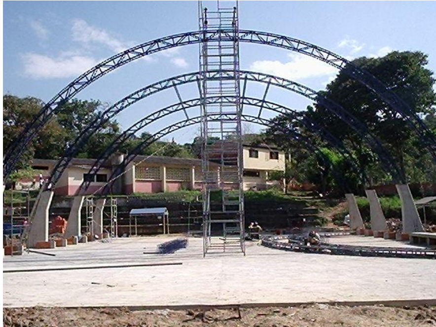
Foto. 13. Montaje de las cerchas de cubierta
