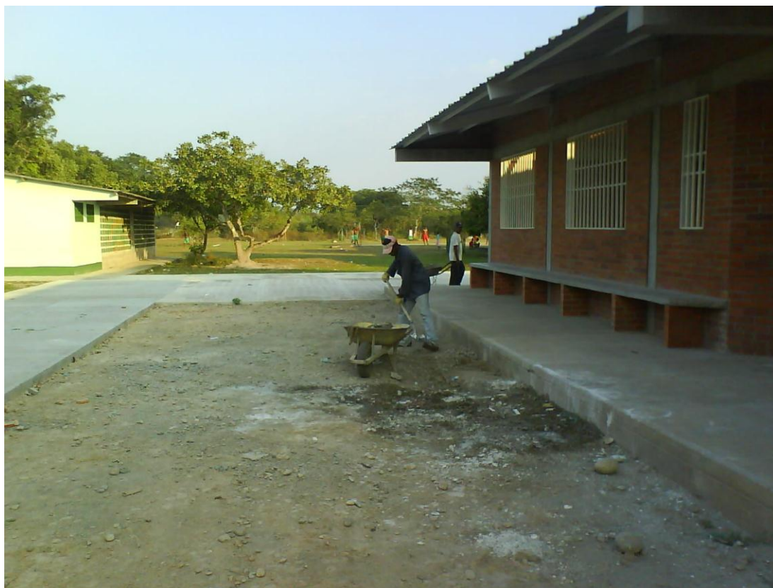
Foto. 6. Panorámica construcción Colegio San Bernardo
