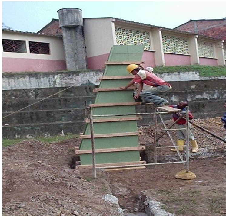
Foto 18. Armada de columnas
