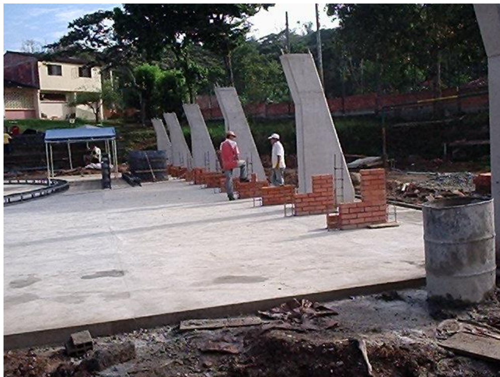
Foto.19. Construcción de la gradería
