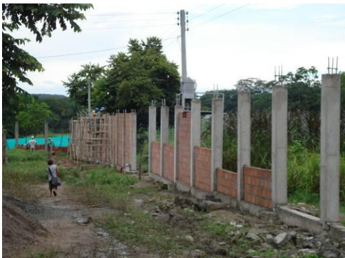
Relleno Aula Multifuncional
