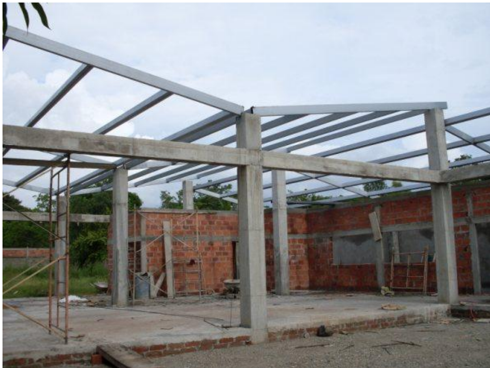
Foto 1. Panorámica de las aulas en construcción
