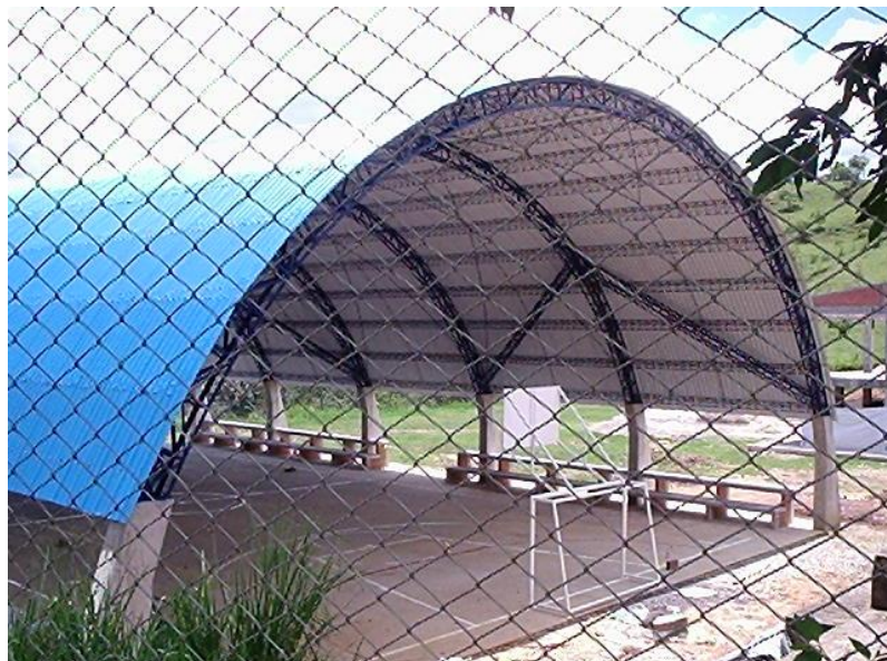
Foto 13. Coliseo columnas en concreto y estructura metálica
