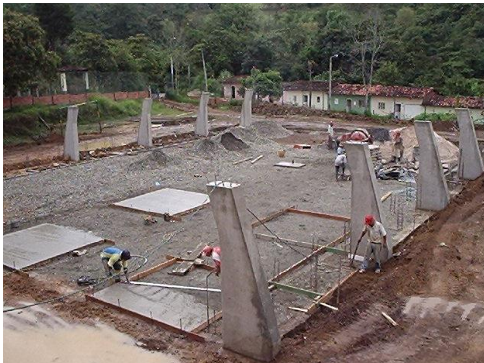
Foto.16. Fundición de la losa de contrapiso
