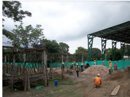
Zona de Restaurante Escolar.
