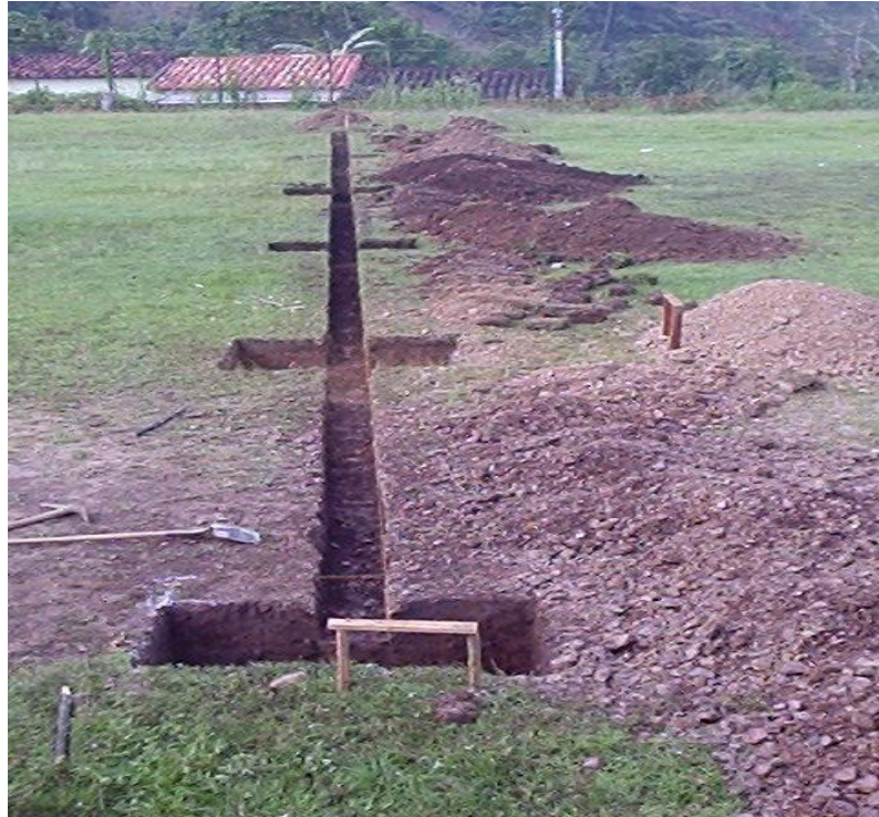
Foto. 17. Cimentación del Coliseo de Ocamonte
