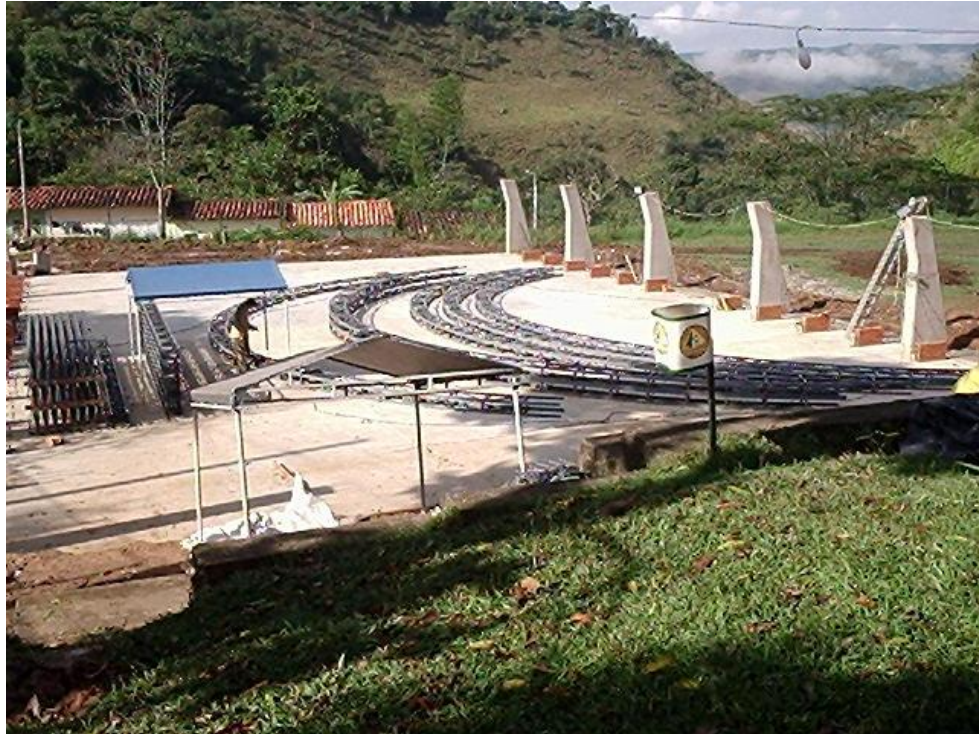
Foto.15. Panorámica de las columnas fundidas y de las cerchas
