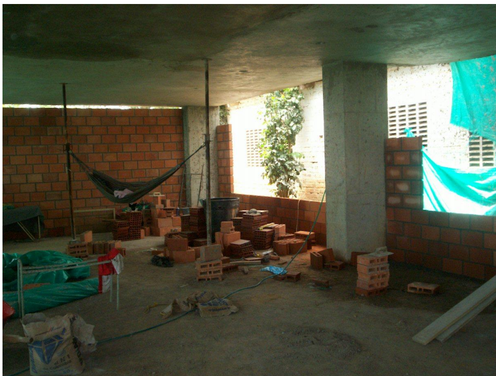
Foto.4.Panorámica de la construcción Colegio Puerto Parra
