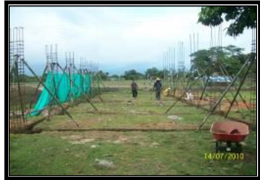
Refuerzo Aulas Pre-escolar
