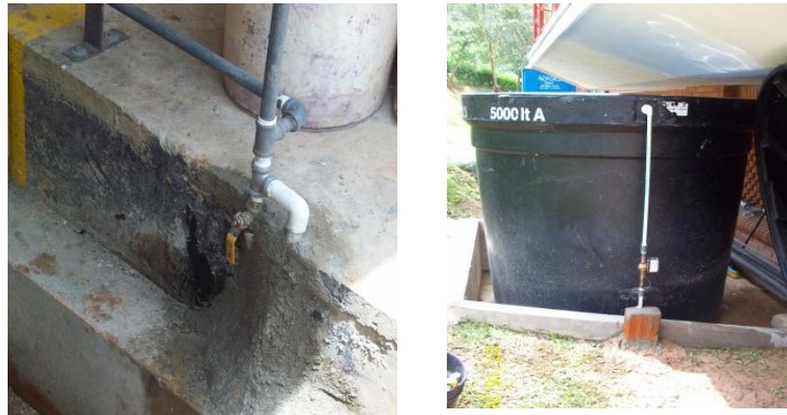
Ilustración 10.Acople tubería llenado del tanque
