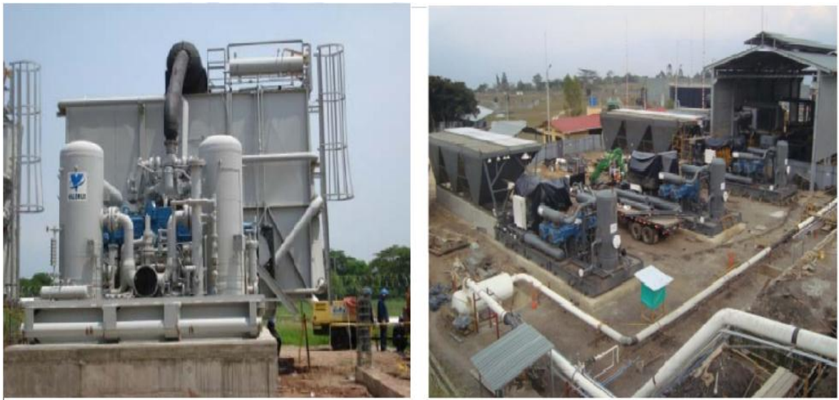
Figura 5. Unidades compresoras Centrifugas.
