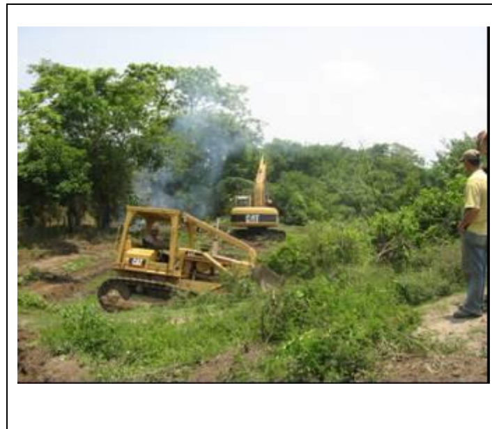
. Labores de descapote para cambio de alineamiento dique de entrada a San Antonio
