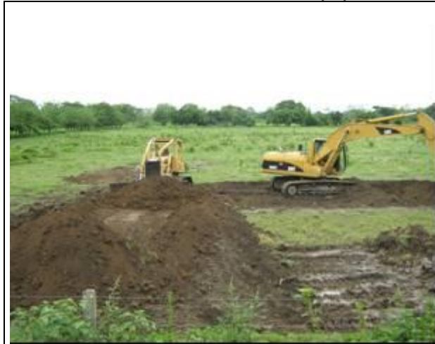
Actividad de repaleo de material en zona del dique
